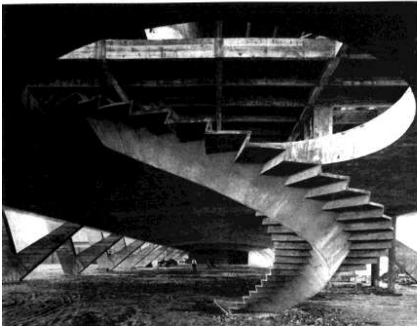
Concretagem da estrutura. Abaixo, vistas do térreo, com escada em primeiro plano. Above, the pouring of structural concrete. Below, a ground floor view, the stairs in the foreground.
