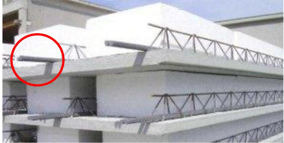
L'armatura di intradosso è solitamente costante su tutta la lunghezza del travetto e si interrompe in prossimità degli appoggi
