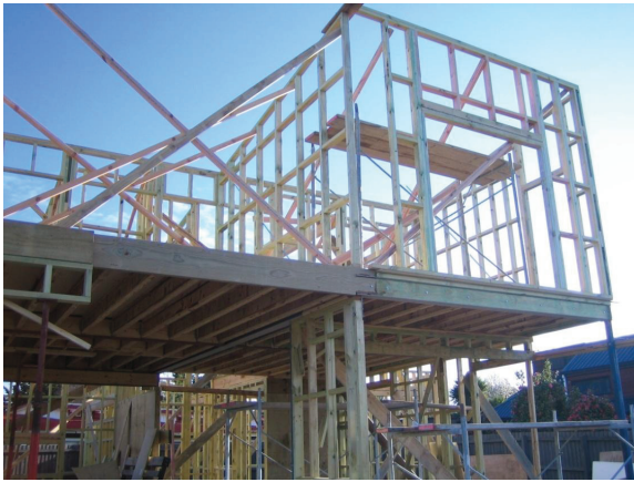
Struttura leggera intelaiata
