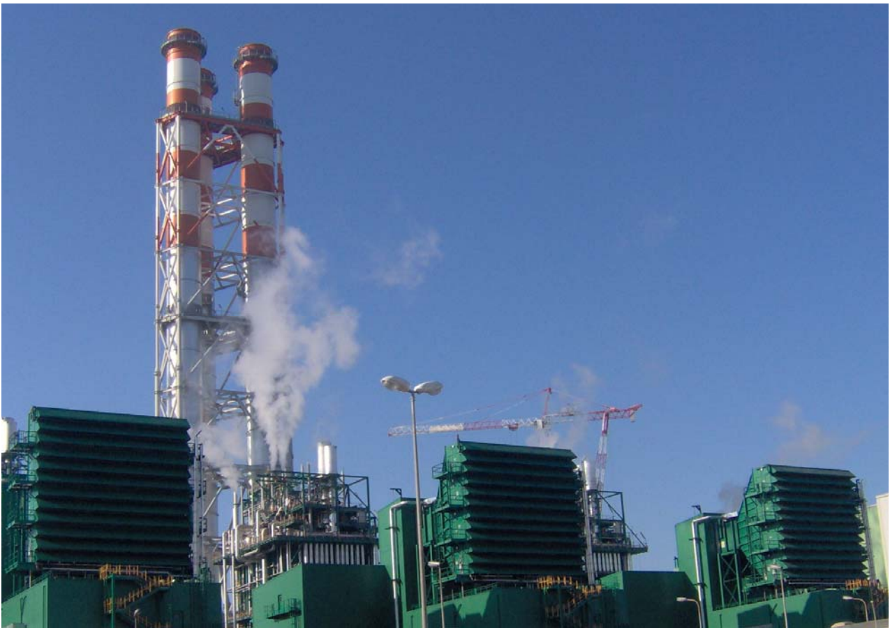
Camere filtri di 3 turbogas General Electric per cicli combinati
