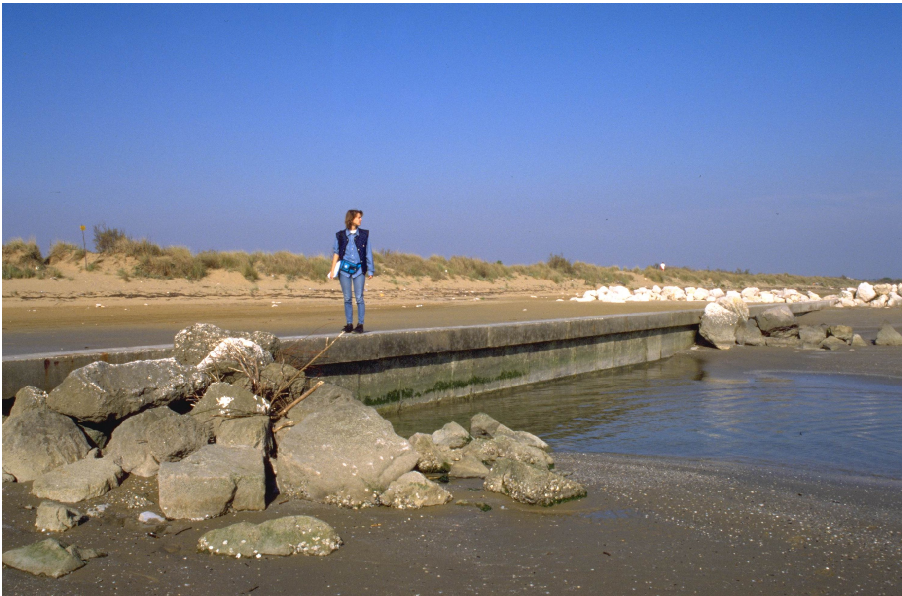
Muro paraonde (palancola cementizia) Laguna del Morto (ERACLEA)
