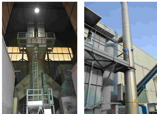
Figura 102 Punti di campionamento sulle capannette (sinistra) e sull'impianto trattamento lamiera (destra)
