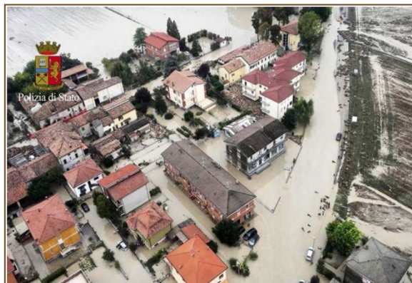
Foto 2.3.2 – Piacenza: vista dall'alto della zona di Roncaglia, con esondazione del fiume Trebbia
