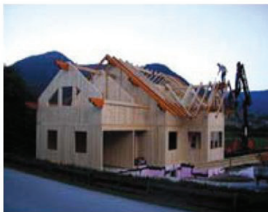
Abitazione unifamiliare – Wörschach (A)
