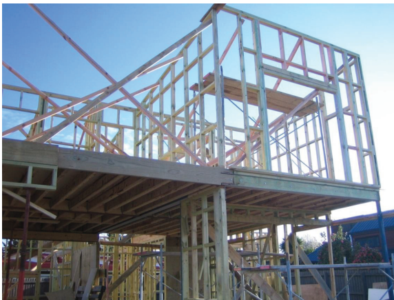
Struttura leggera intelaiata
