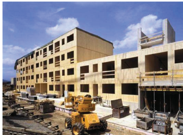
Struttura a pannelli XLam
