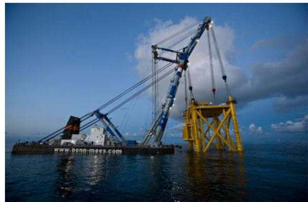
Figura 169 - Varo con crane barge
