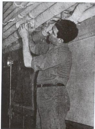
Coibentista addetto al rivestimento di tubazioni in un corridoio. Mulliro, Zaccari, Il lavoro portuale, Pella, 1956.
