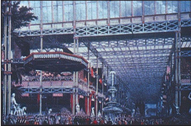
Paxton's Crystal Palace (1851): ossatura portante con colonne in ghisa, travi reticolari in ghisa e in ferro pudellato.
