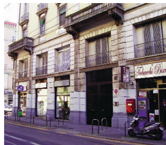
Questa entrata, posizionata tra i negozi e ben visibile dalla strada, è un luogo piuttosto sicuro
