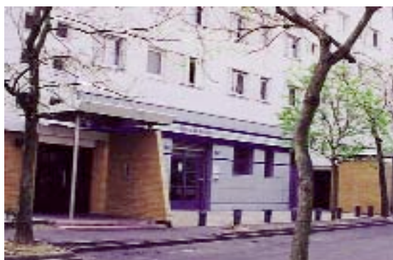
Il progetto di riqualificazione di questo edificio di edilizia pubblica prevede la creazione di locali al piano terra destinati a spazi informativi e di assistenza per i residenti © IAU île-de-France
