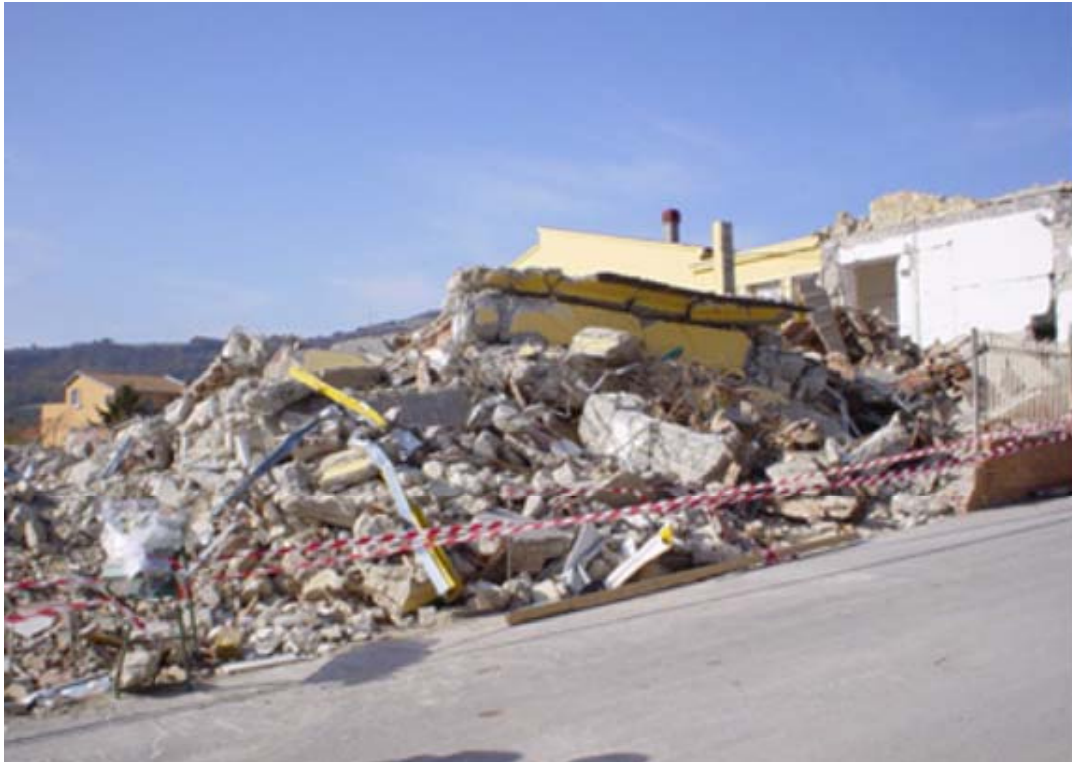
Crollo scuola Jovine ( ottobre 2002 ) – 28 morti
