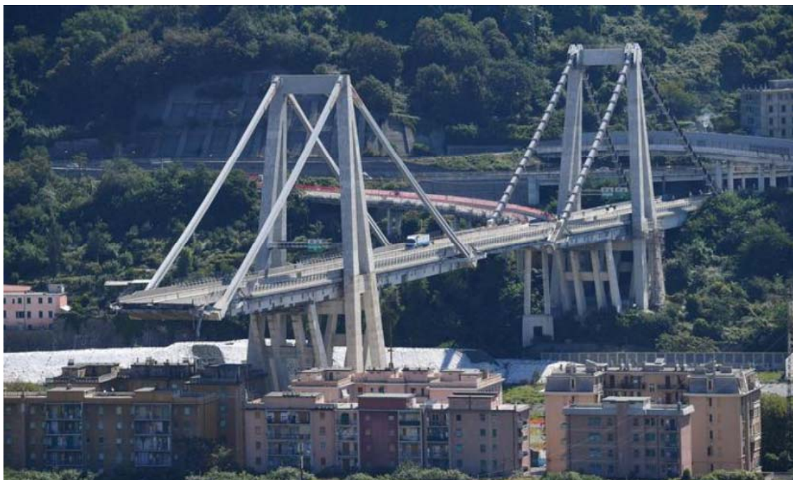
Viadotto sul Polcevera – Genova (ago. 2018)
