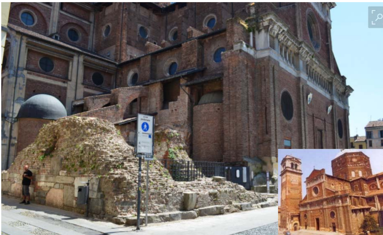
Crollo Torre Civica ( marzo 1989 )
