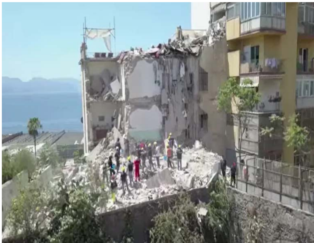
Crollo durante la notte (luglio 2017) – 8 morti (fam. tecnico comunale)
