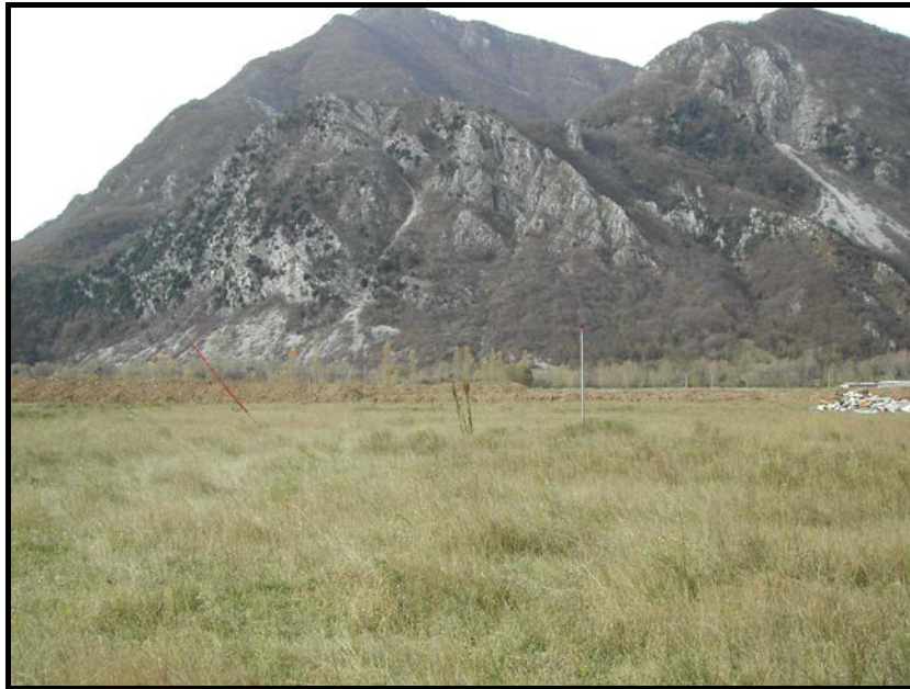
Fig. 6.38: Immagine della zona di intervento. Vista da Nord-Est
