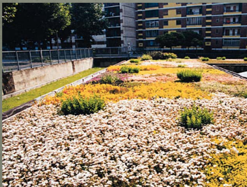
Copertura garage seminterrato
