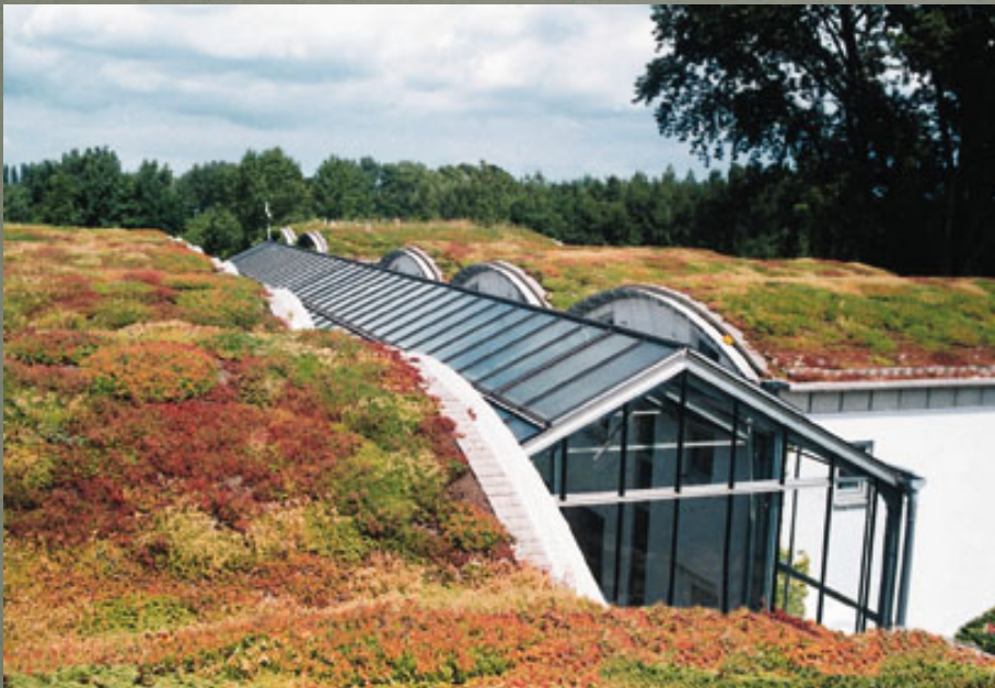
Coperture palazzine private di un villaggio
