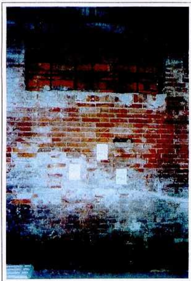
Foto 3: veduta della porzione muraria su cui è stato condotto il prelievo di campione di alettamento PA.2
