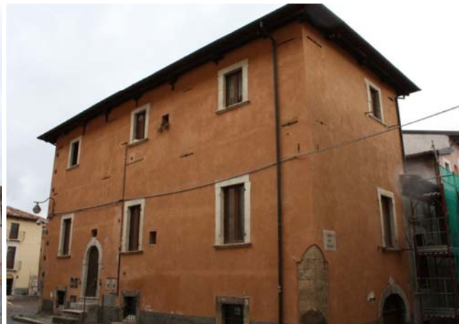
L'Aquila 2009 Edificio ben legato
