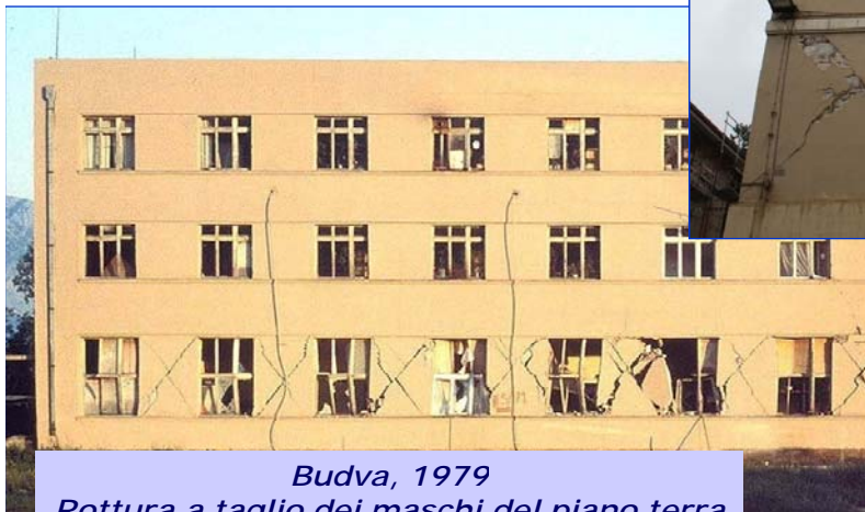
L'Aquila, 2009 Fessurazione diagonale maschi
