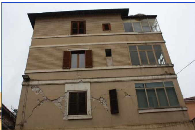
L'Aquila, 2009 Fessurazione diagonale maschi
