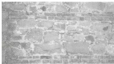
Blocchi di pietra grezza con ricorsi di mattoni (murat. listata)
