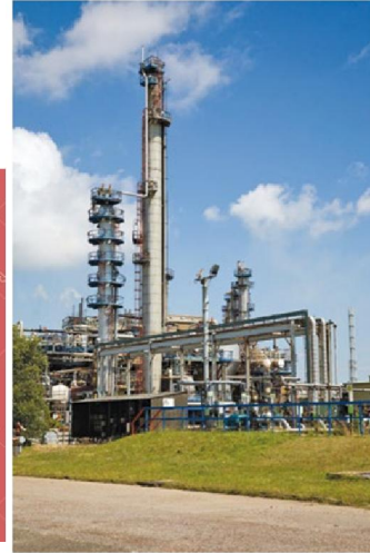
Figura 5C.8 L'altezza di questa colonna di frazionamento in una raffineria aiuta a ottenere una buona separazione dei componenti del petrolio. (© Pablo Paul/Alamy.)
