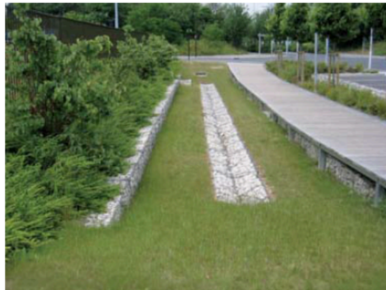
Tranchée drainante et noue de rétention, Noisy le grand
