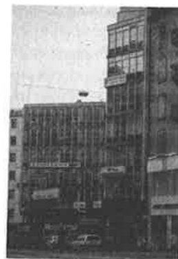
Marc-Joseph Saughey, Mont Blanc Centre a Ginevra, 1951-1953. Il sito prima dell'intervento.
