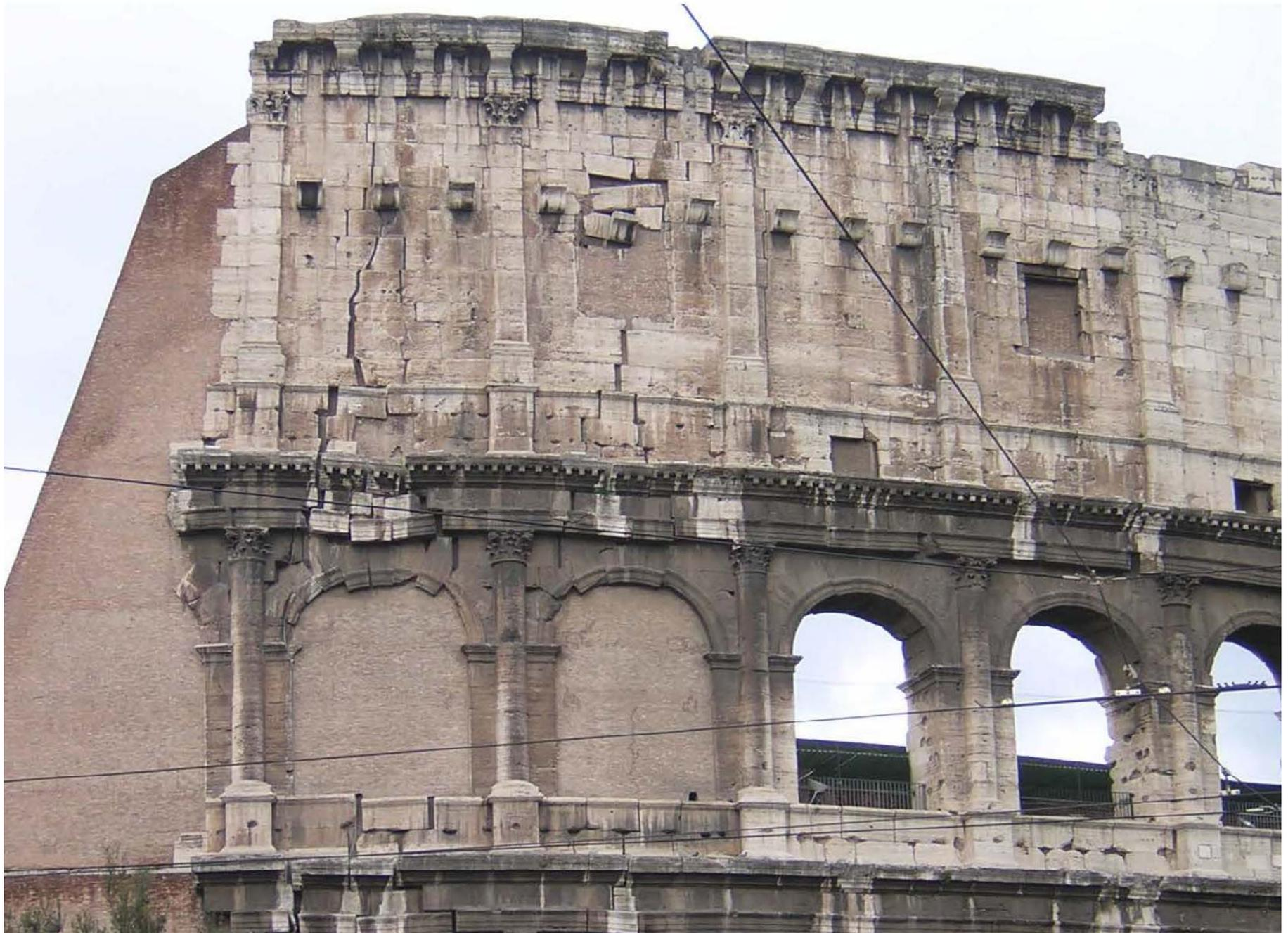
Ricorrendo a un espediente tecnico di limitata invasività strutturale, Stern costruì inoltre uno **sperone** di appoggio all'estremità delle arcate, che essendo incomplete e quindi prive di sostegno, necessitavano un consolidamento.
