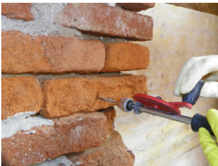
Figura 3 • L'operatore predisporre con trapano a mano i fori che ospiteranno le imperniature.
