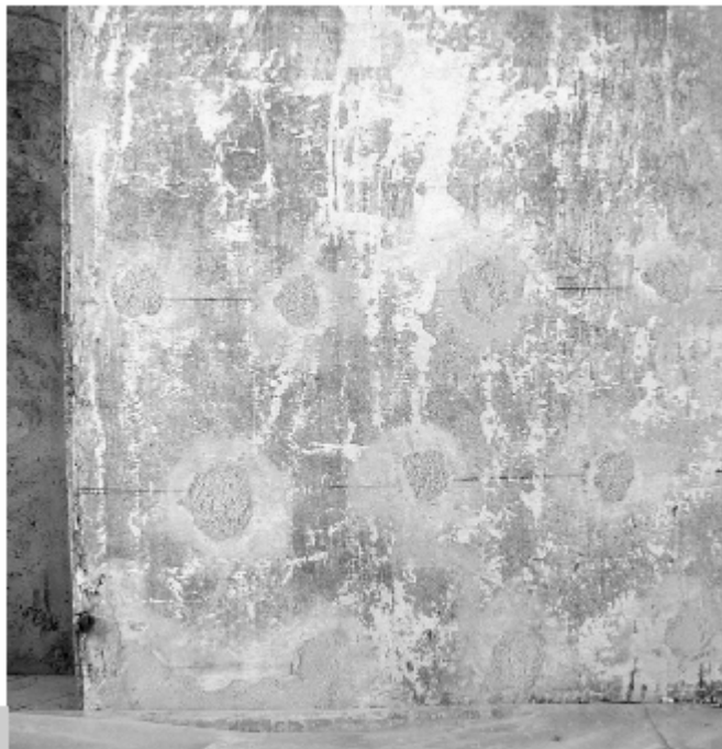
Figura 10 • Stuccatura dei fori di iniezione.
