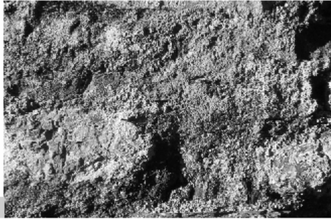
Figura 2 • Presa eseguita in luce radente (solare) del particolare di una muratura. Si osservino gli effetti di esaltazione delle rugosità di superficie e la gamma dei colori. (SAT)
