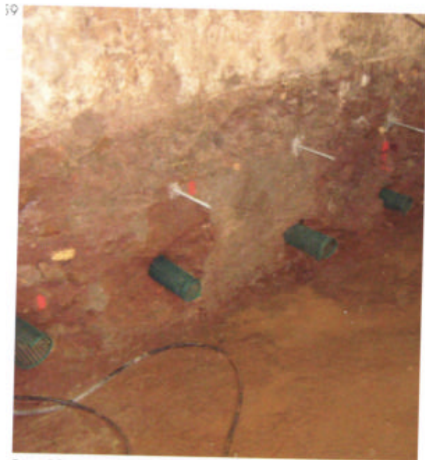
FIGURA 59 • Roma, Palazzo Gambirasi. Fori di ventilazione delle murature con l'inserimento della rete forata antintasamento.
