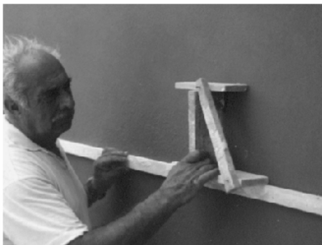
Figura 9 • Sagoma utilizzata per integrazione di stucchi in opera.
