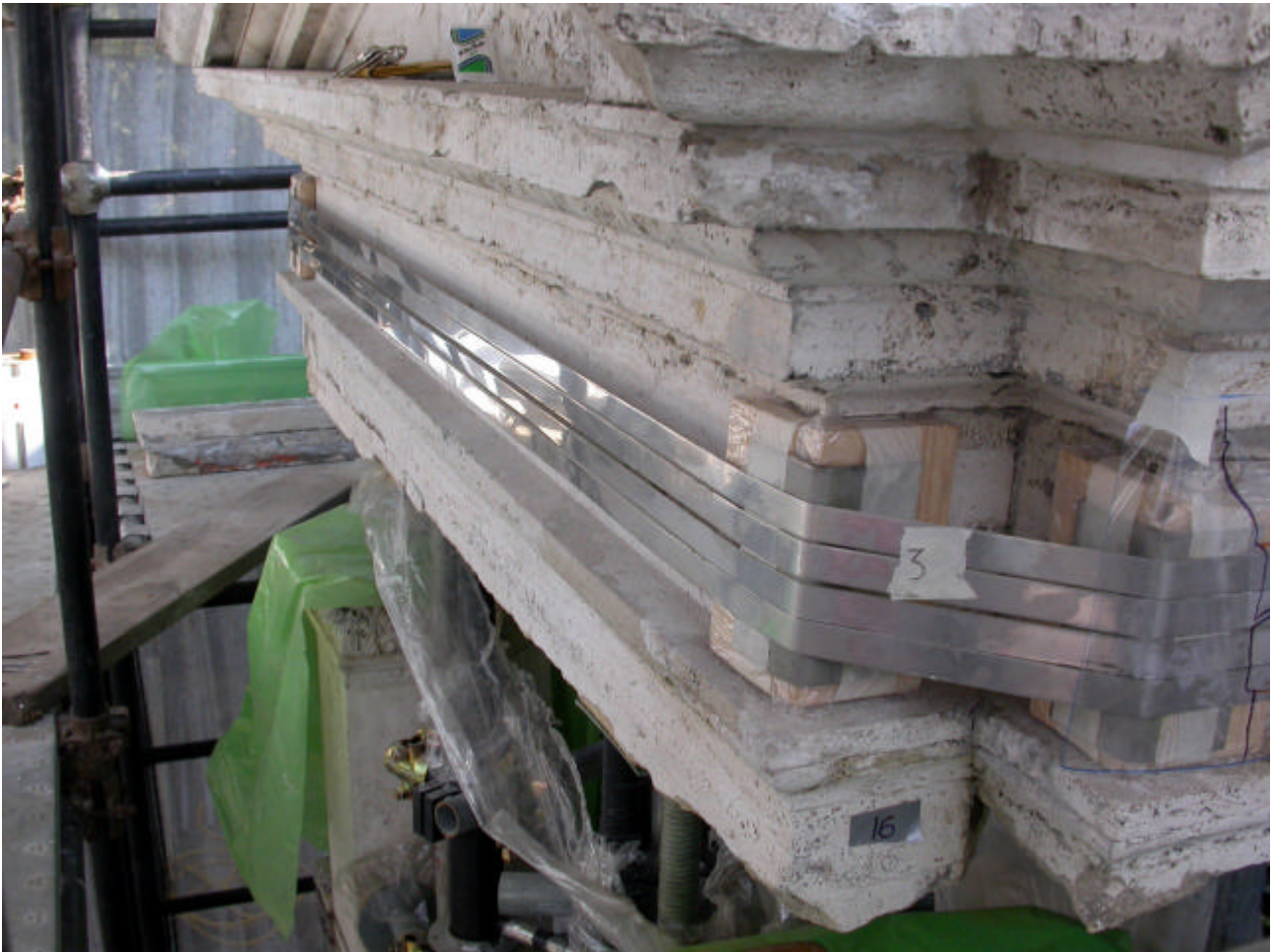
Figura 7 • Roma, edicola di S. Andrea al Gianicolo in via delle Mura Aurelie a Roma, dettaglio della cerchiatura in CAM impiegata per integrare il sollevamento della copertura e la sostituzione delle antiche barre in ferro; Zetema spa, 2003.
