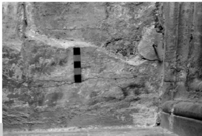
Figura 1 • Imperniatura di un frammento di lastra di rivestimento: esecuzione del foro e inserimento della barra filettata prima dell'iniezione di resina.
