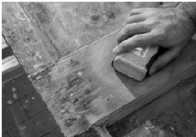
Figura 4 • Dopo la rimozione della vernice si può procedere con una leggera carteggiatura per rimuovere i frammenti residui.
