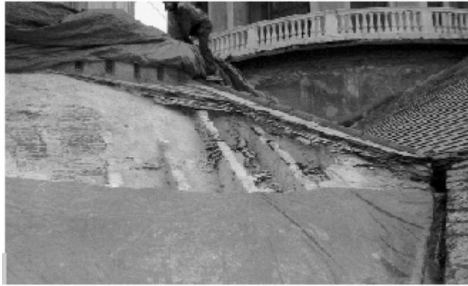
Figura 1 • Teloni di protezione su una cupola minore dell'Assunta di Carignano a Genova. Si notino i muricci in mattoni di supporto al rivestimento in abbadini d'ardesia e di mediazione tra la superficie curva dell'estradosso della cupola e la superficie piana del manto di rivestimento stesso.
