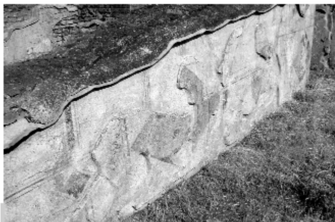
Figura 5 • Bauletto di malta con lamina di piombo.
