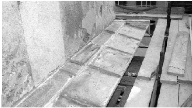
Figura 4 • Dettaglio della posa di abbadini a contatto con una superficie verticale.
