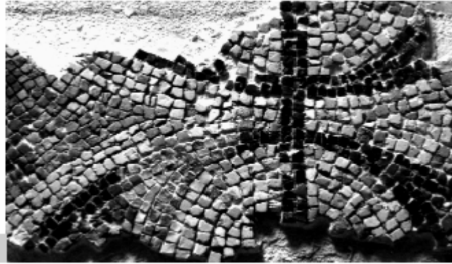
Figura 5 • Integrazione con tessere di materiale lapideo più chiare rispetto alle originali. (SRM)
