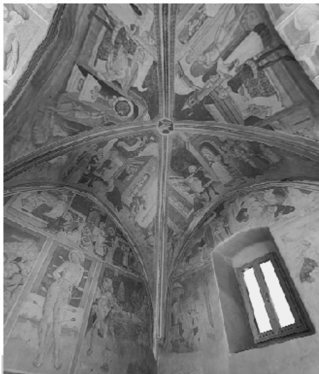
Figura 22 • S. Pietro di Feletto. Il modello arricchito con texture fotografica che riproduce le decorazioni murali seguendo l'andamento tridimensionale. (SAT)
