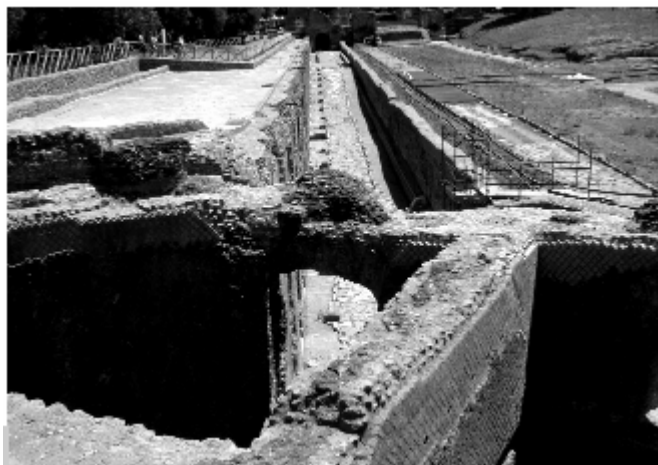
Figura 1 • Protezione della cresta di un muro mediante la posa in opera di un triplice strato di pietrame irregolare legato con abbondante malta. La differenza del taglio e della pezzatura tra i materiali e la differente posa rendono immediato il riconoscimento dell'intervento di protezione dalla struttura originale.
