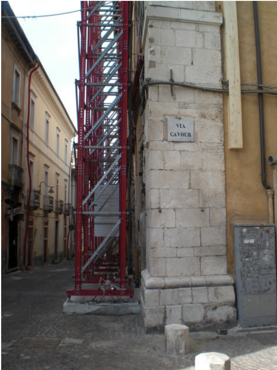
Figura 13 • Sistema reticolare di puntelli metallici nel centro storico d L'Aquila, Aprile 2010. (BUC)
