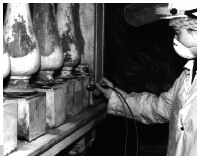
Figura 2 • Microsabbatura di precisione applicata alla pulitura di balastrini di marmo.
