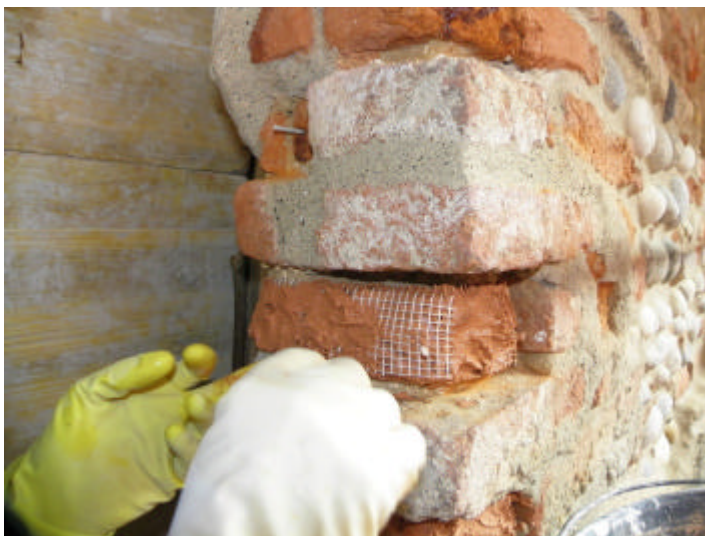
Figura 7 • Applicazione dei successivi strati di malta.
