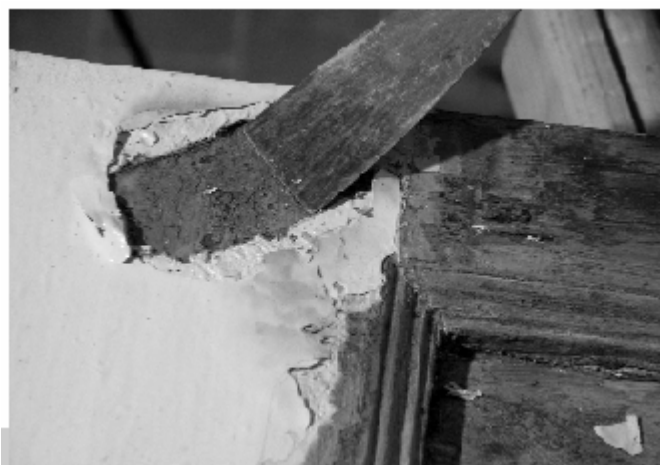
Figura 3 • L'eliminazione degli strati di vernice è radicale.
