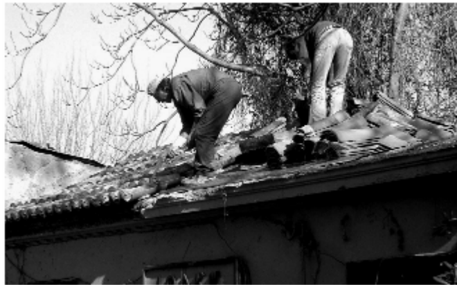
Figura 14 • Sostituzione di coppi in condizioni di precaria sicurezza per gli operatori.
