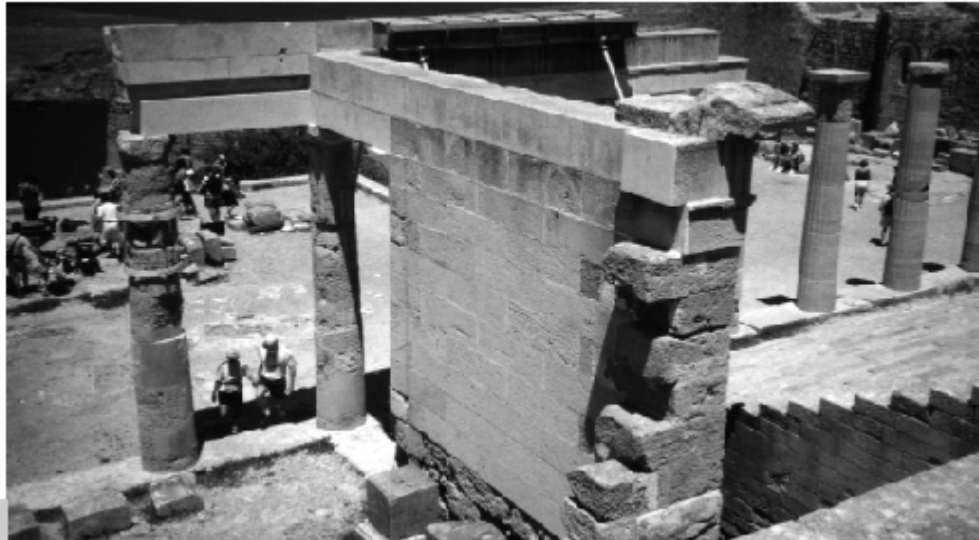
Figura 9 • Ricostruzione del setto murario legato alla trabeazione.
