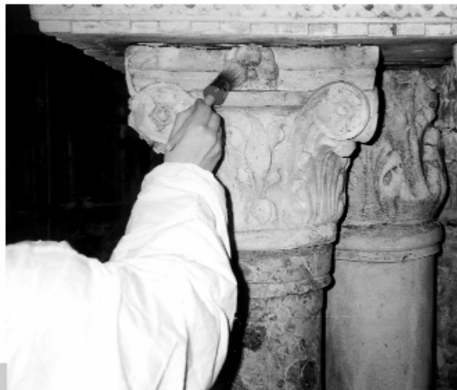
Figura 12 • Addetto durante l'operazione di stesura del prodotto impregnante. (OPD)
