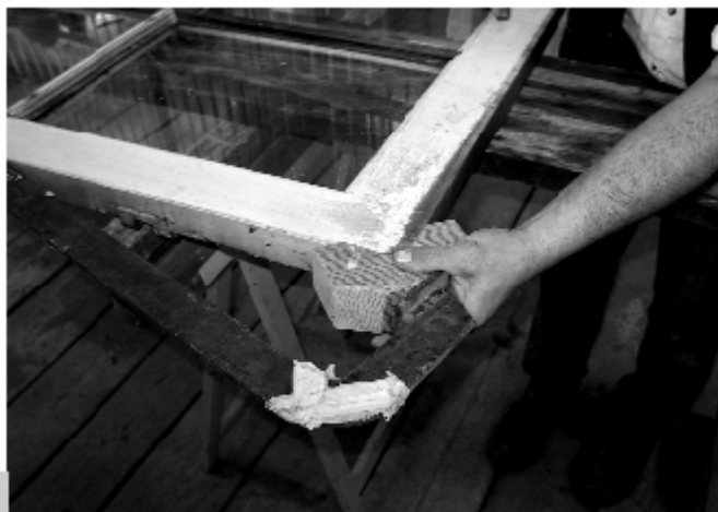
Figura 7 • Operazione di serraggio dell'incastro.
