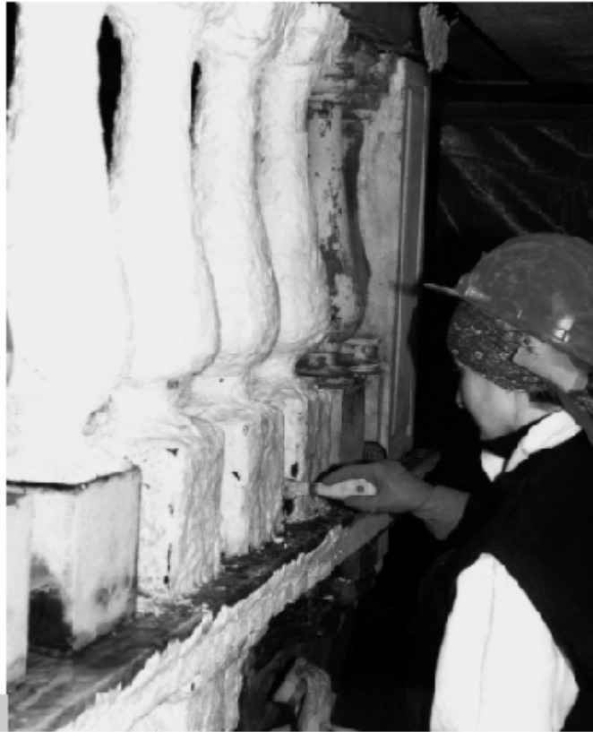
Figura 2 • Applicazione dell'impacco di polpa di cellulosa su balastrini di marmo.
