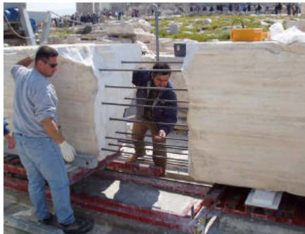
Fig. 18 • Immagine delle operazioni di giunzione di due elementi marmorei.
