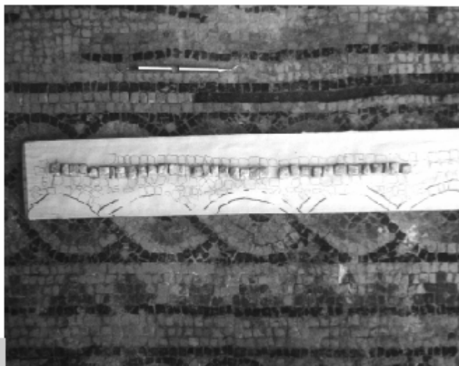
Figura 1 • Separazione con “ chiassolatura ”. Gli elementi rimossi sono incollati nella loro esatta posizione su un supporto cartaceo sul quale è stato riportato il reticolo, in scala 1:1. In tal modo, nella ricollocazione, è possibile rispettarne la posizione originaria, per distanza e orientamento d’ogni singola tessera. (SRM)
