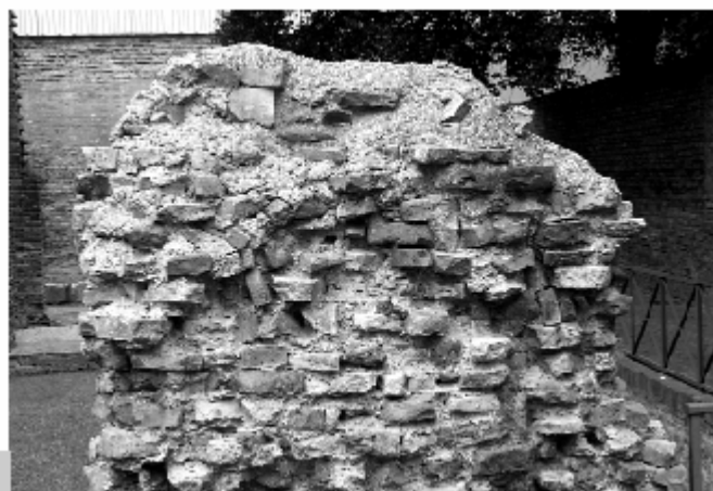
Figura 3 • Lo strato di sacrificio è ottenuto con malta e frammenti di pietra e mattoni.
