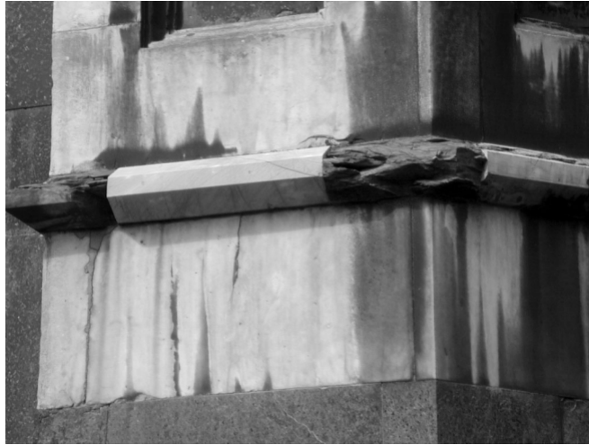
Figura 6 • Tassello dalla forma analoga alla cornice da sostituire, ma di materiale diverso.
