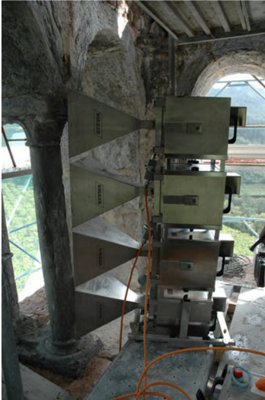
Figura 1 • Essiccazione di colonna in pietra con sistema monitorato di disidratazione a frequenza micro pulsate.
