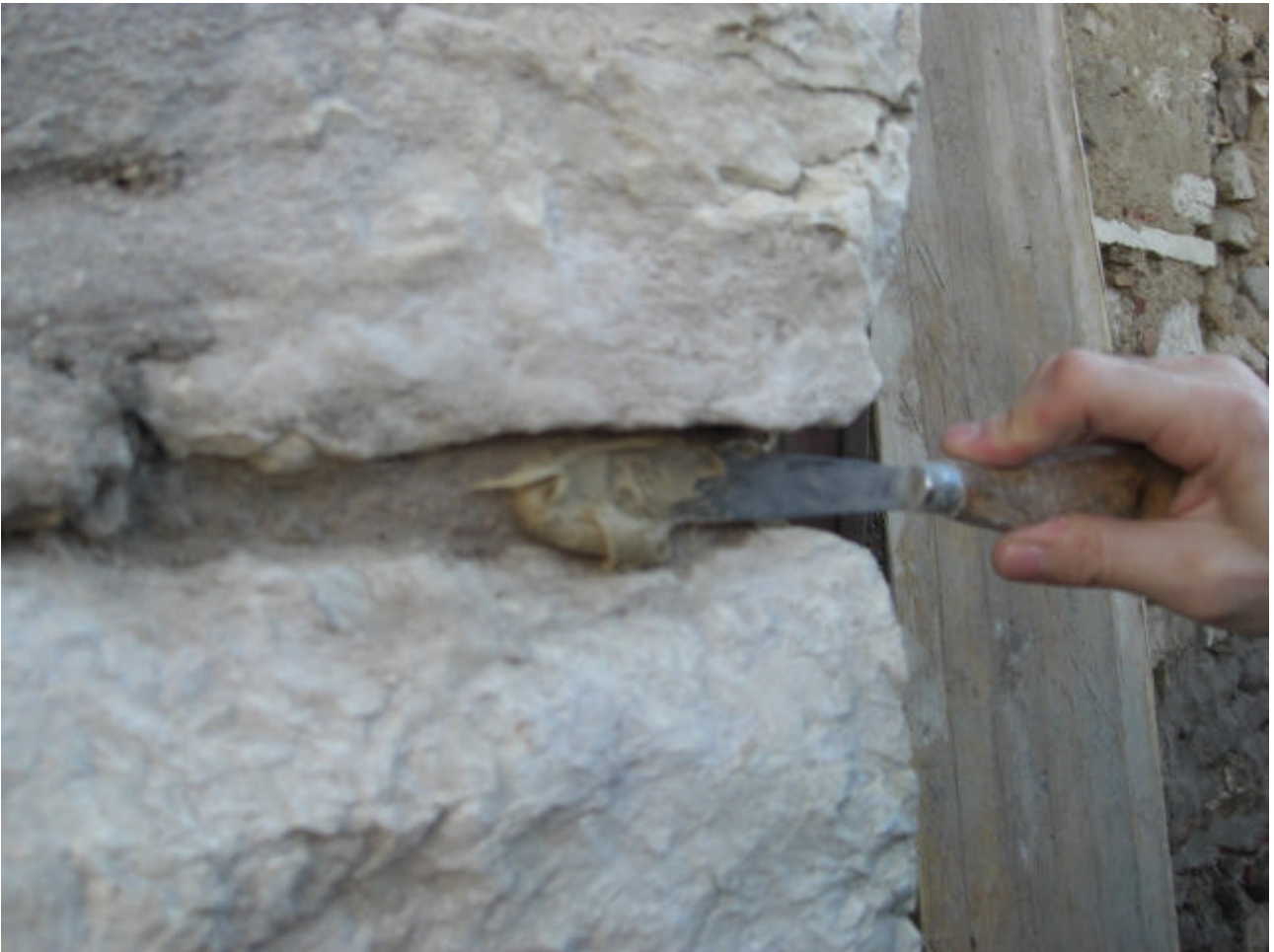
Figura 16b • Fasciatura inserita nei giunti di malta. Stesura dell'adesivo epossidico a consistenza di stucco. (IAR)
