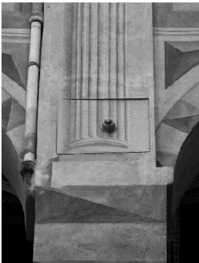
Figura 8 • Bolzone mimetizzato con la decorazione della facciata.
