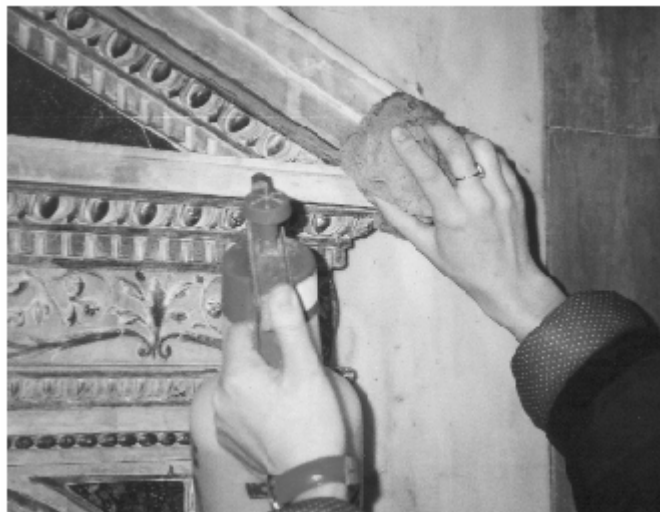
Figura 3 • Uso combinato di spruzzatore e spugna. (OPD)
