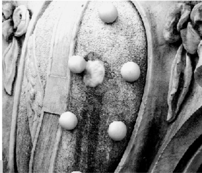
Figura 4 • Il carbonato d'ammonio è lasciato agire brevemente sulla superficie lapidea. (OPD)
