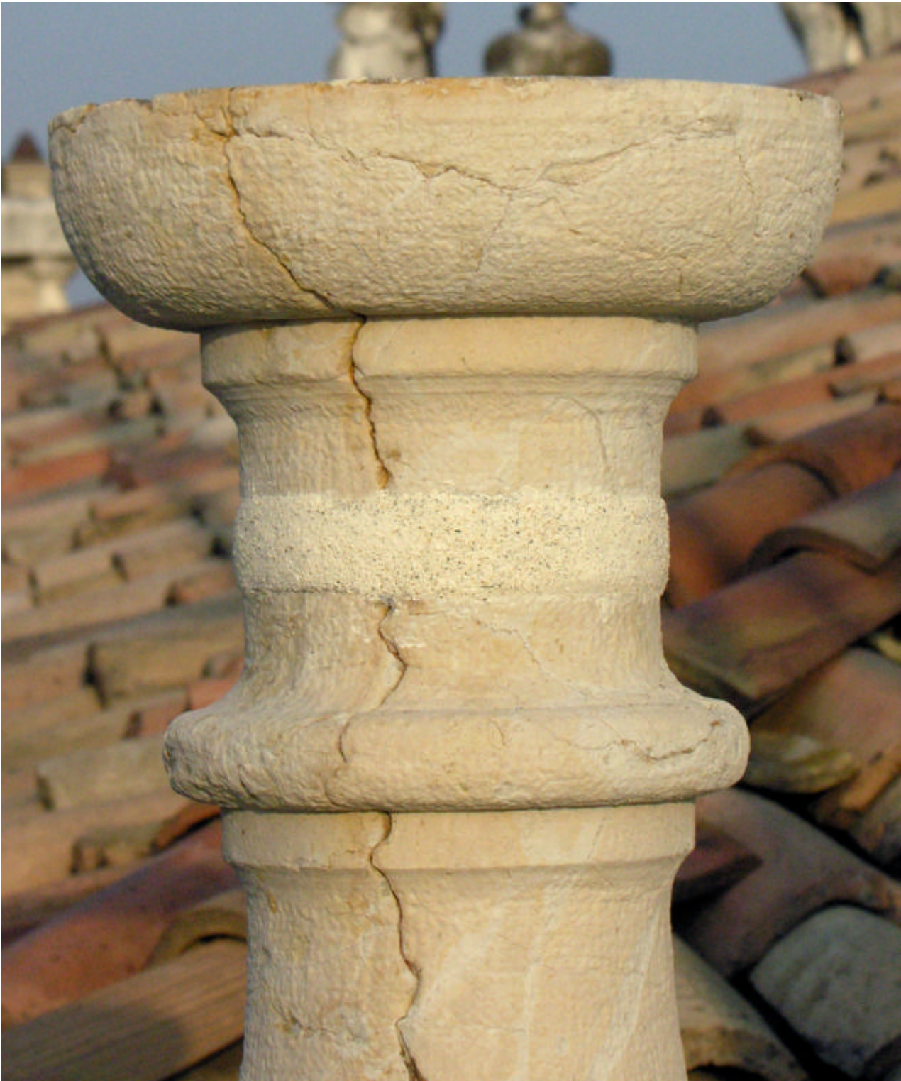
Figura 14 • Nastro in fibra di carbonio dopo la stesura della malta di finitura (calce naturale e inerti di calcare ammonitico, dimensioni > 0,1-0,2 mm). (ADORNI)
