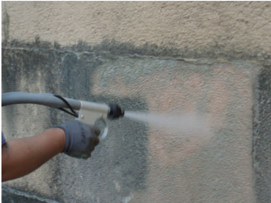
Figura 5 • Pulitura pietra di Finale interessata da croste nere, scritte vandaliche e patine biologiche con sistema Helix.
