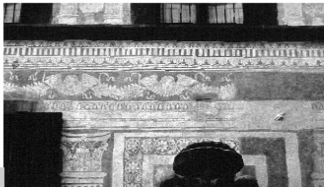
Figura 2 • Facciata graffita quattrocentesca del palazzo Barbolani da Montauto, attribuita a Michelozzo nella via de' Ginori a Firenze (particolare) dopo il trattamento passivante-protettivo dell'ossalato di ammonio eseguito sull'intera superficie dopo pulitura con carbonato di ammonio.
