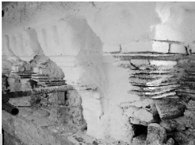
Figura 3 • La superficie ricoperta dall'impasto desalinizzante.
