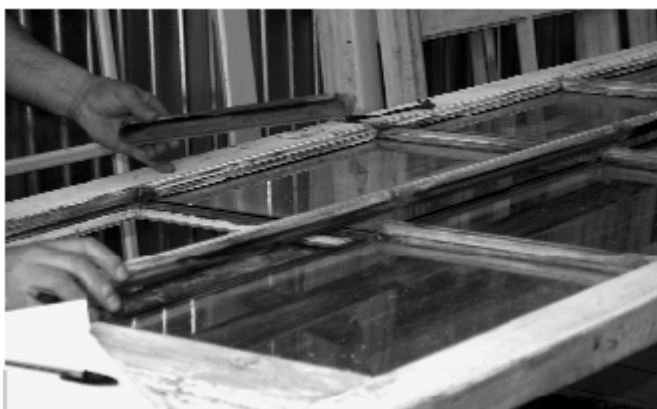
Figura 2 • Progressivo smontaggio dei vetri e dei listelli all'inglese.
