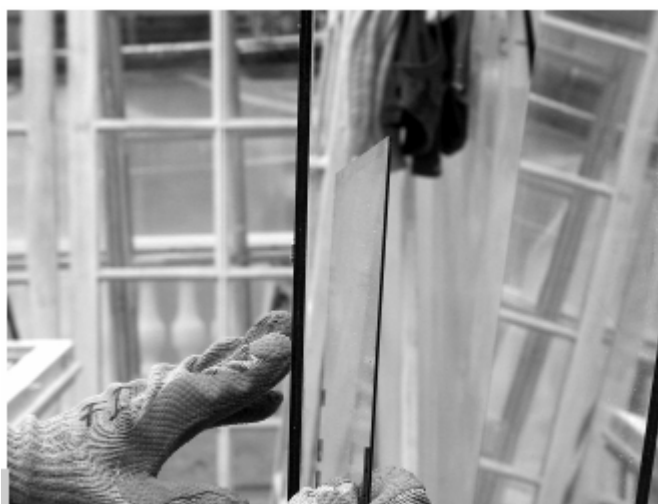
Figura 6 • Ricollocazione di una lastra di cristallo.
