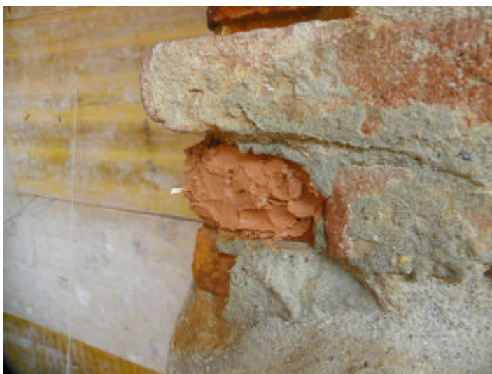
Figura 5 • Applicazione di una prima mano di malta a base di polvere di mattone e grassello di calce.
