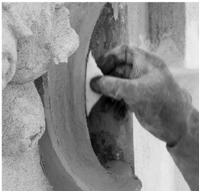
Figura 7 • Operazione di lisciatura della malta modellata con una spugna bagnata.
