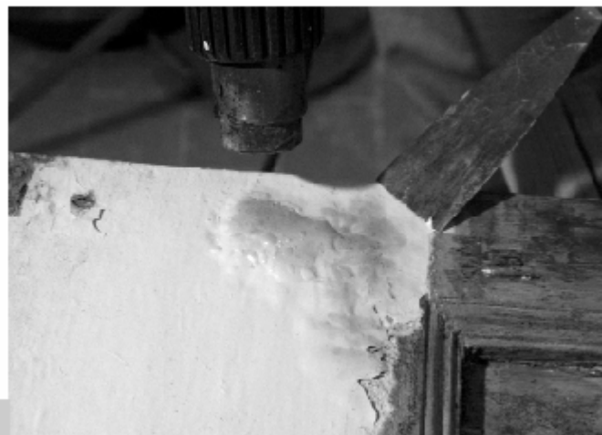
Figura 1 • Pistola termica in azione per la sverniciatura di un'anta di porta. Si notano le vesciche di rigonfiamento provocate dal calore.
