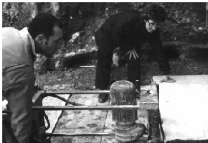
Figura 9 • Fase del distacco del mosaico con una sega a catena. (SRM)
