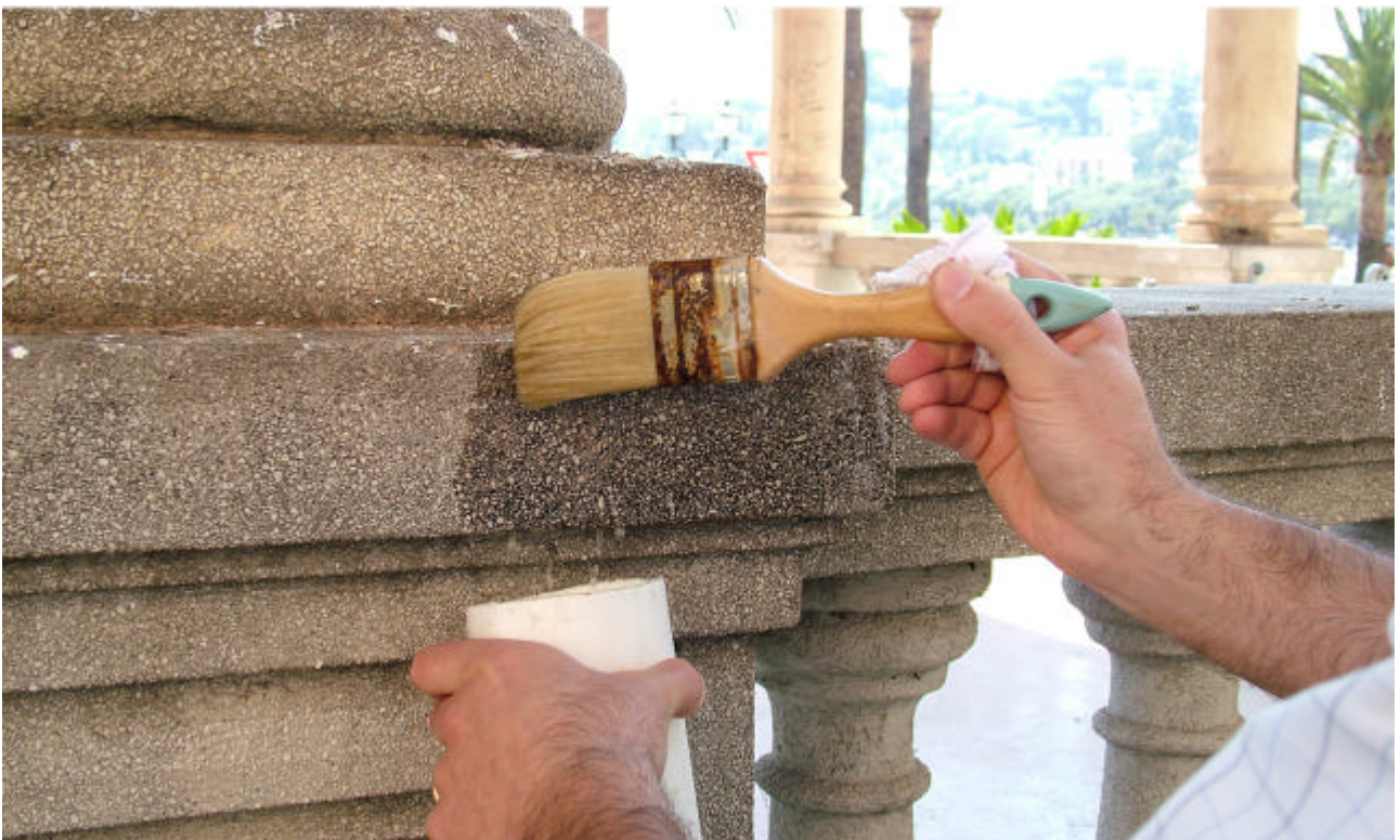
Figura 6 • Fase di esecuzione della pulitura di un basamento in pietra artificiale. (DEP)
