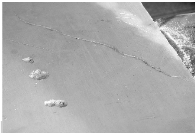
Figura 1 • Superficie di marmo con cavità da integrare. (ZAM)
