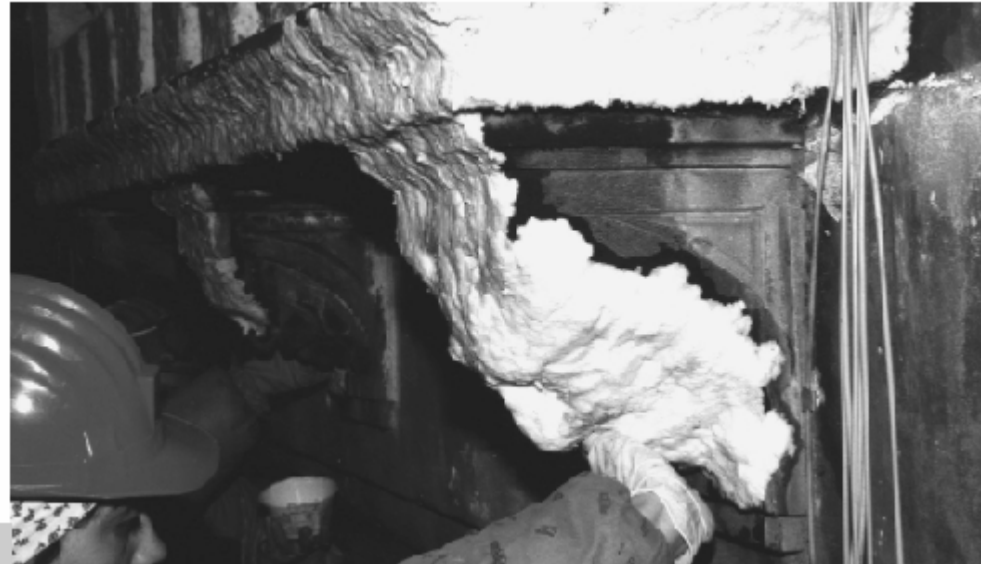
Figura 1 • Applicazione dell'impacco di polpa di cellulosa sulla superficie di una mensola di marmo.
