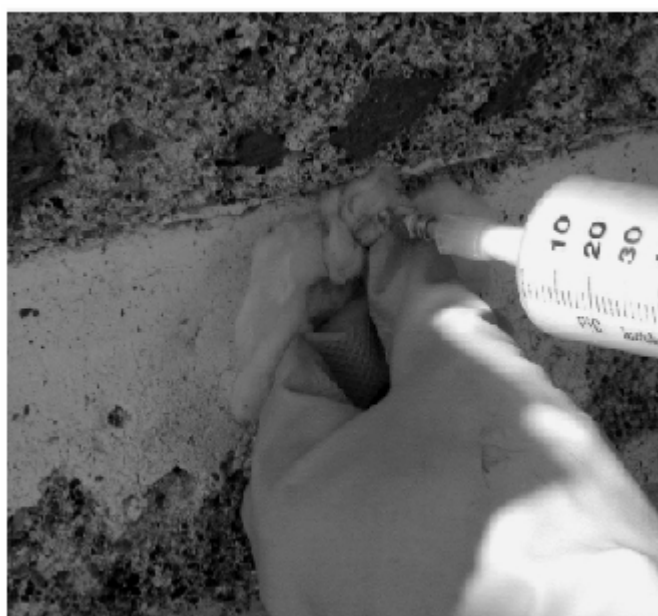
Figura 6 • Iniezione del consolidante (osservare l'impiego di batuffoli di ovatta per evitare perdite e colature).
