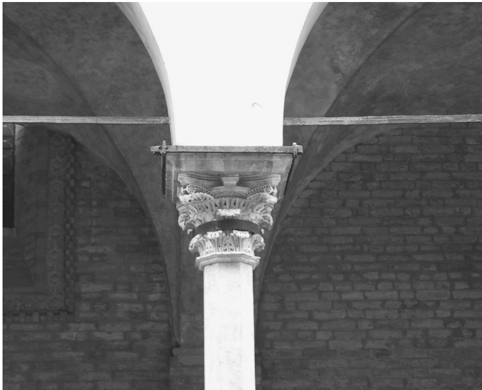
Figura 1 • Cerchiatura del capitello e del pulvino.
