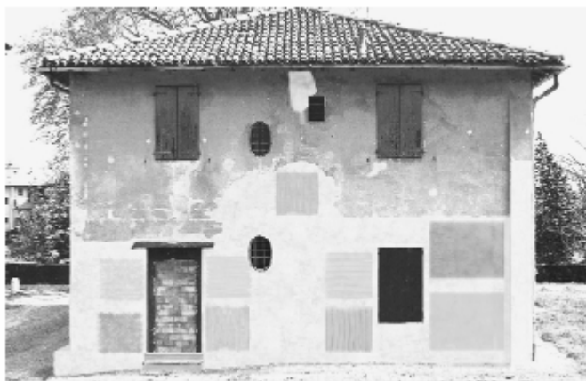
Figura 2 • Campionature di pitturazioni e velature di diverso colore e grado di trasparenza, realizzate sul nuovo intonaco. Nella parte centrale della facciata è riportato il campione di velatura scelto per le successive elaborazioni. (DEP)
