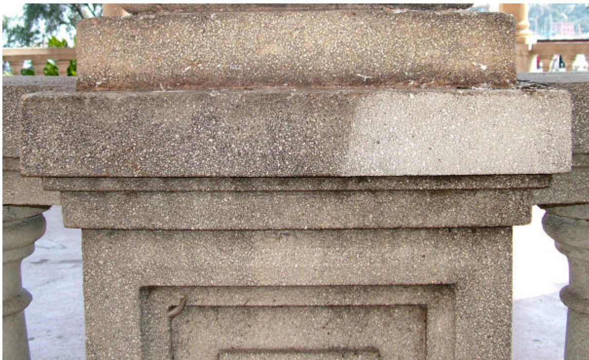
Figura 7 • Saggio di pulitura reale della superficie in pietra artificiale. (DEP)
