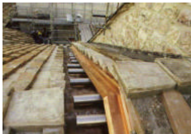
Fig. 31 • Assisi, Basilica di San Francesco. Dettaglio della intersezione tra copertura e muro di facciata in cui sono stati posizionati i vincoli ottenuti con i dispositivi SMAD.
