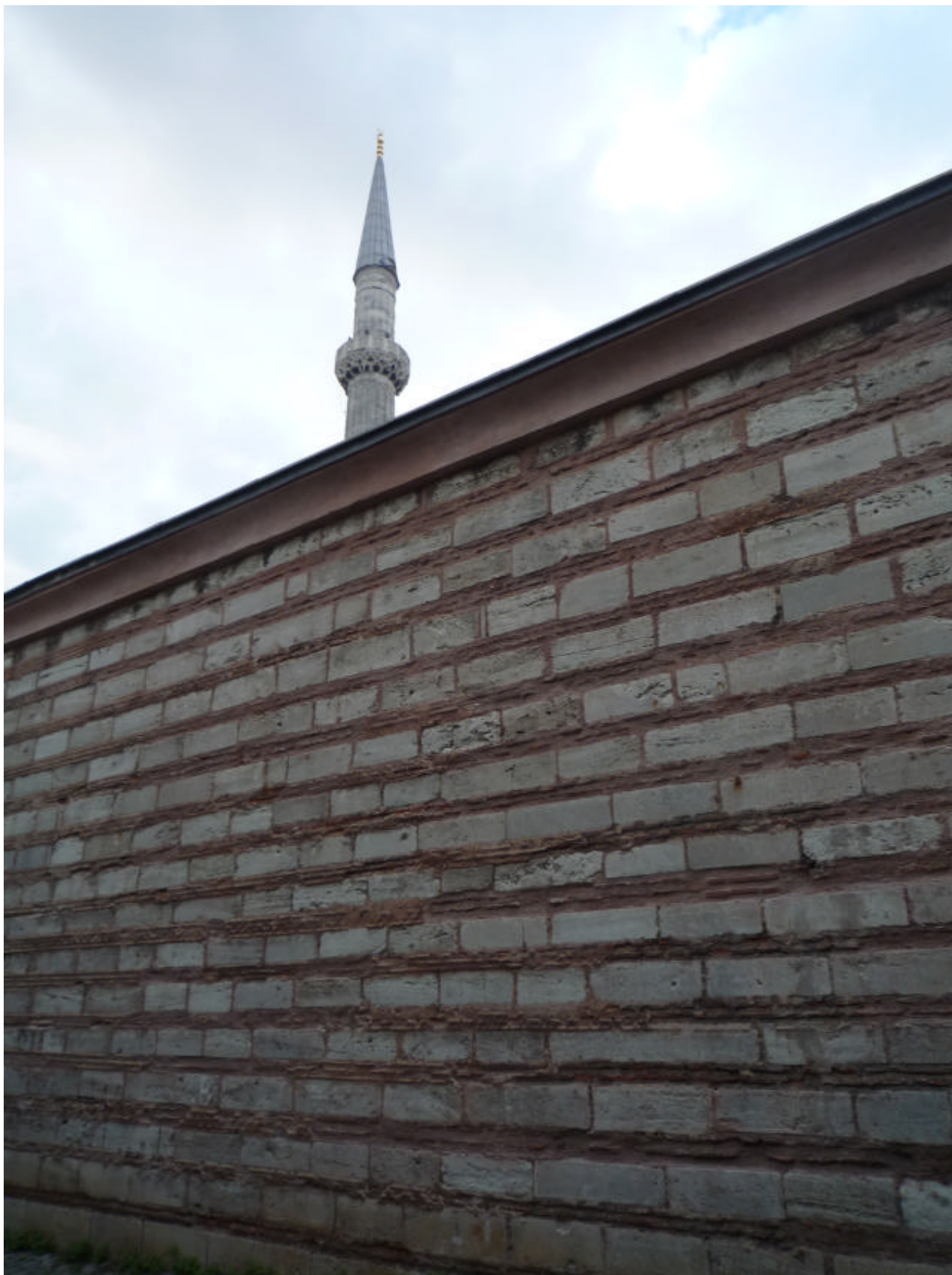
Figura 4 • Istanbul, muro di cinta della Basilica di Santa Sofia: parete sulla quale è stata applicata la tecnica del cuci-scuci, mantenendo uguali materiali, forme, dimensioni e apparecchiature con un risultato altamente mimetico. (BUC)
