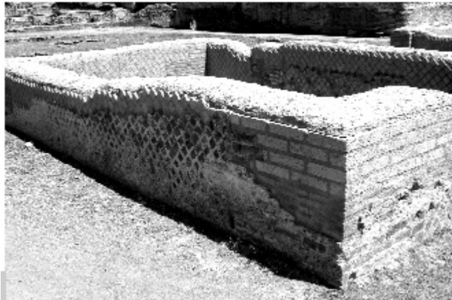
Figura 1 • Stesura, sulla superficie superiore delle creste, di uno strato di malta nel quale vengono infissi frammenti di laterizio, in modo che la malta li inglobi senza però ricoprirli del tutto.
