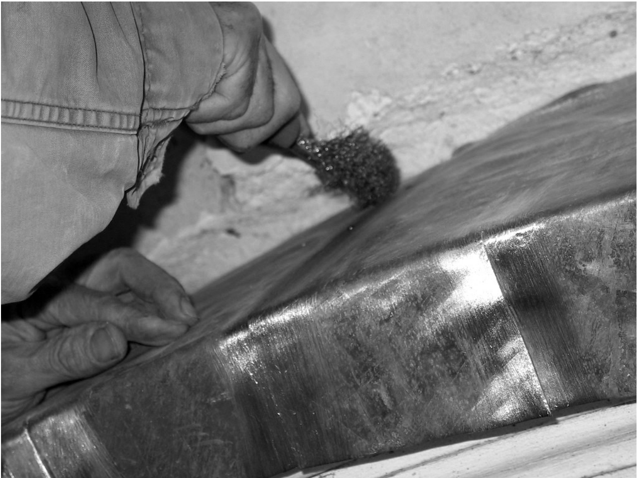
Figura 14 • Pulitura, mediante spazzola metallica, dei giunti da saldare.
