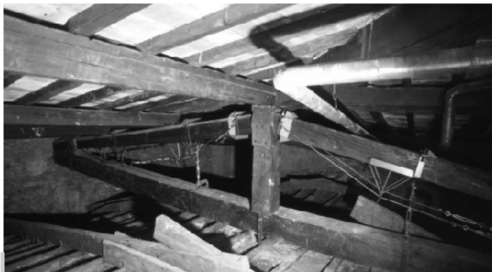
Figura 4 • La soluzione illustrata nella fig. 1, schema b), è applicata ai puntoni di una capriata. In questo caso è presente una coppia di cavi d'acciaio affiancati alla trave e completamente esterni. (TAM)
