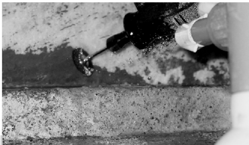
Figura 3 • Pulitura per abrasione, utilizzando una mola e uno spruzzatore manuale. L'acqua consente sia di moderare l'effetto abrasivo, sia di mantenere pulito il punto su cui si opera, controllando l'azione. (OPD)
