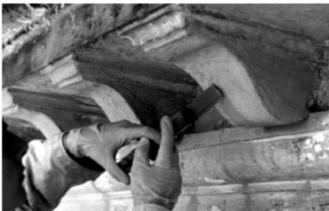
Figura 4 • È iniettata la prima parte di adesivo per fissare la testa del perno.
