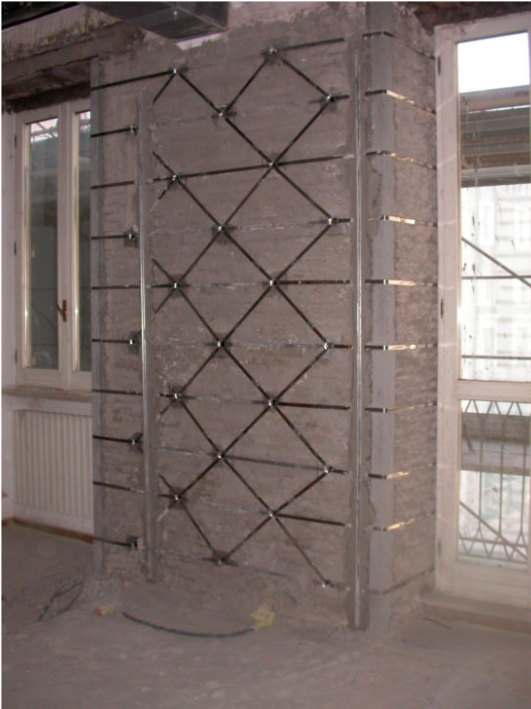
Figura 8 • Roma, palazzetto in via del Corso, consolidamento di un maschio murario con il sistema CAM; Giorgio Monti e Nicola Scirocco, 2005.
