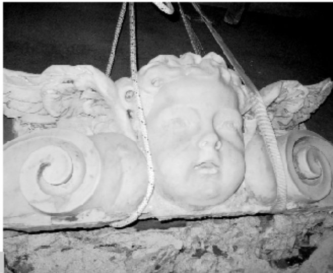
Figura 4 • Sostituzione degli elementi di connessione di una cornice di marmo: l'architrave superiore è imbragato e rimosso dalla sua posizione originale.
