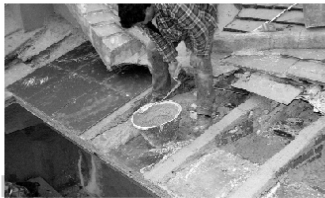
Figura 2 • Messa in opera delle lastre di gronda.
