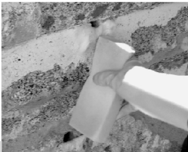
Figura 8 • Pulitura finale con spugna.
