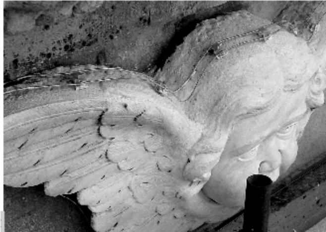
Figura 12 • I conduttori del sistema elettrostatico collocati in una zona non visibile, a protezione di un elemento scultoreo.
