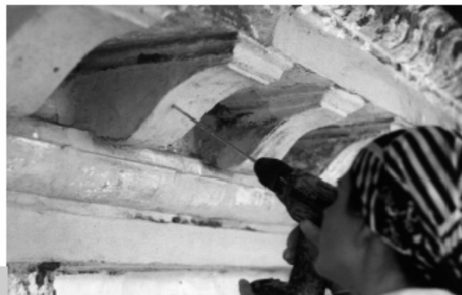
Figura 3 • Mensole di stucco. L'operatrice pratica un foro per l'inserimento di un perno.
