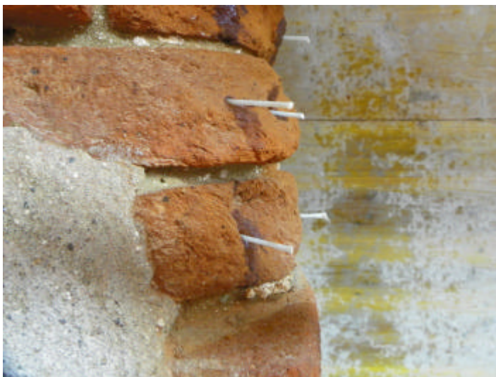
Figura 4 • Imperniatura con bacchette di vetroresina applicate con l'ausilio di resina.
