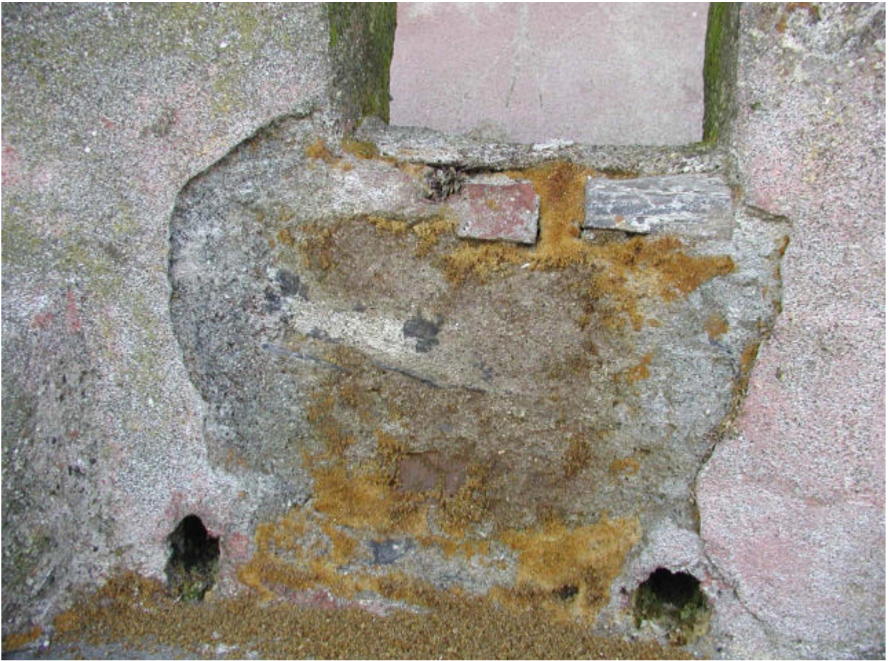
Figura 6 • Risultato parziale della disinfestazione.
