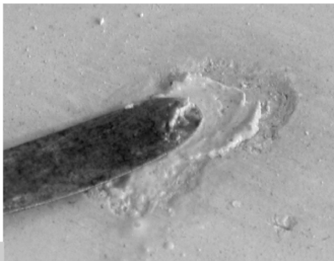
Figura 5 • La pressione della spatola permette di far penetrare lo stucco e di riempire omogeneamente la cavità. (ZAM)
