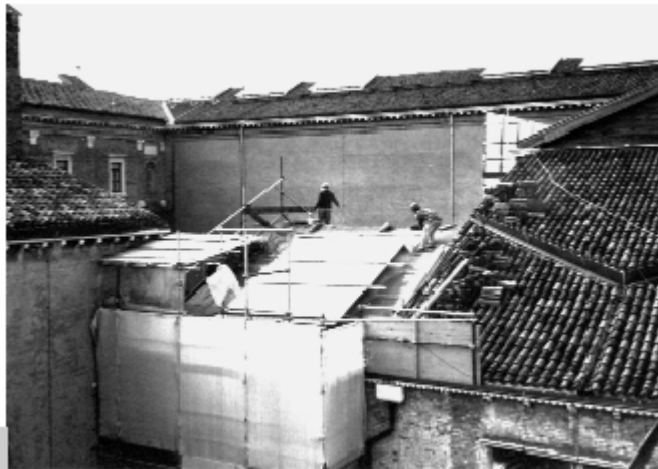
Figura 1 • Smontaggio e rimontaggio di un manto di copertura. Si notino, a sinistra, le coperture provvisorie e, a destra, alcuni coppi accatastati in attesa di essere ricollocati. (SAV)
