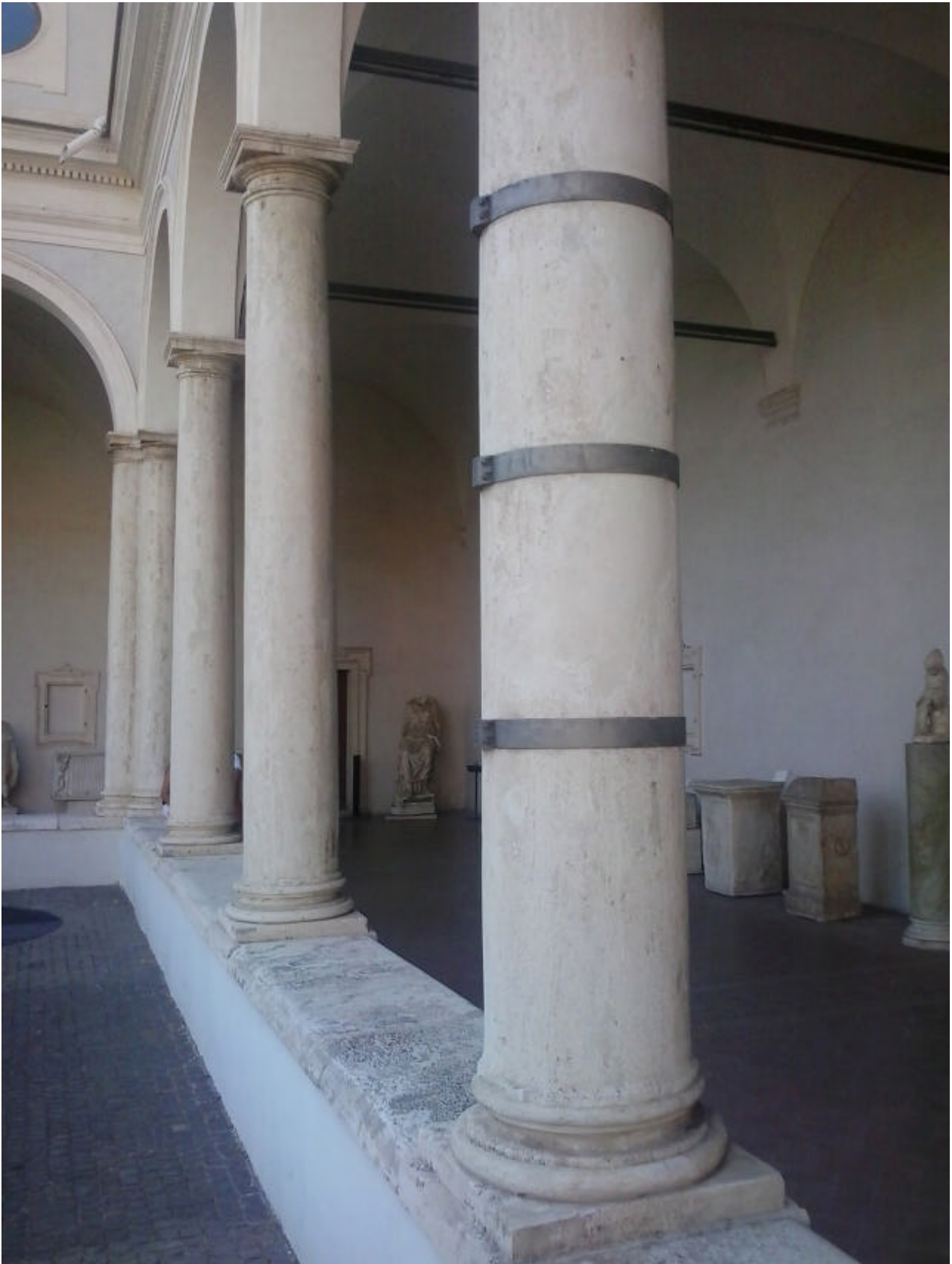
Figg. 25 e 26 • Roma, Terme di Diocleziano, Grande Chiostro. Intervento di cerchiatura su alcune colonne di travertino con fasciature in titanio: vista su una colonna e dettaglio della particolare soluzione di serraggio della fascia.
