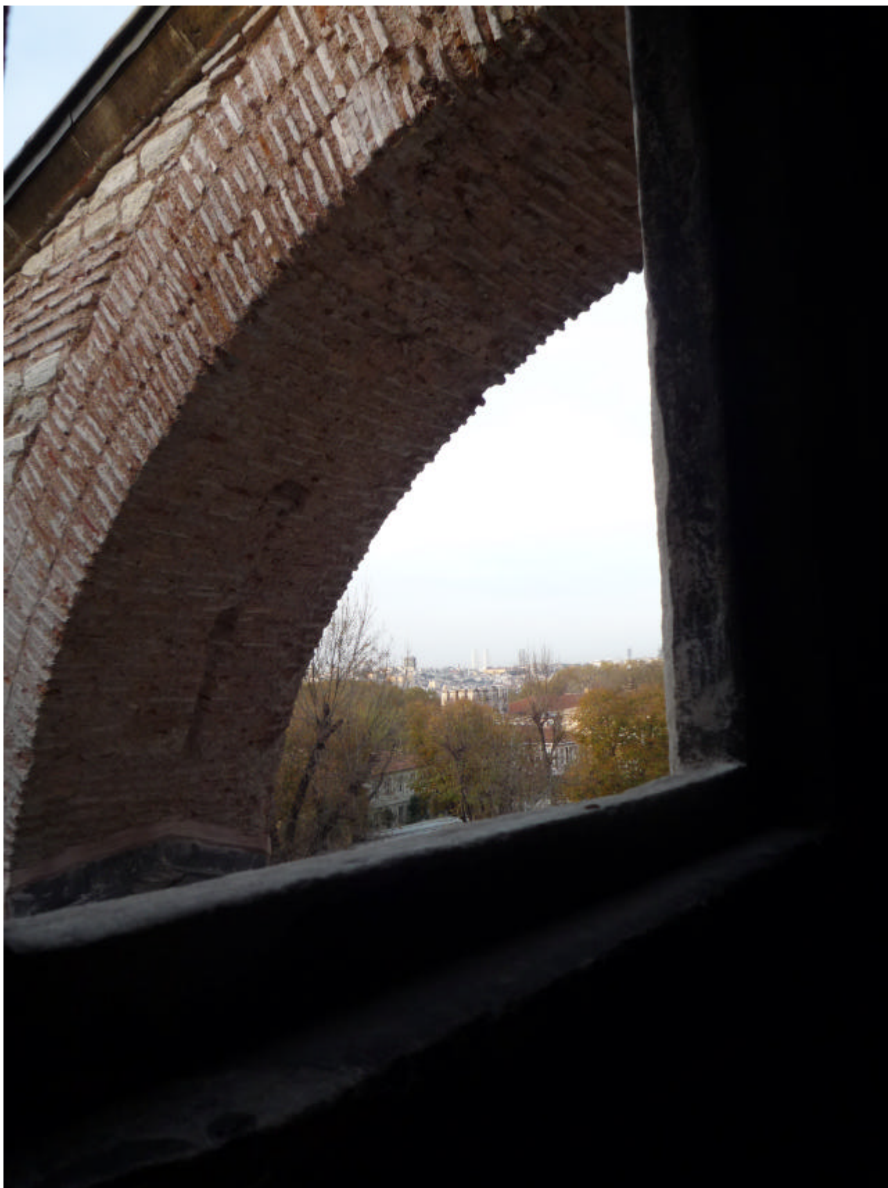
Figura 4 • Particolare della porzione sommitale di uno degli speroni murari presso l'ingresso di Santa Sofia, Istanbul. (BUC)
