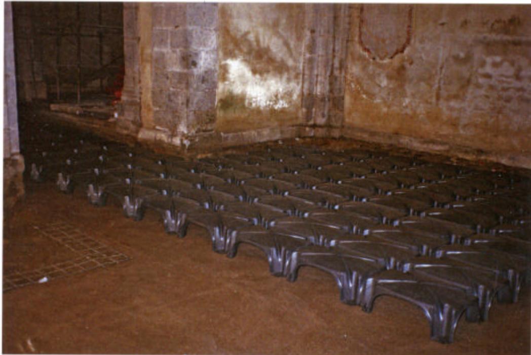
FIGURA 19 • Napoli, chiesa di San Giovanni a mare. Il sistema di casseri per la realizzazione del solaio di calpestio aerato.
