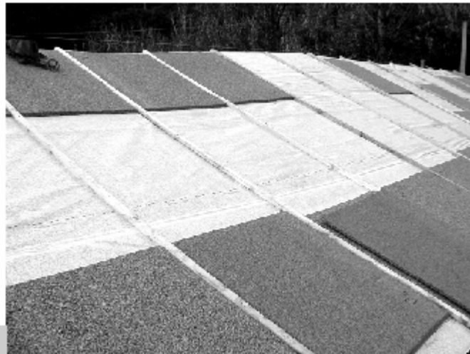
Figura 3 • Il nuovo manto coibente, costituito da: tavolato, sughero, tessuto non tessuto, sughero.
