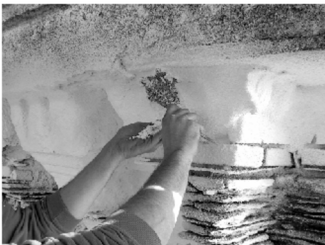
Figura 4 • Eliminazione dell'impasto con una spatola.
