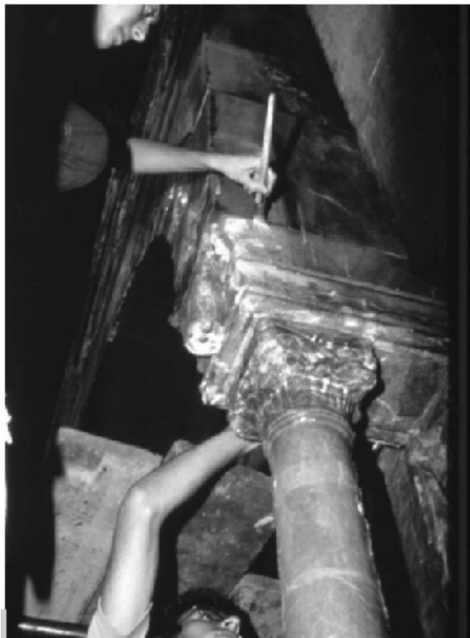
Figura 3 • Applicazione della velinatura. (NFM)(CSD02-PAN)
