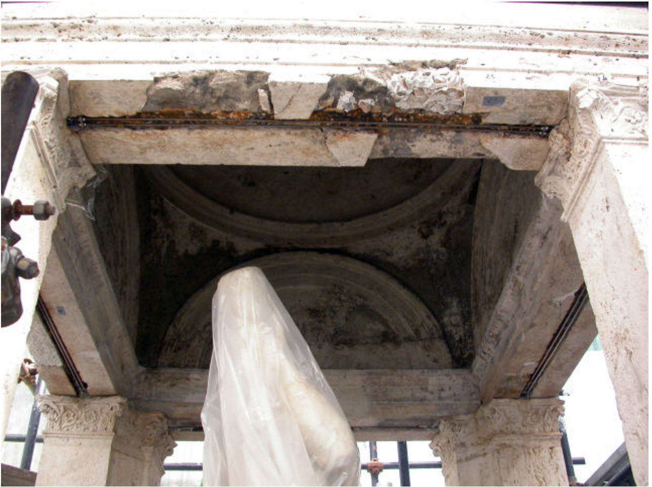
Figura 5 • Roma, edicola di S. Andrea al Gianicolo in via delle Mura Aurelie a Roma, lo stato di ossidazione delle antiche barre in ferro inserite per la connessione di elementi in travertino; Zetema spa, 2003.
