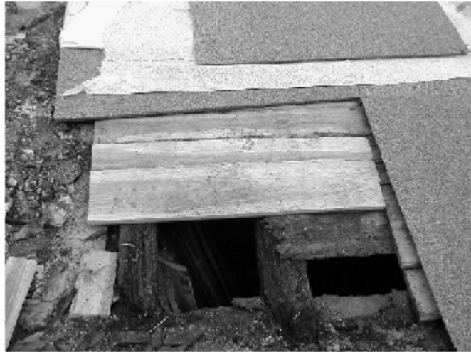
Figura 2 • La successione degli strati di coibentazione, in opera.
