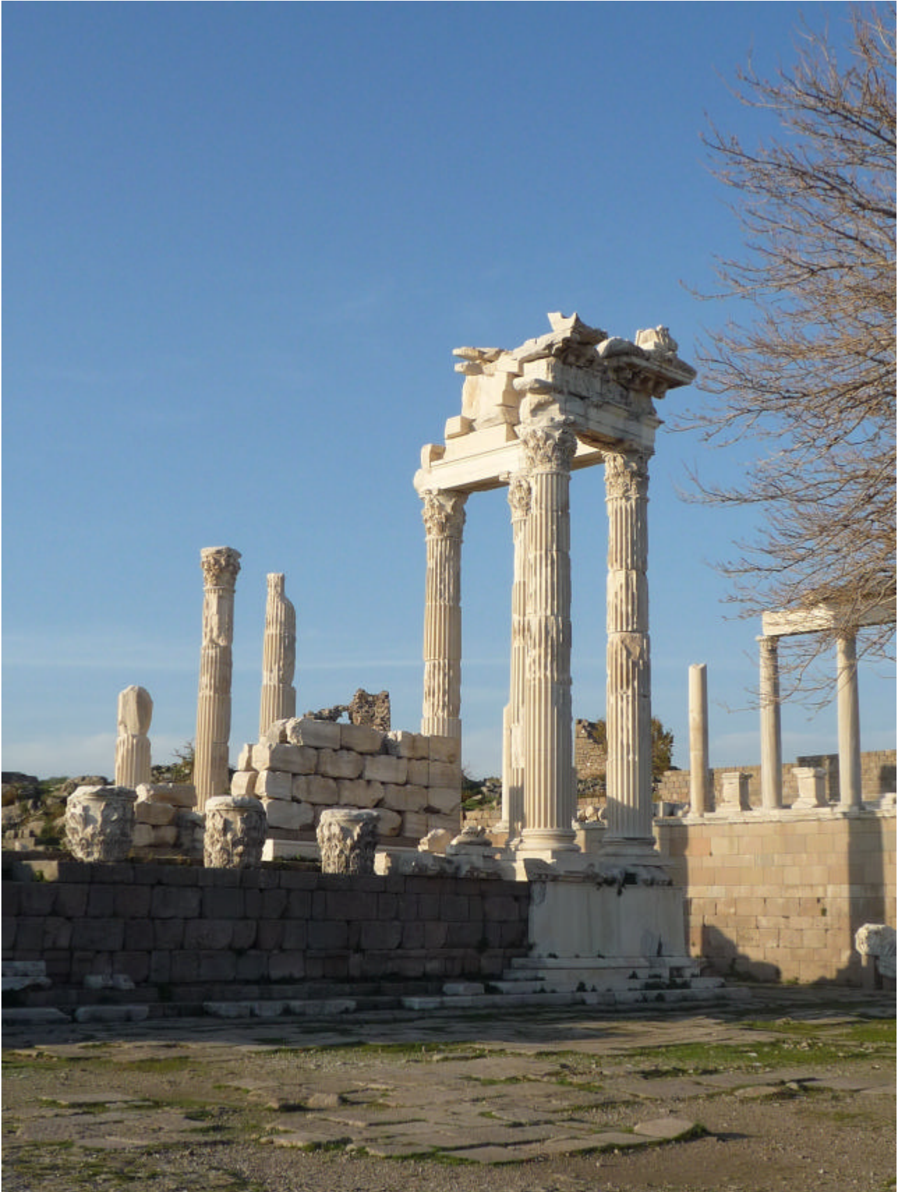
Figura 10 • Turchia, Acropoli di Pergamo: ricostruzione per anastilosi del Tempio di Traiano. (BUC)
