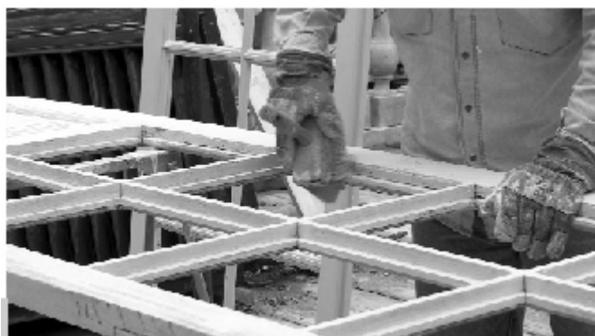
Figura 5 • Spolveratura con pennellina dopo la seconda carteggiatura.
