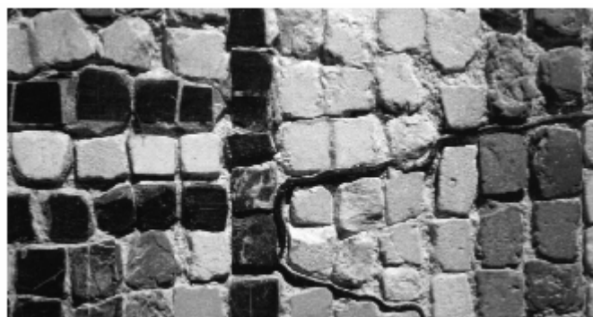
Figura 14 • Integrazione di tessere in sottotono, con elemento di separazione in vetro. (SRM)
