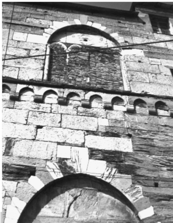
Figura 2 • Dettaglio di una polifora tamponata. Quali le cause all'origine dell'occlusione?
