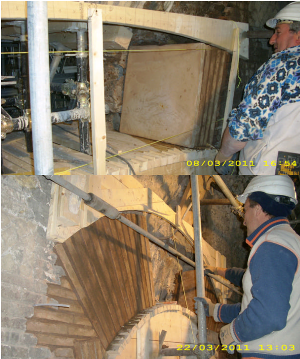
Figura 12 • Roma, Domus Tiberiana, consolidamento di piattabande e archi di scarico in laterizi: a) esempio di realizzazione di centinatura; b) ricostruzione di piattabanda con laterizi rettangolari (29x59); c) posa in opera di laterizi quadrati (bipedali); d) fase di completamento della piattabanda; Marzo 2011.
