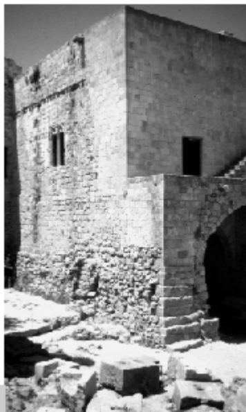
Figura 1 • Ricostruzione del cantonale in pietra.
