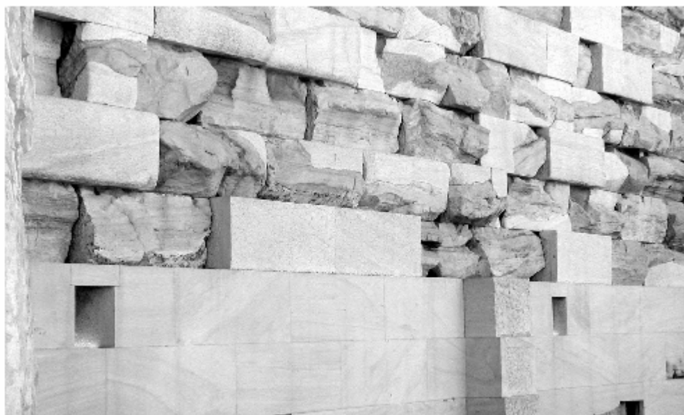
Figura 2 • Integrazione di muratura nell'Acropoli di Atene.
