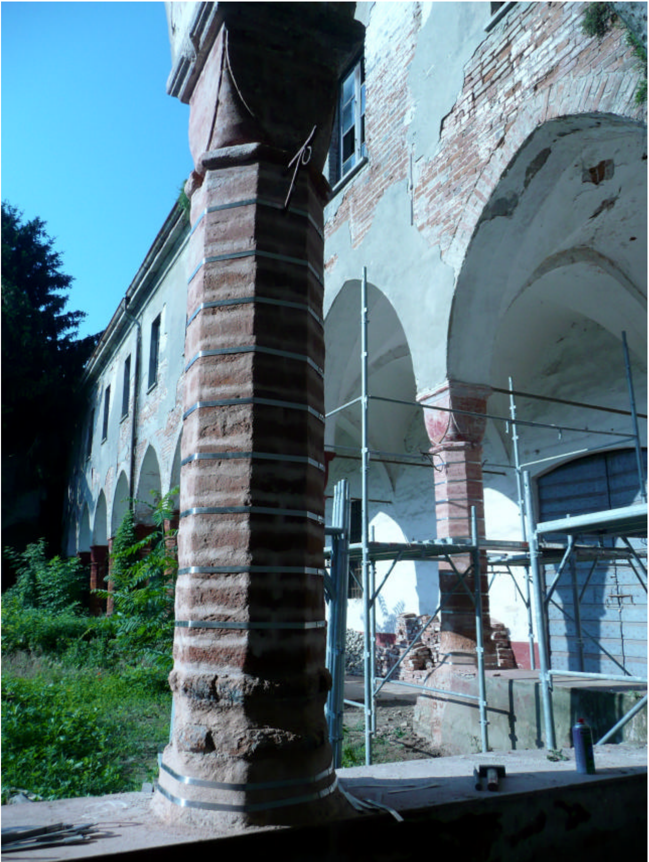
Figura 10 • Cremona, chiostro di Santa Monica, cerchiatura di colonne con sistema CAM in titanio. Il restauro prevede il rifacimento completo degli intonaci a copertura dei nastri metallici; Studio Calvi s.r.l., 2008.
