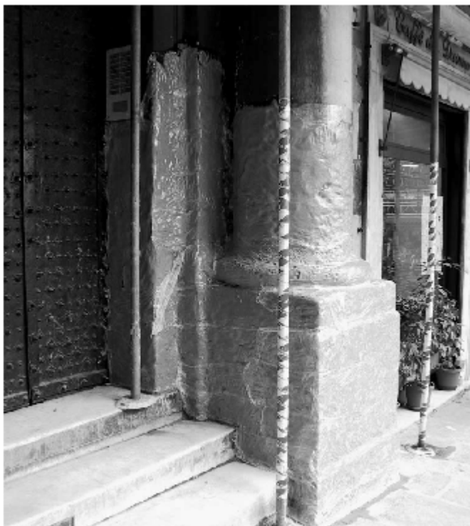
Figura 2 • Pulitura con impacchi di argille adsorbenti. In questo caso il rallentamento dell'evaporazione è assicurato da fogli di polietilene.
