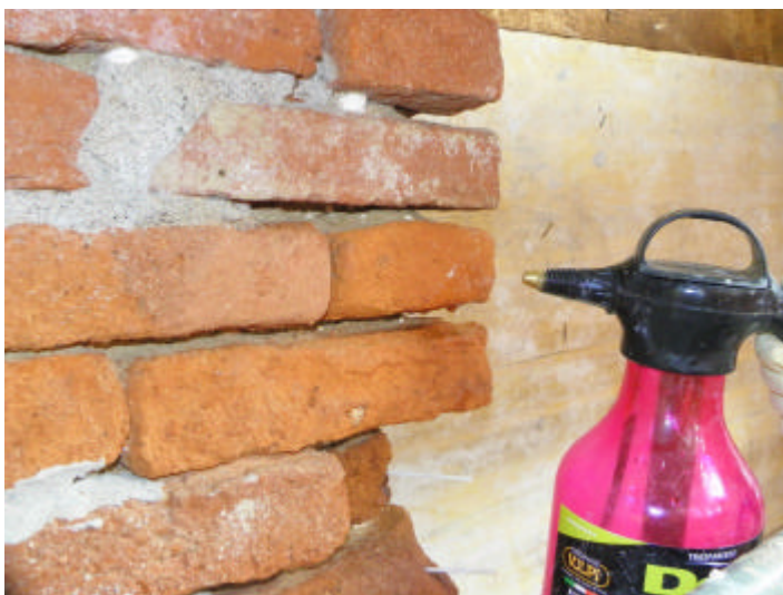
Figura 2 • Operatore durante la pulitura con acqua nebulizzata.
