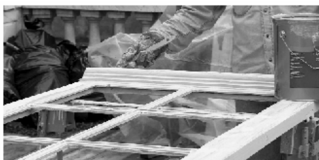
Figura 2 • Stesura a pennello del fondo.
