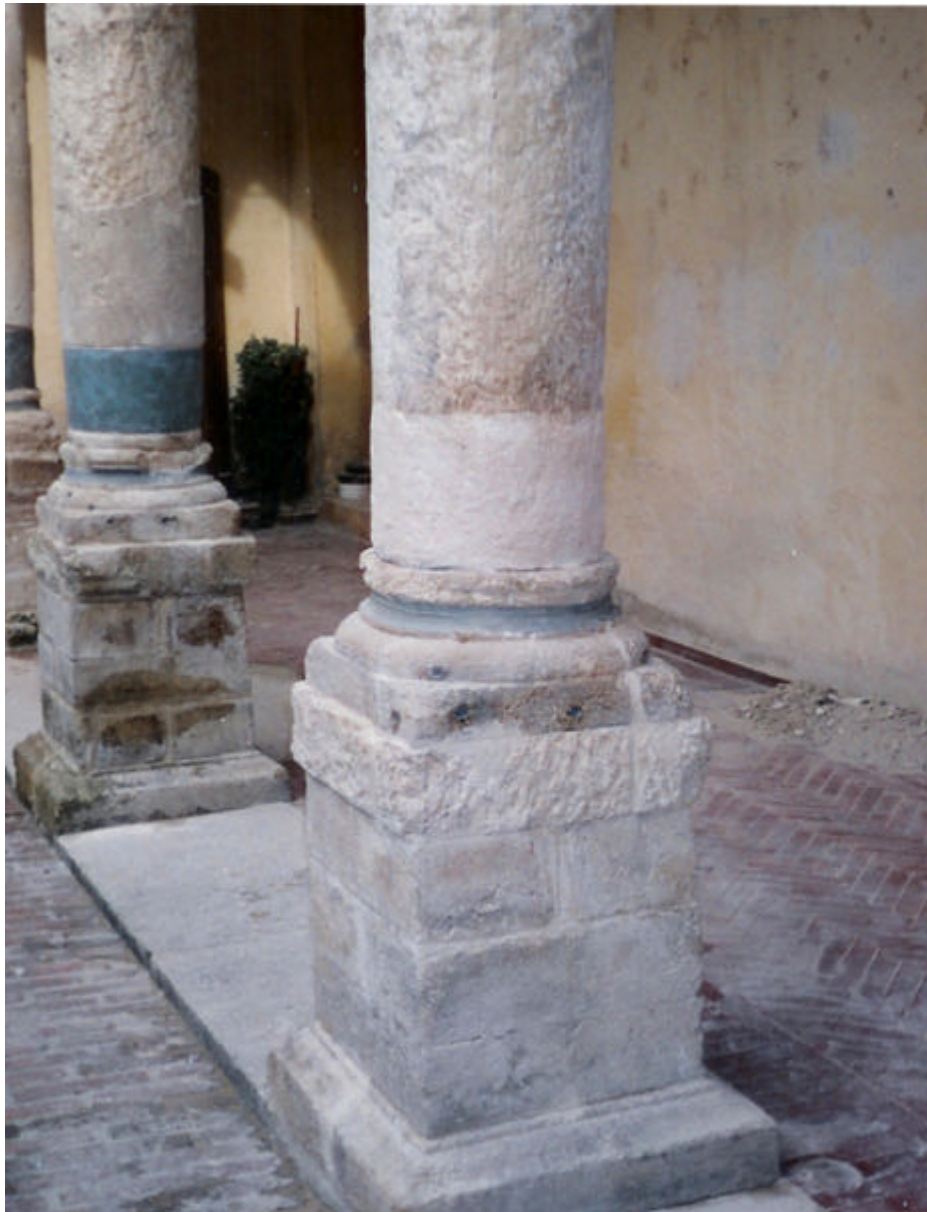
Figura 15 • Fasciature applicate alla base delle colonne. Nella colonna in primo piano è visibile la finitura con malta (calce naturale e inerti ricavati dalla frantumazione del medesimo litotipo della colonna). (KIMIA)
