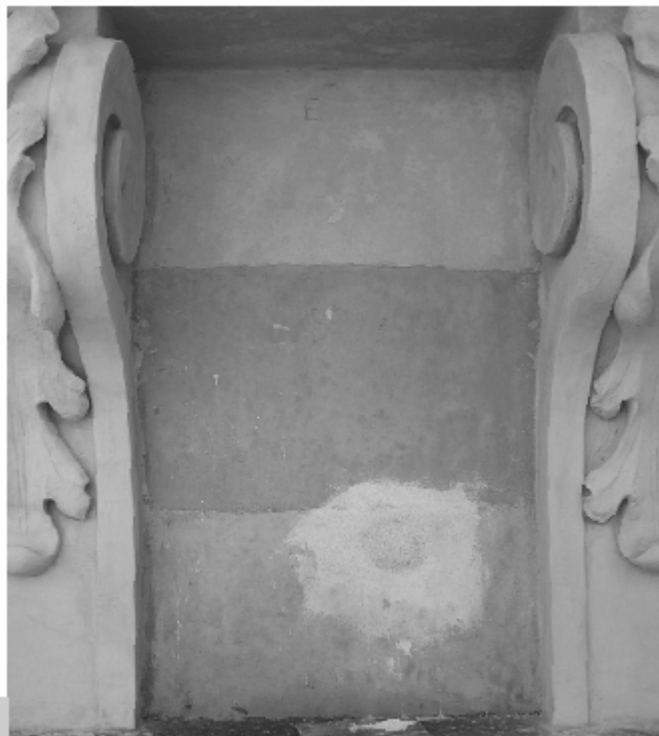
Figura 1 • Provini di verifica del tono di colore. Se il tono finale deve accordarsi con i colori esistenti, i provini vanno eseguiti direttamente sull'intonaco interessato dalle integrazioni cromatiche. Questa operazione permette un raffronto diretto più efficace tra le nuove coloriture e quelle esistenti.
