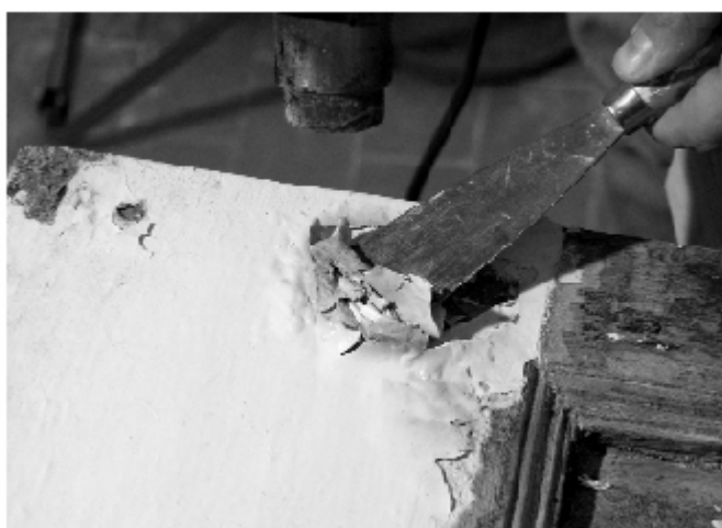
Figura 2 • L'azione della spatola permette il distacco degli strati di vernice da rimuovere.
