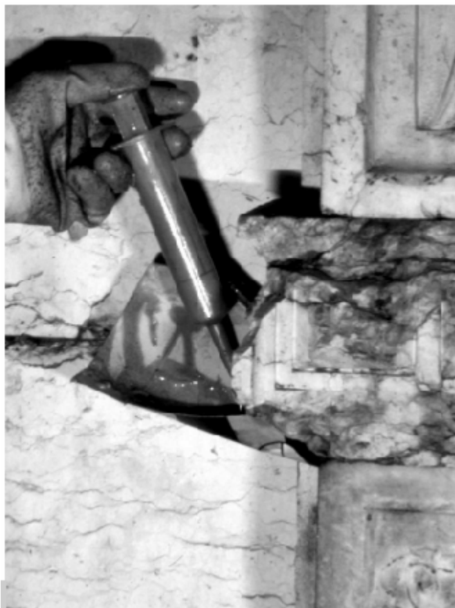
Figura 3 • Iniezione di consolidante per la riadesione di lastre e rivestimenti lapidei.
