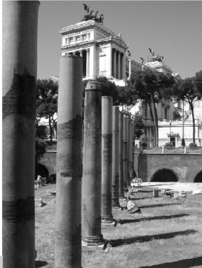
Figura 5 • Roma, fori Imperiali. Ricomposizione per anastilosi di colonna in granito con integrazioni in mattoni.
