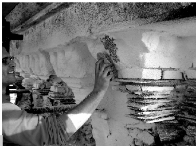
Figura 5 • Eliminazione della cellulosa mediante spazzola di saggina.
