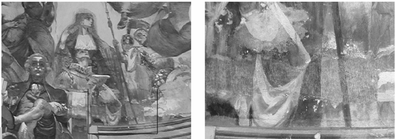
Figura 1 • Integrazione di una lacuna in un dipinto murale, con la tecnica del tratteggio. A sinistra, veduta d’insieme del dipinto integrato; a destra, dettaglio dell’intervento. v. Tavv.
