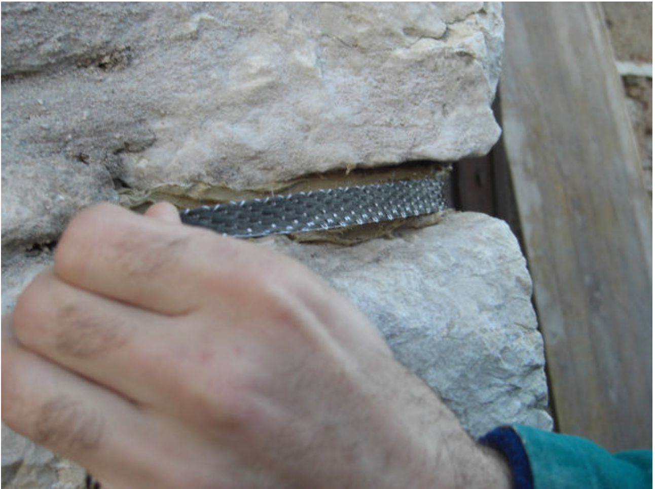
Figura 16c • Fasciatura inserita nei giunti di malta. Applicazione del nastro in fibra di carbonio (1,5 cm). (IAR)
