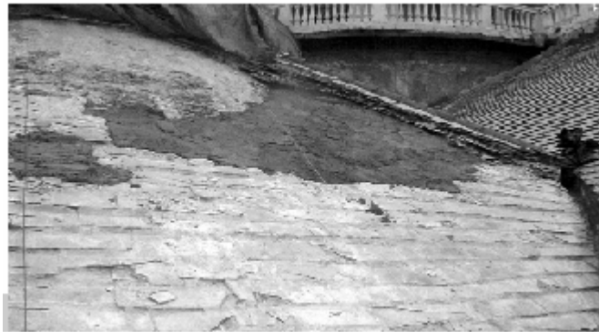
Figura 6 • Fissaggio provvisorio con malta delle porzioni di manto di abbadini pericolanti.
