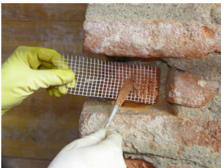
Figura 6 • Applicazione di retina in materiale plastico.
