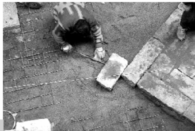
Figura 12 • Posizionamento corretto di un blocco, con l'aiuto di una lenza di allineamento e di una leva.
