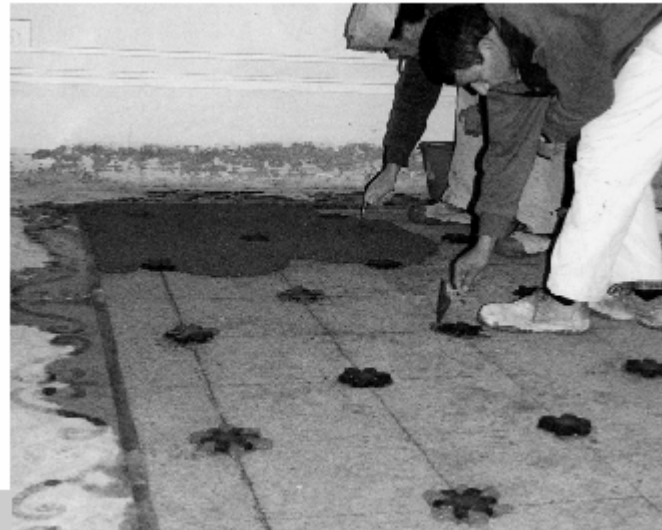
Figura 10 • Rifacimento di un tratto pavimentale ammalorato. (VIG)
