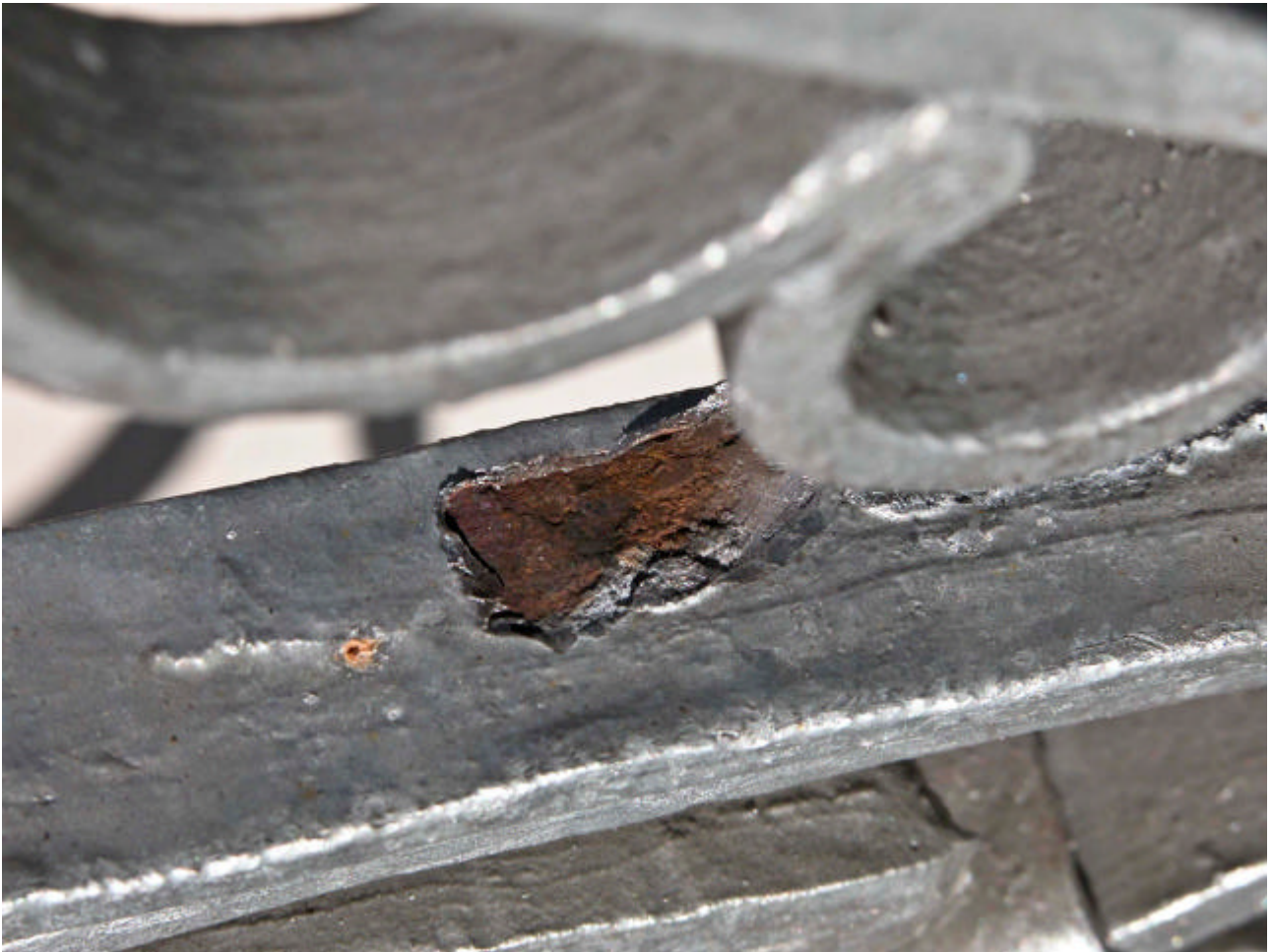
Figura 9 • Villa Barbaro a Maser. Cancelli seicentesco. Particolare della discontinuità della zincatura. Il ferro preindustriale è incompatibile con la zincatura che si stacca a scaglie lasciando scoperto il vecchio metallo. (TORSELLO)
