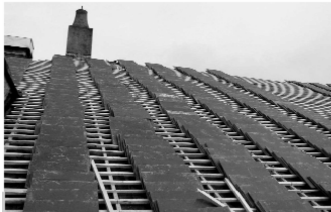
Figura 8 • Abbadini di ardesia disposti sul telaio di travicelli per essere montati con ganci.
