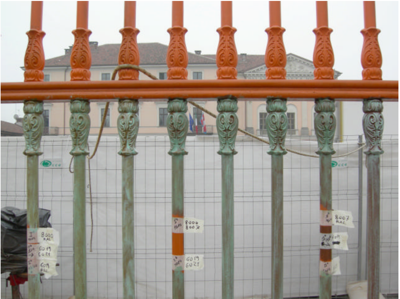
Figura 6 • Castello di Racconigi. Cancellata monumentale: parte superiore con una mano di minio su superficie sabbiata, parte inferiore con campionature colore realizzate con velature verdi su due mani di fondo marrone/bronzo ad interpretare le indicazioni dei documenti di calcolo e misura redatti nel 1843 da Ernest Melano che riportavano la dicitura “coloritura verde bronzo” o “coloritura in due riprese tinta bronzo”. (BERRONE - BERTOLOTTI)
