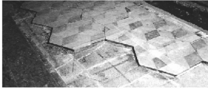
Figura 4 • Smontaggio del rivestimento marmoreo di un pavimento. Stacco delle tarsie per blocchi esagonali formati da dodici elementi ciascuno; ogni blocco è stato trasportato nell'attiguo cantiere di restauro e ripulito con bisturi e solventi dalla resina ancorata sulla faccia inferiore. (SAV)
