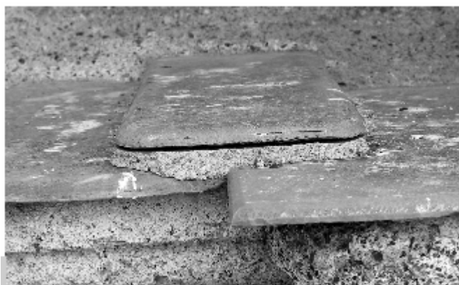
Figura 4 • Protezione dei giunti di una copertina in lastre di ardesia con altre lastre del medesimo materiale.
