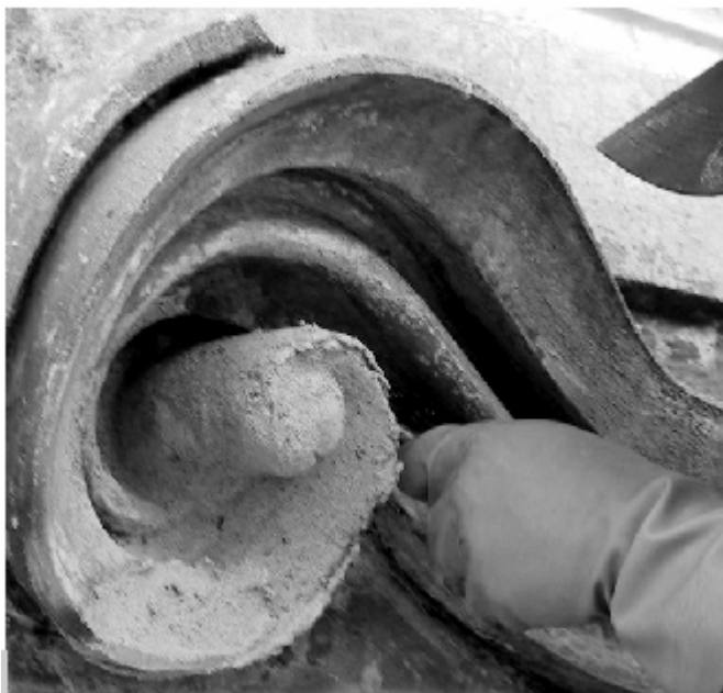
Figura 6 • Inizio della fase di modellazione dopo una prima stesura grossolana della malta necessaria all'integrazione del particolare decorativo.
