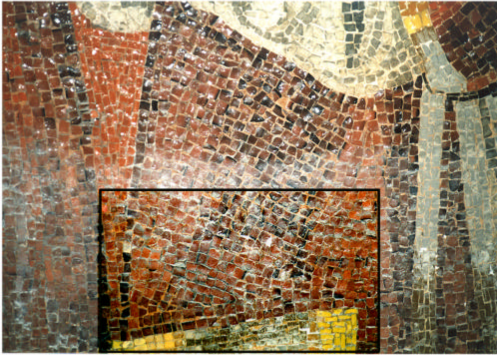
Figura 9 • Particolare di mosaico parietale prima della simulazione della pulitura (desalinizzazione). La superficie delle tessere si presenta opaca e biancastra per la presenza di sali. (DEP)
