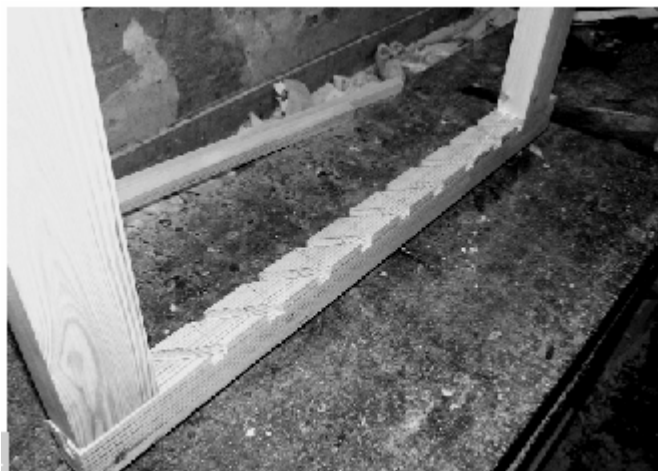
Figura 13 • Controllo e finitura dei tagli di alloggiamento delle stecche.
