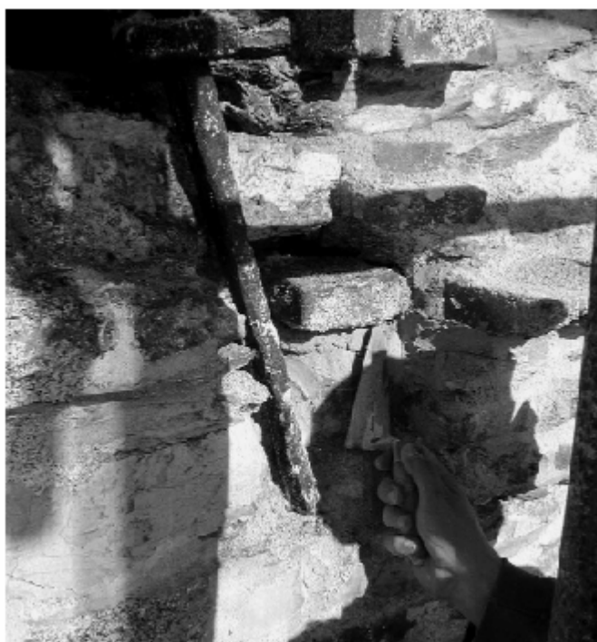
Figura 6 • Inserimento del primo mattone.
