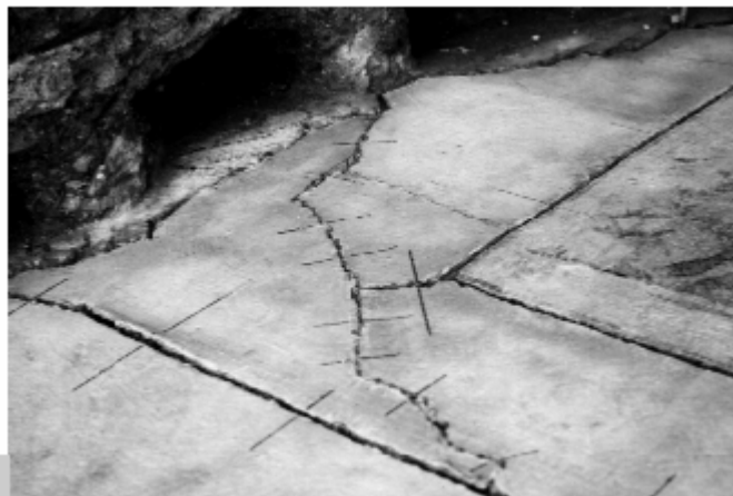
Figura 6 • Esecuzione dei contrassegni di richiamo, o testimoni, sui vari pezzi. Si tracciano tratti di collegamento a cavallo delle sezioni con pennarelli indelebili. (SRM)
