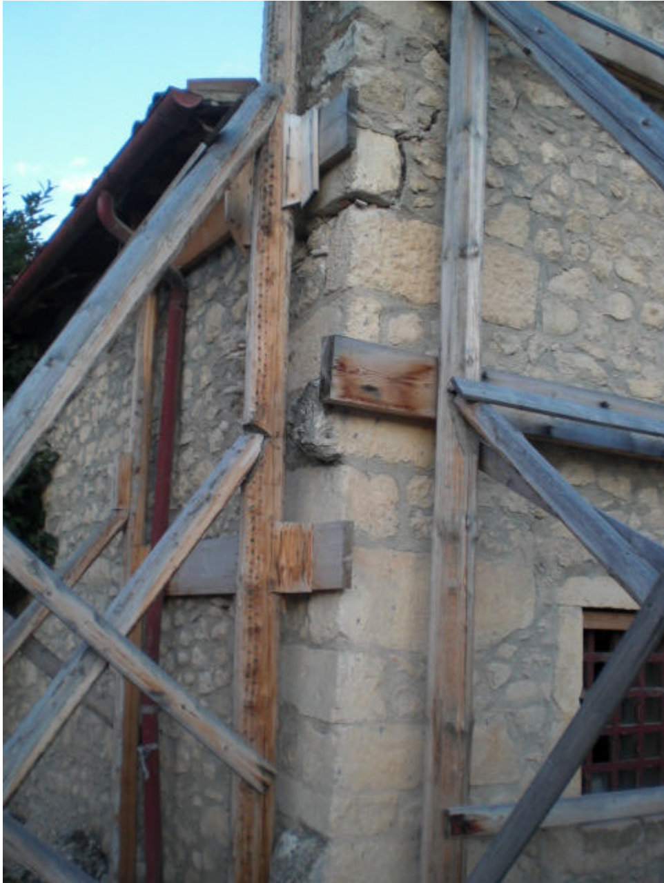
Figura 15 • Sistema di puntelli lignei di ritegno nel centro storico d L'Aquila, Aprile 2010. (BUC)
