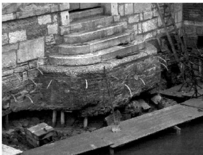
Figura 3 • Consolidamento delle fondazioni di un edificio veneziano. Dopo aver prosciugato il canale, si è proceduto al consolidamento tramite iniezioni. Si noti la presenza dei "tubicini testimone".
