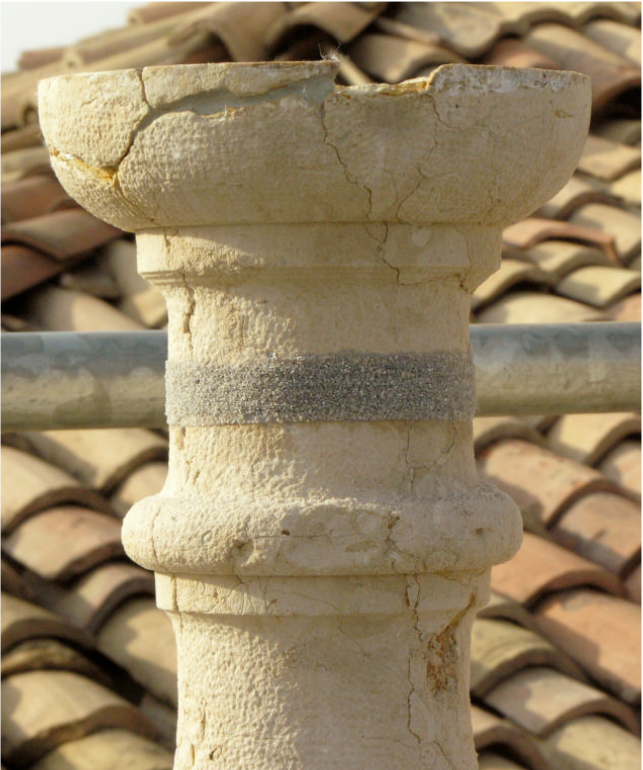
Figura 13 • Nastro di altezza ridotta in fibra di carbonio prima della stesura della malta di finitura. (ADORNI)
