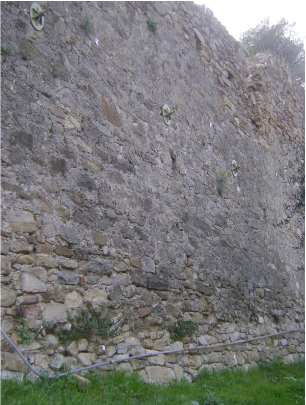
Figura 5 • Castello di Taggia (IM): gli interventi di consolidamento hanno comportato l'inserimento di otto catene poligonali di cerchiatura della torre, quattro per ogni livello, realizzate con cavi inox e golfari ancorati alla muratura. (BUC)
