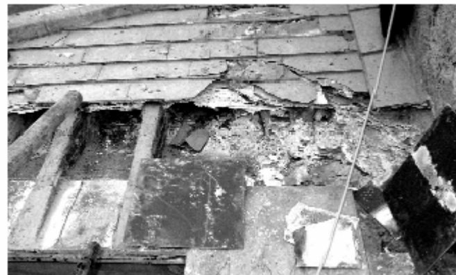
Figura 3 • Sostituzione graduale delle lastre d'angolo.
