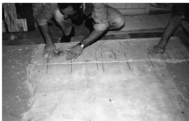
Figura 14 • Posizionamento con verifica dei testimoni a cavallo delle sezioni. (SRM)
