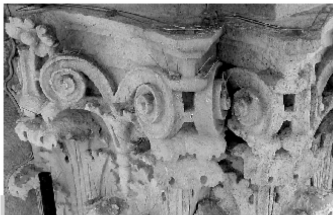
Figura 8 • Allontanamento di volatili con sistemi misti: mentre sulle volute sono stati applicati dei dissuasori ad aghi, sull'abaco del capitello si può vedere la linea del sistema elettrostatico. (CAF)
