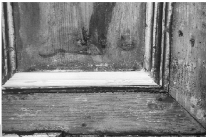
Figura 1 • Cornice con un tratto di modanatura sostituita o ricostruita e priva di doratura. (OPD) v. Tavn.
