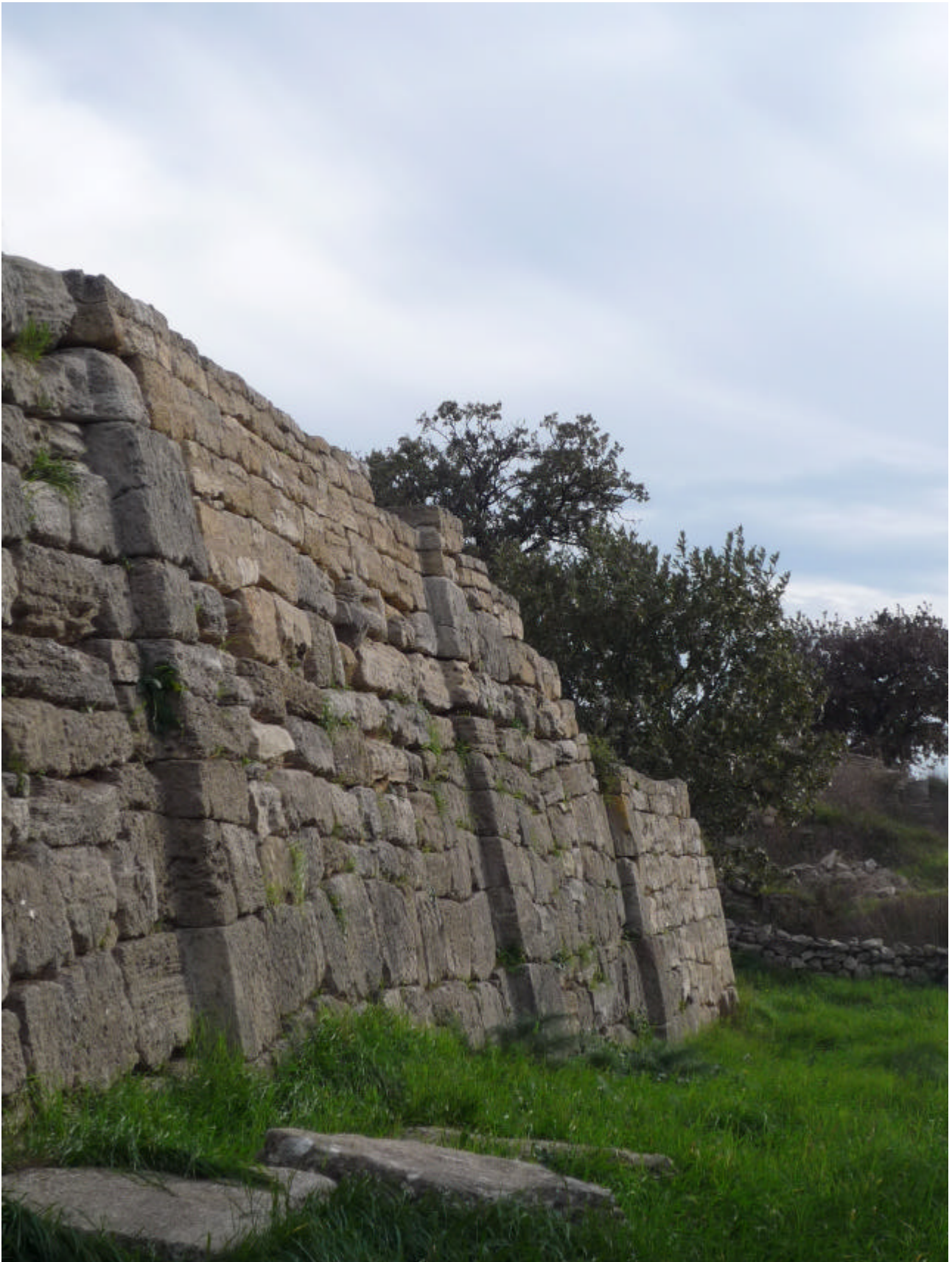
Figura 13 • Troia (Turchia), particolare di una delle cinte murarie della città in cui è visibile un intervento di integrazione esteso a tutta la profondità della struttura (BUC).
