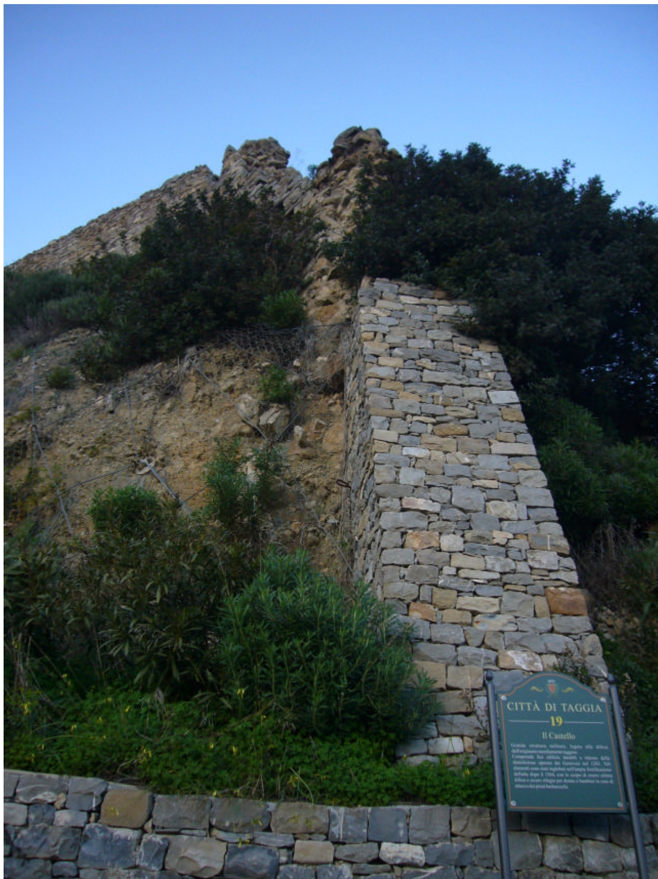
Figura 8 • Castello di Taggia (IM): sperone murario realizzato durante le opere di consolidamento delle murature perimetrali. (BUC)
