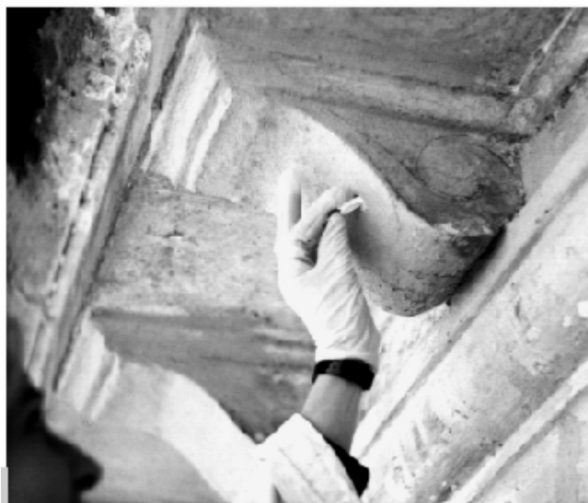
Figura 5 • È inserito il perno di acciaio inox, dopo averlo intinto nella stessa resina utilizzata per il fissaggio. Si inietta la seconda parte di resina.
