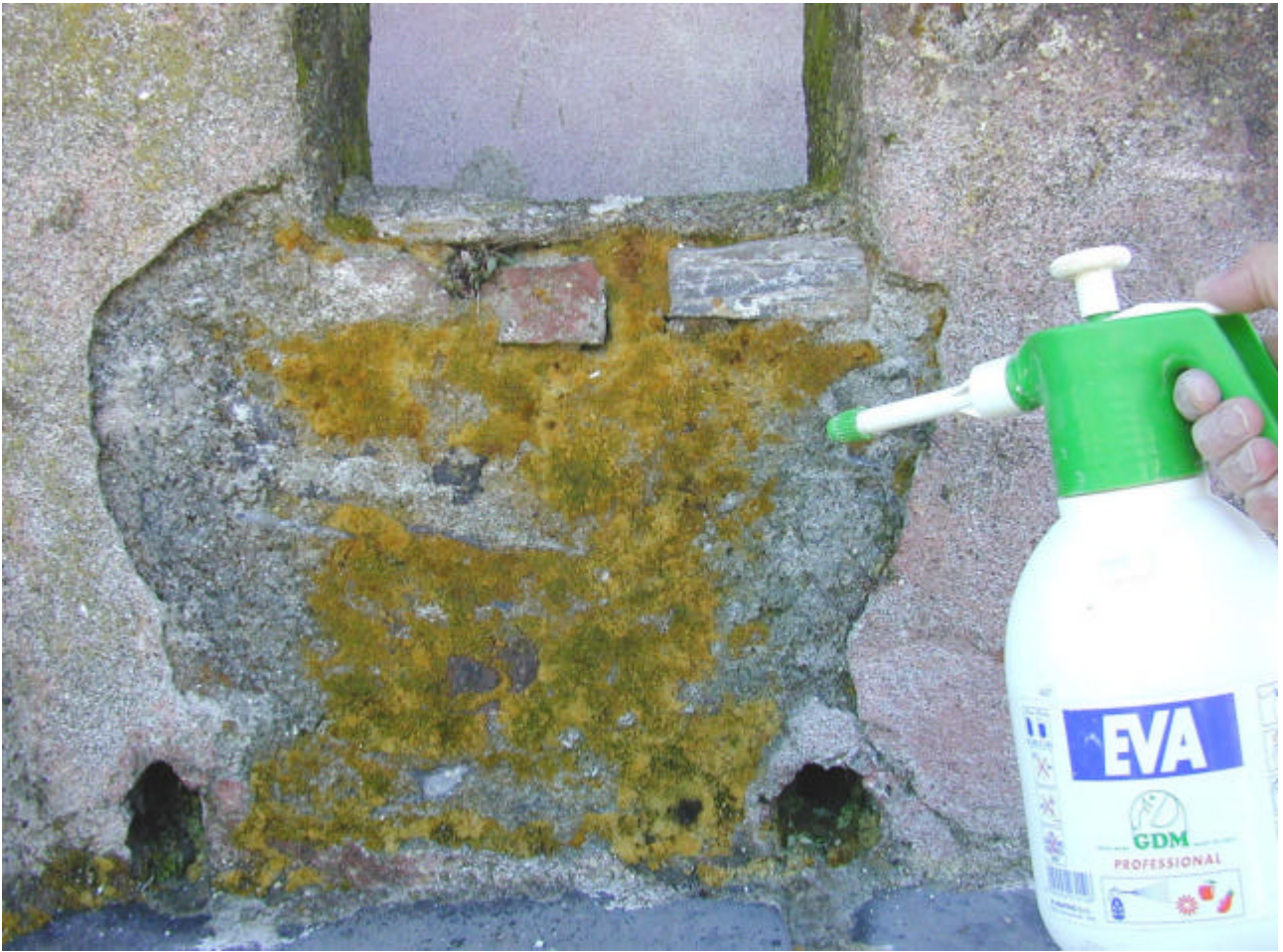
Figura 2 • Applicazione a spruzzo del liquido disinfestante.
