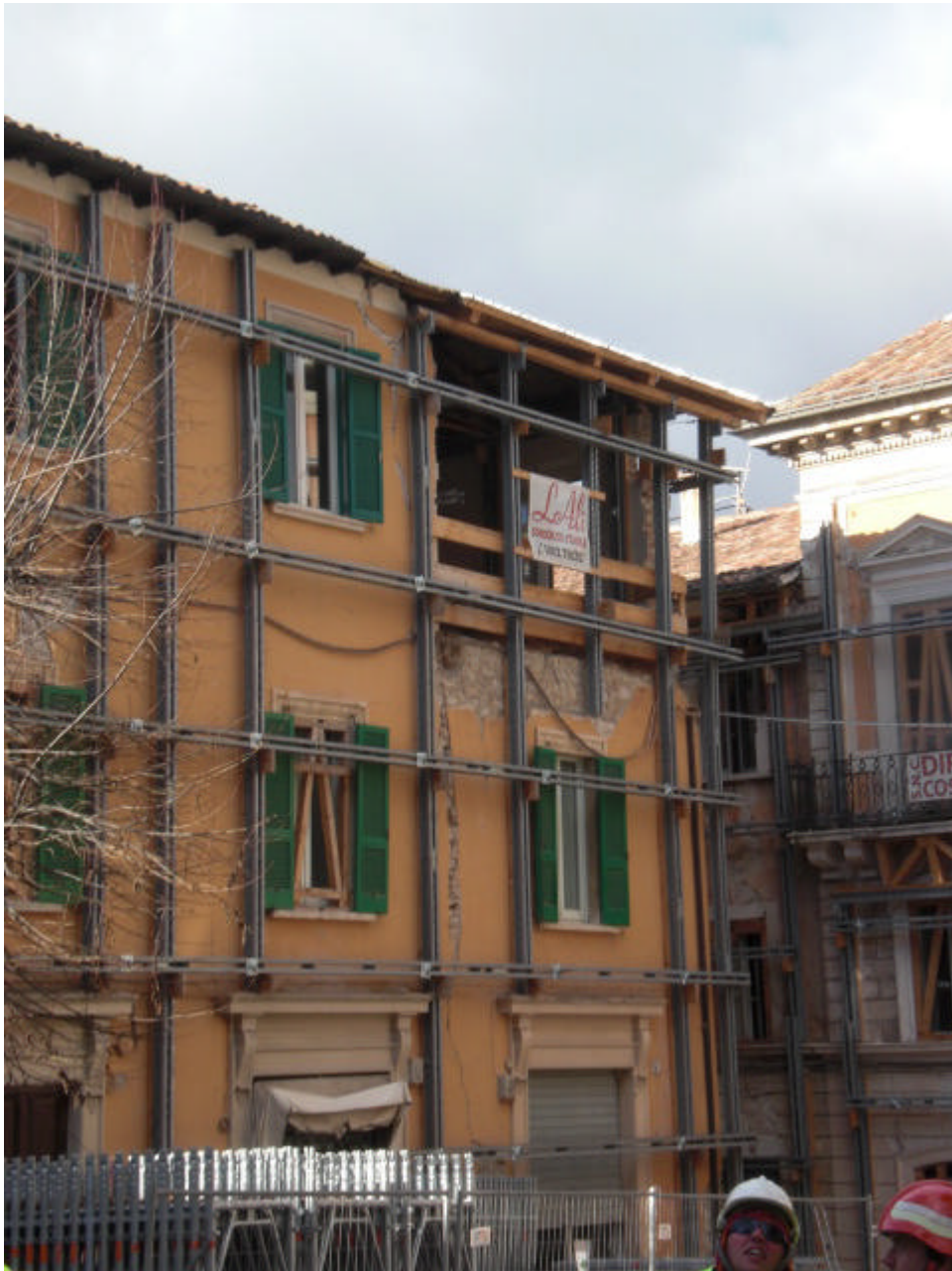
Figura 4 • Centro storico di L'Aquila: sistema provvisorio di tiranti e capichiave. (BUC)
