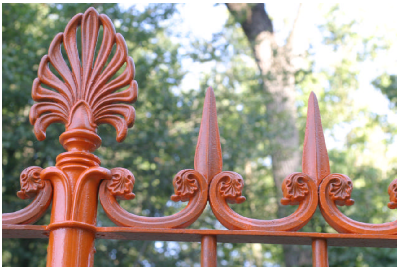
Figura 5 • Particolare della prima mano di minio su superficie sabbiata di una palmetta della cancellata. (BERRONE - BERTOLOTTI)
