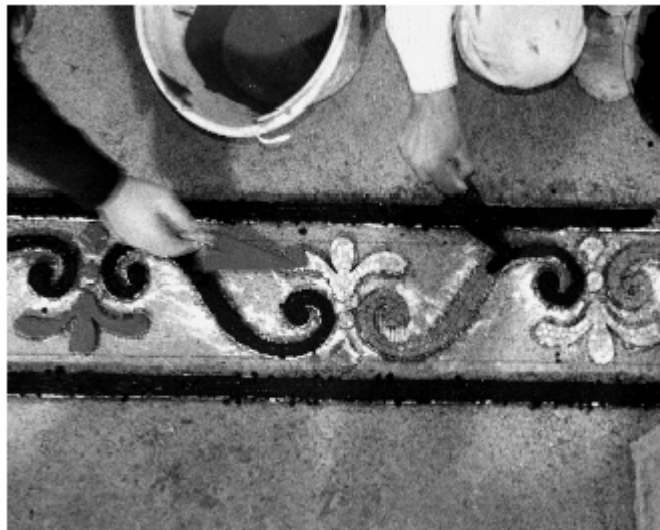
Figura 11 • Integrazione delle tessere sulla cornice di bordo. I giunti tra le tessere sono intasati con boiaccia colorata. (VIG)
