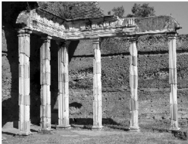
Figura 6 • Villa Adriana. Anastilosi con integrazione di blocchi di calcestruzzo lavorati come gli originali.
