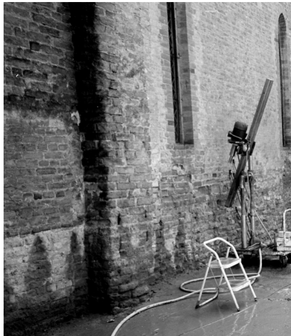
Figura 2 • Esecuzione dei fori di contenimento delle barre. Macchina carotatrice.
