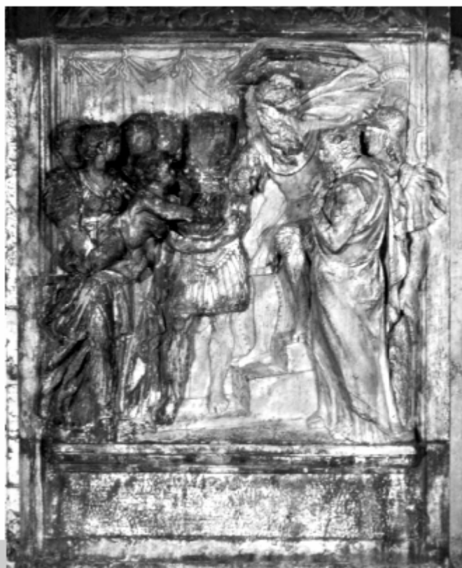
Figura 3 • Confronto tra due zone di superficie lapidea interessata da croste nere, prima e dopo la pulitura. (NFM)
