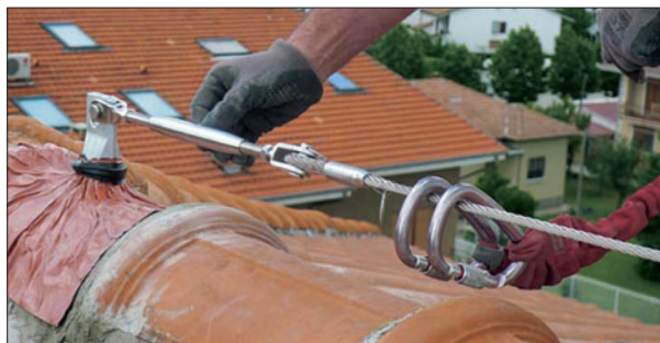
Figura 1 - Incorporazione tra ancoraggio e struttura di supporto.
