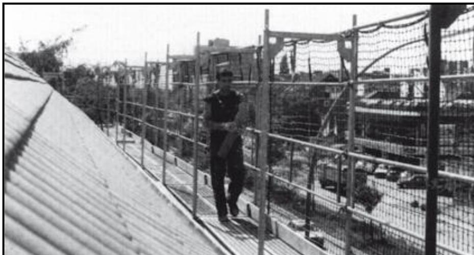
Per quanto attiene gli ancoraggi va svolta una verifica in funzione degli eventuali carichi di cui al calcolo progettuale suddetto. La norma di riferimento è la UNI EN 795. Si tiene a precisare comunque che l'aggiunta di sovrastrutture quali reti di sicurezza o altre opere provvisorie atte a diminuire la luce di passaggio di un corpo, va a modificare la condizione esistente di carico e quindi come tale va verificato in sede progettuale.
