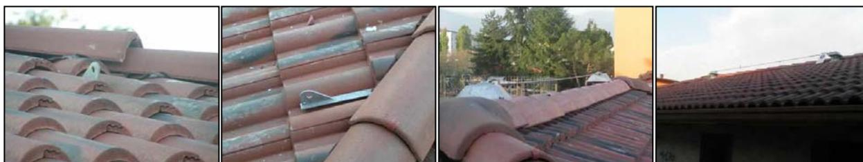
Esempi di sistemi di arresto caduta installati su coperture tradizionali
