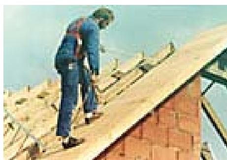
**Note:** bisogna valutare attentamente se sussiste il pericolo di caduta di materiali nella zona sottostante, al fine di predisporre adeguati sistemi di protezione (parapetti pieni, tavolati, mantovane) o per il deposito in quota dei materiali.
