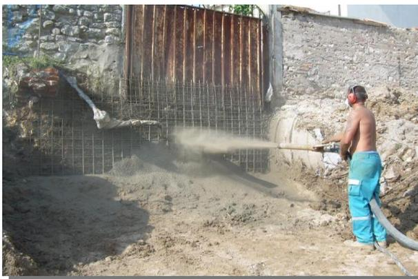
Lo spritz-beton è un **conglomerato cementizio** che viene spruzzato verso la superficie con una lancia ad alta pressione; viene utilizzato per la protezione degli scavi di fondazione, per il consolidamento di pendii e scarpate, per lavori di ripristino delle costruzioni in calcestruzzo degradate, per la protezione dall'eventuale caduta di materiale negli scavi in roccia, ed infine per bloccare le venute di acqua dalle pareti dello scavo.
