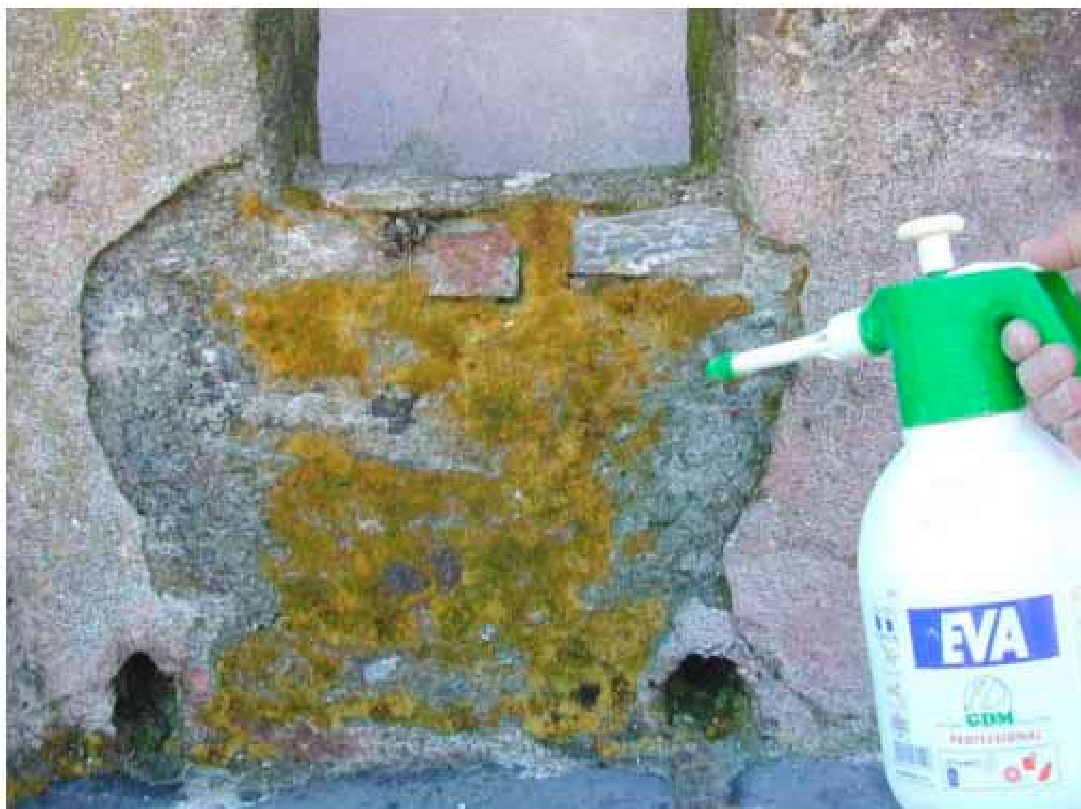
Figura 2 • Applicazione a spruzzo del liquido disinfestante.
