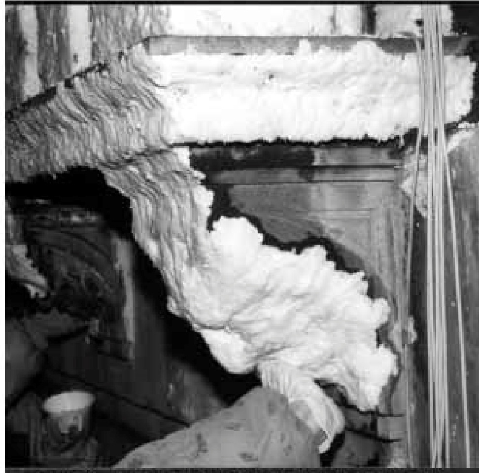
Figura 3 • Impacco in polpa di carta impregnata di biocida.
