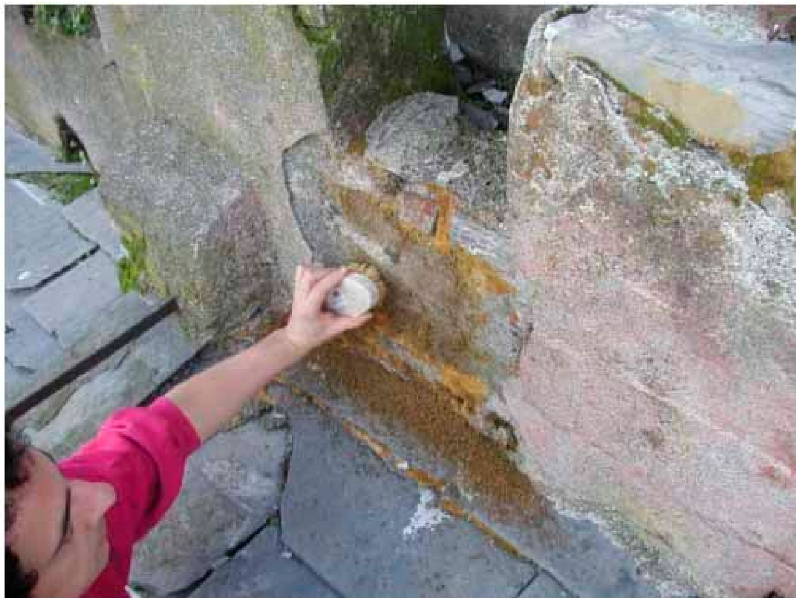
Figura 5 • Eliminazione della patina biologica secca, mediante spazzolatura.
