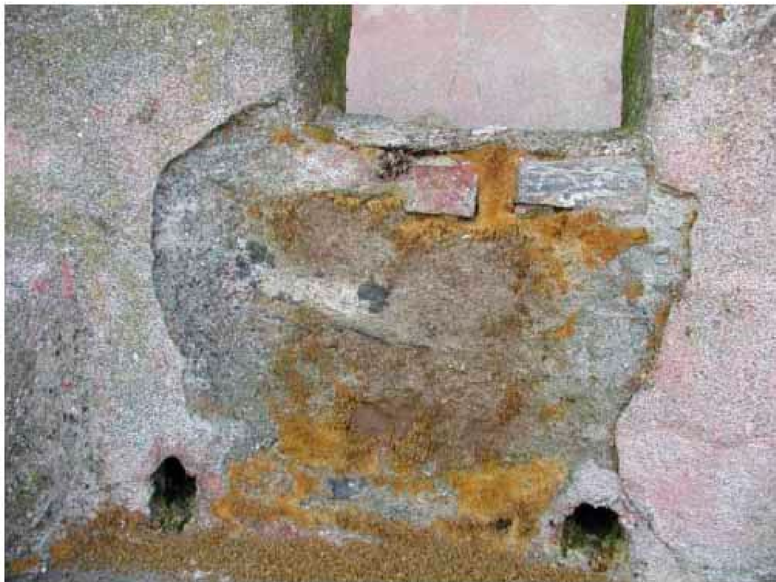
Figura 6 • Risultato parziale della disinfestazione.
