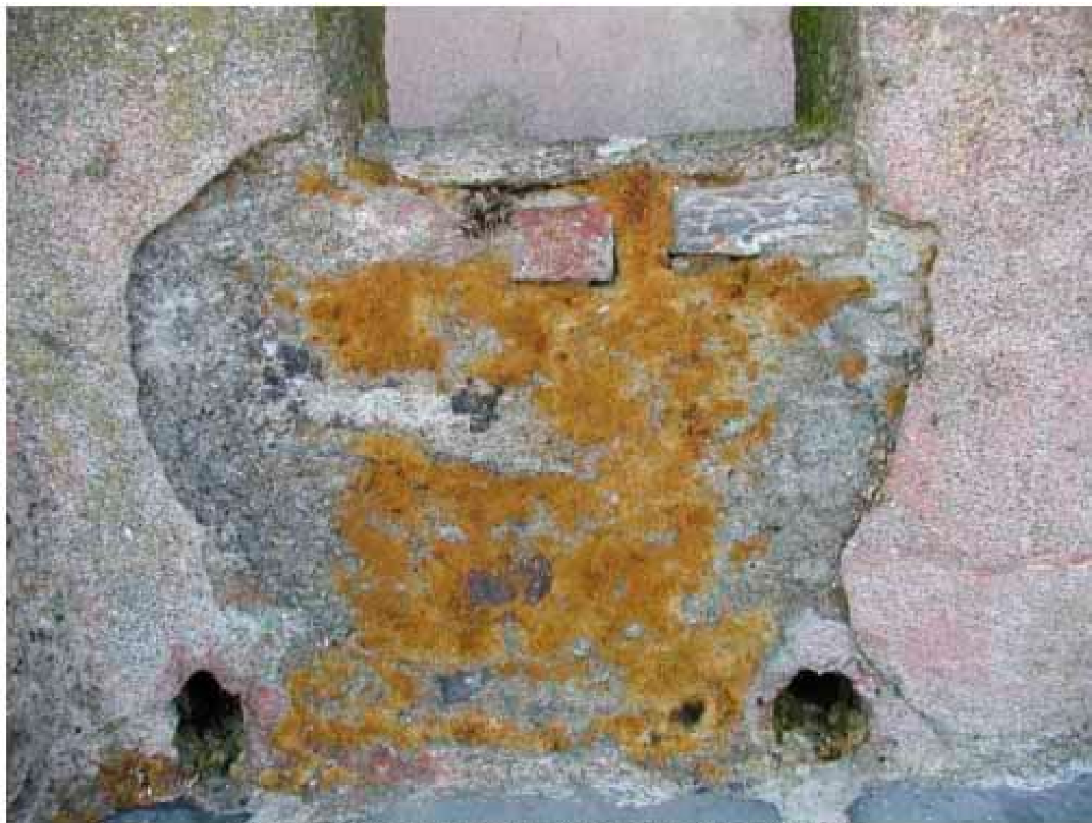
Figura 4 • Patina biologica dopo l'applicazione del disinfestante.
