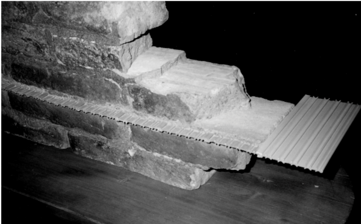
Figura 2 • Taglio meccanico della muratura: barriera con lamine impermeabili . Bande in profilato nervato di PVC.
