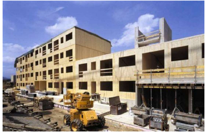
Struttura a pannelli XLam
