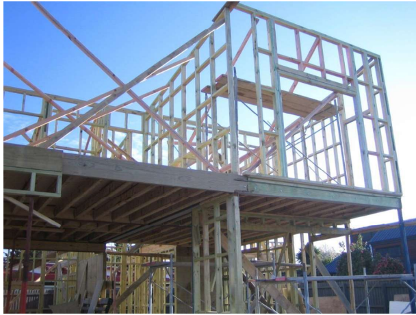
Struttura leggera intelaiata
