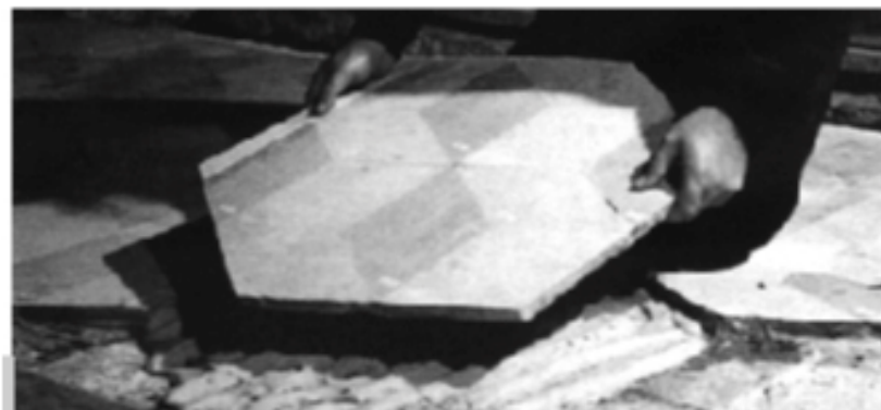
Figura 7 • Smontaggio del rivestimento marmoreo di un pavimento. Dopo aver steso la resina sulla faccia inferiore del primo esagono e sulla superficie corrispondente dello zatterone in pietra, può avvenire la posa del primo elemento. La resina deve essere preparata ogni volta, per ogni singolo pezzo. (SAV)
