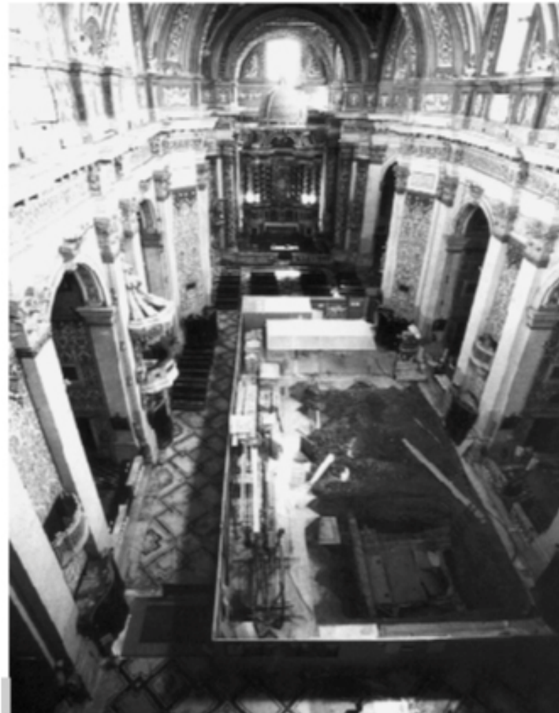
Figura 8 • Il pavimento dell'aula è stato smontato per restaurarne le superfici marmoree e consolidarne il sottofondo, consentendo, allo stesso tempo, l'apertura di un cantiere archeologico. (SAV)
