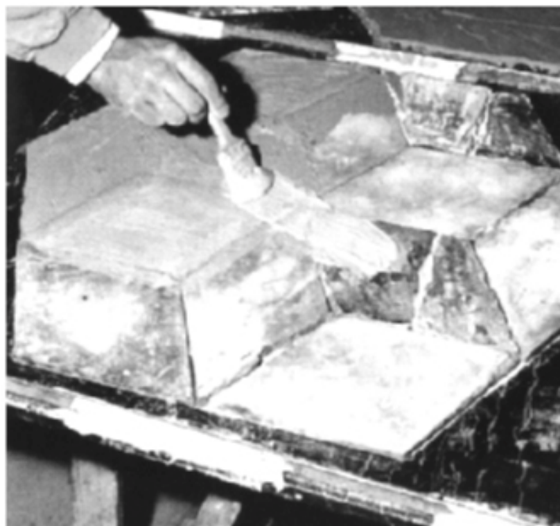
Figura 6 • Smontaggio del rivestimento marmoreo di un pavimento. Il riposizionamento e il fissaggio degli "steleri" delle tarsie marmoree è stato eseguito riproponendo la tecnica tradizionale con resina naturale (colofonia come legante e polvere di marmo come inerte). In questa fase sono stese a pennello due mani di resina sulla faccia inferiore degli esagoni. (SAV)
