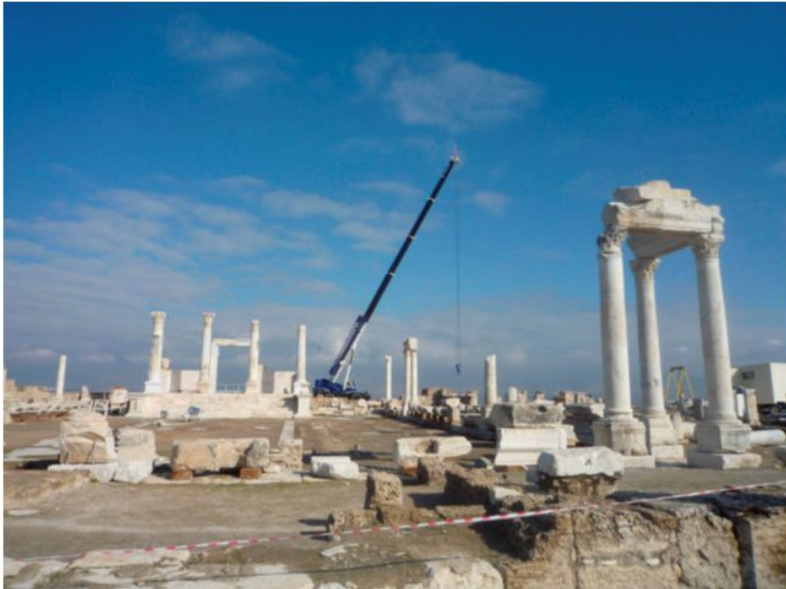
Figura 13 • Turchia, sito archeologico di Laodicea: è visibile il mezzo di sollevamento utilizzato per lo spostamento degli elementi di dimensioni maggiori. (BUC)
