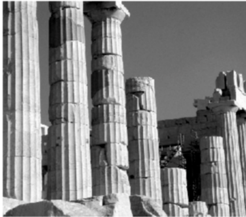
Figura 2 • Acropoli di Atene, colonne ricomposte con rocchi antichi e parti riprodotte.
