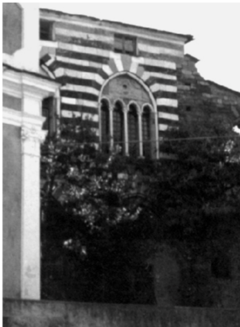
Figura 3 • Un altro prospetto dell'edificio della fig. 2 dopo la demolizione delle tamponature occludenti le finestre. Si noti come gli interventi di finitura abbiano radicalmente cambiato e "rinnovato" l'aspetto della vecchia costruzione.
