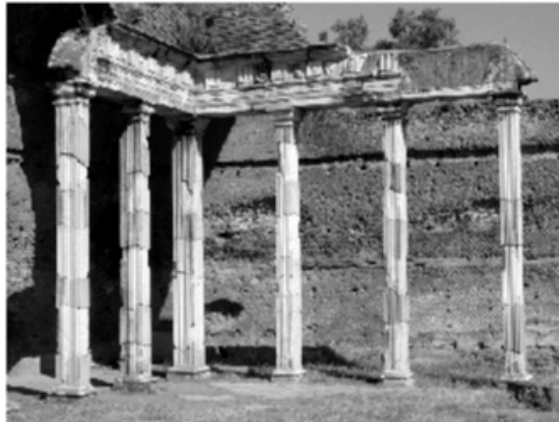
Figura 6 • Villa Adriana. Anastilosi con integrazione di blocchi di calcestruzzo lavorati come gli originali.
