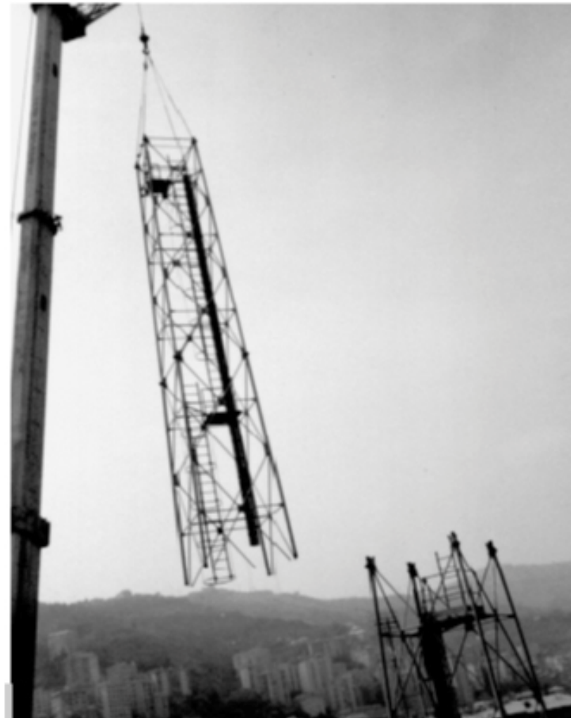
Figura 4 • Demolizione di un traliccio metallico con l'ausilio di una gru.
