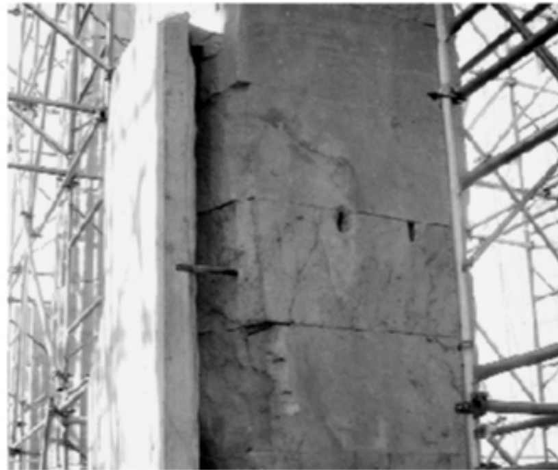
Figura 2 • Un lastrone di rivestimento è rimontato per anastilosi all'interno di un cantiere di restauro archeologico.
