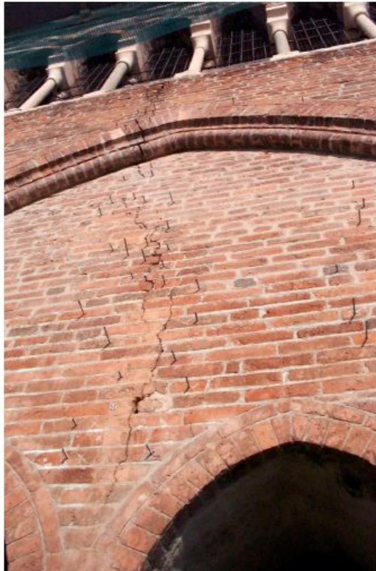
Fig. 6 • Torrazzo di Cremona. Ancoraggio dei laterizi distaccati della cortina esterna con perni in acciaio inox di piccolo diametro. (RONCAI)
