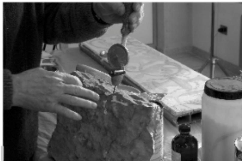
Figura 5 • Se la parte distaccata non è facilmente raggiungibile, è possibile praticare dei fori con un microtrapano con punte molto sottili. (ZAM)
