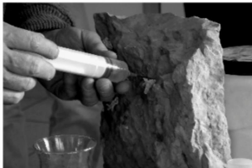
Figura 6 • L'incollaggio in profondità è eseguito utilizzando siringhe, assicurandosi che il distacco sia riempito il più possibile e procedendo a una immediata pulitura in caso di fuoriuscita del prodotto. (ZAM)
