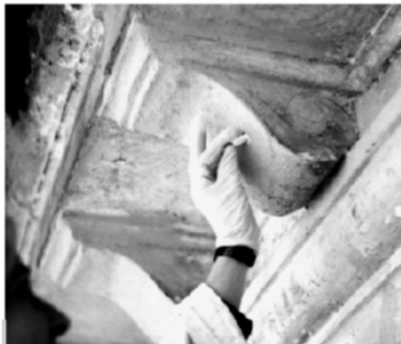
Figura 5 • È inserito il perno di acciaio inox, dopo averlo intinto nella stessa resina utilizzata per il fissaggio.
