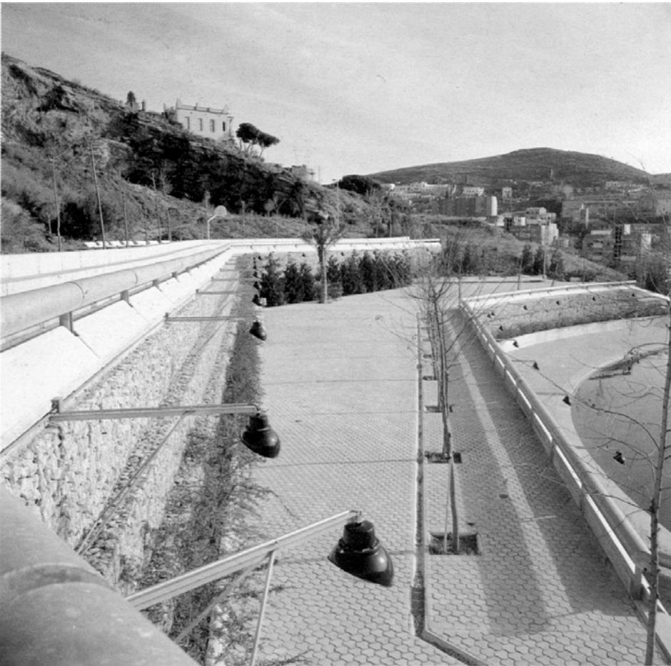
Gradinate realizzate con la tecnologia delle costruzioni stradali ("gabbionate" in reti metalliche riempite con blocchi di pietra)
