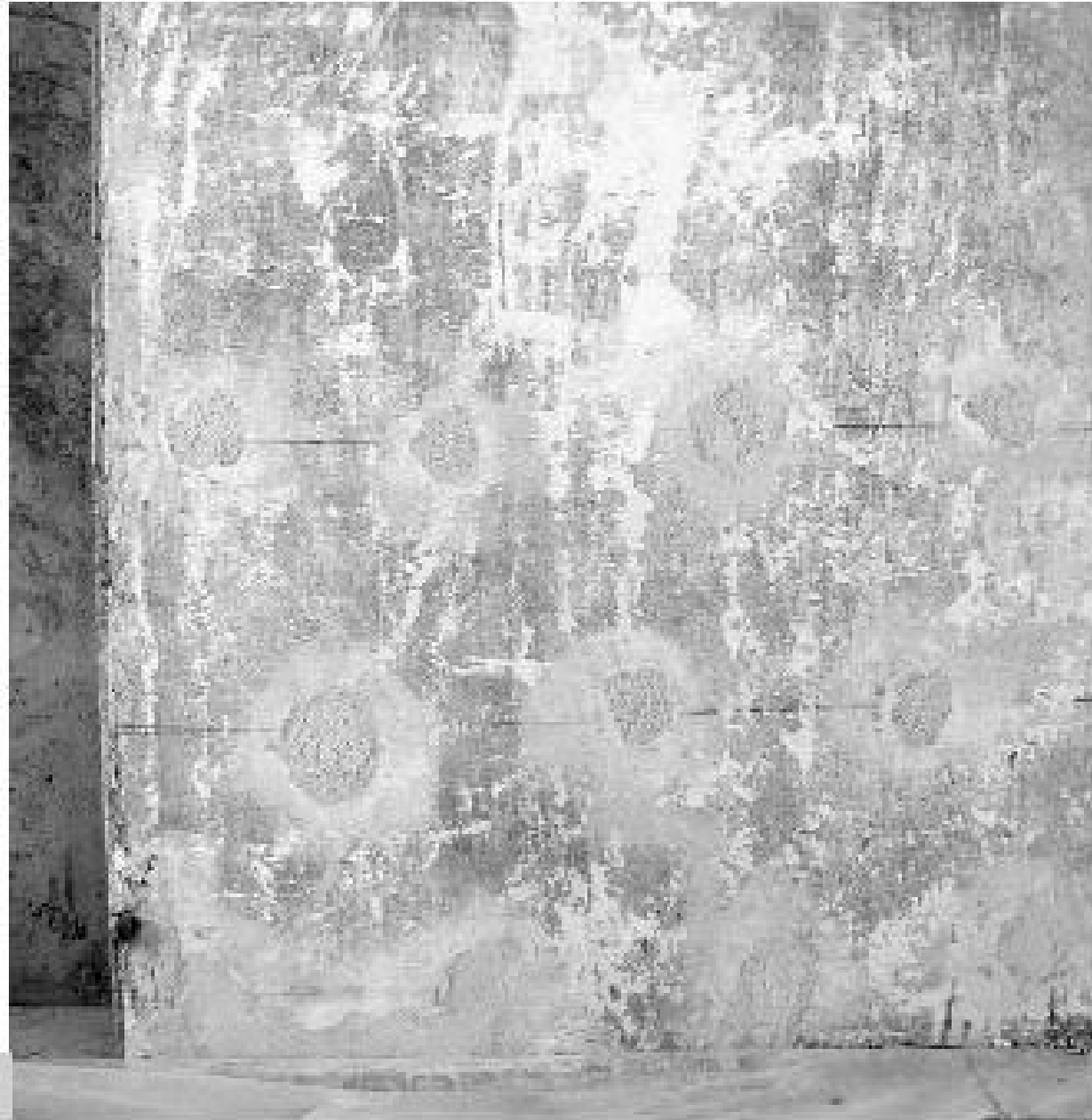
Figura 10 • Stuccatura dei fori di iniezione. (CAF)
