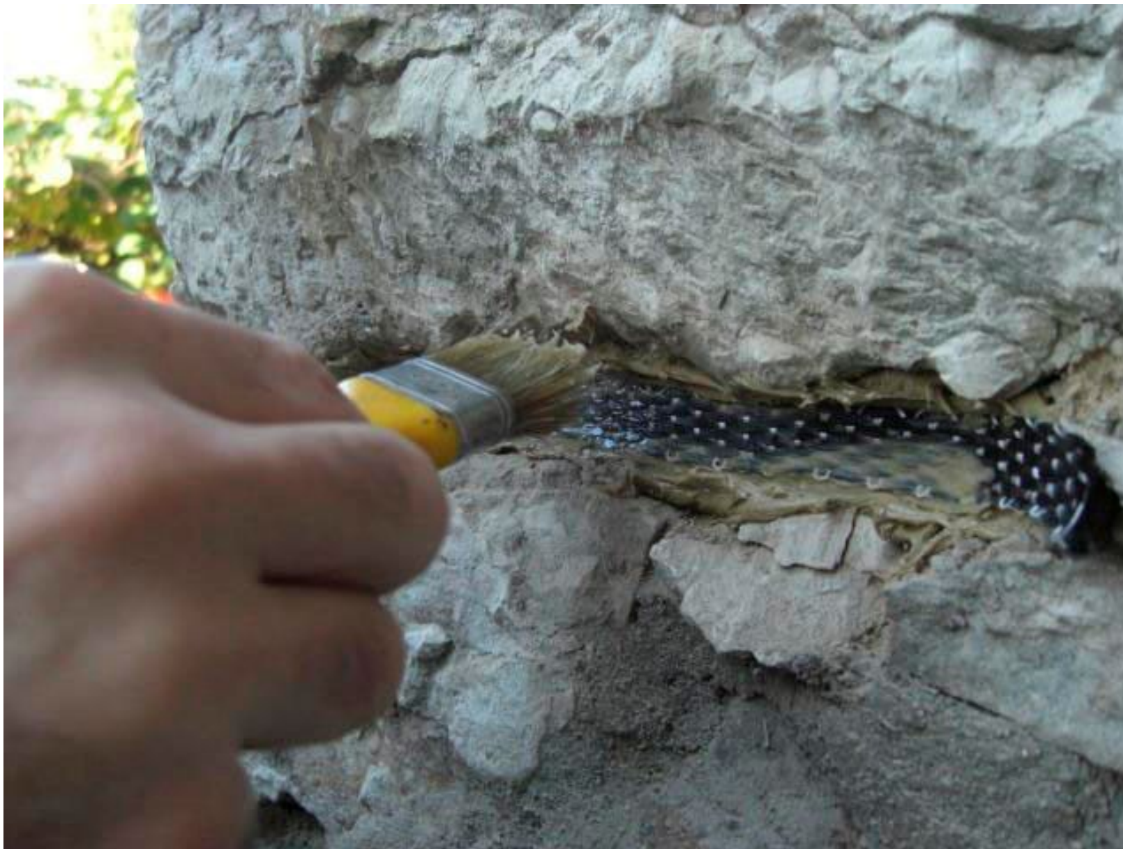
Figura 16d • Fasciatura inserita nei giunti di malta. Saturazione dei nastri in fibra in carbonio con resina epossidica fluida. (IAR)
