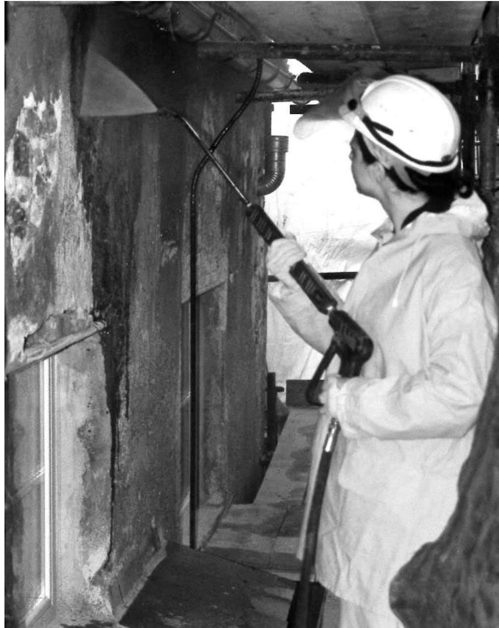
Figura 11 • Operatore durante il consolidamento.
