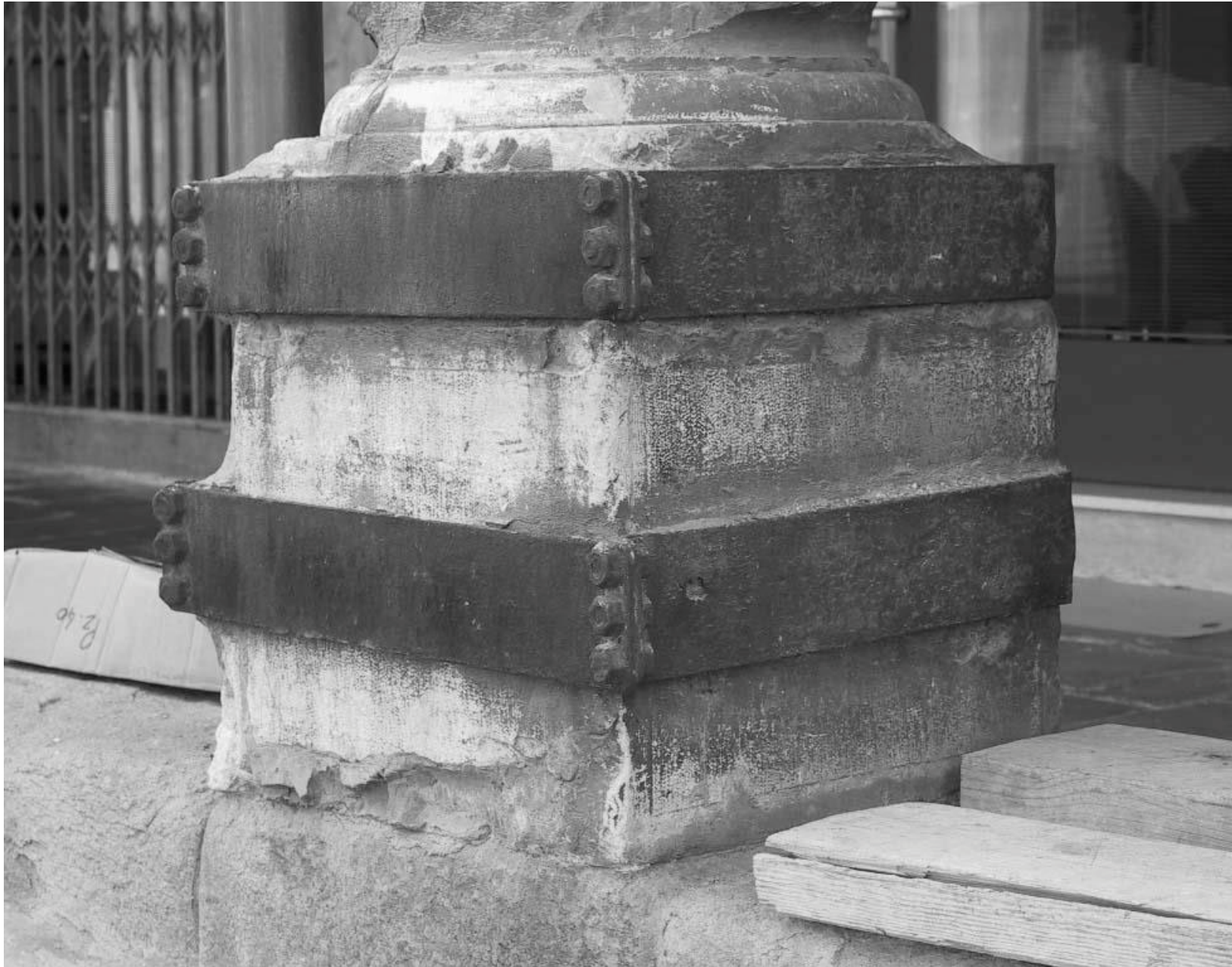
Figura 6 • Pesanti cerchiature al piedistallo di una colonna.
