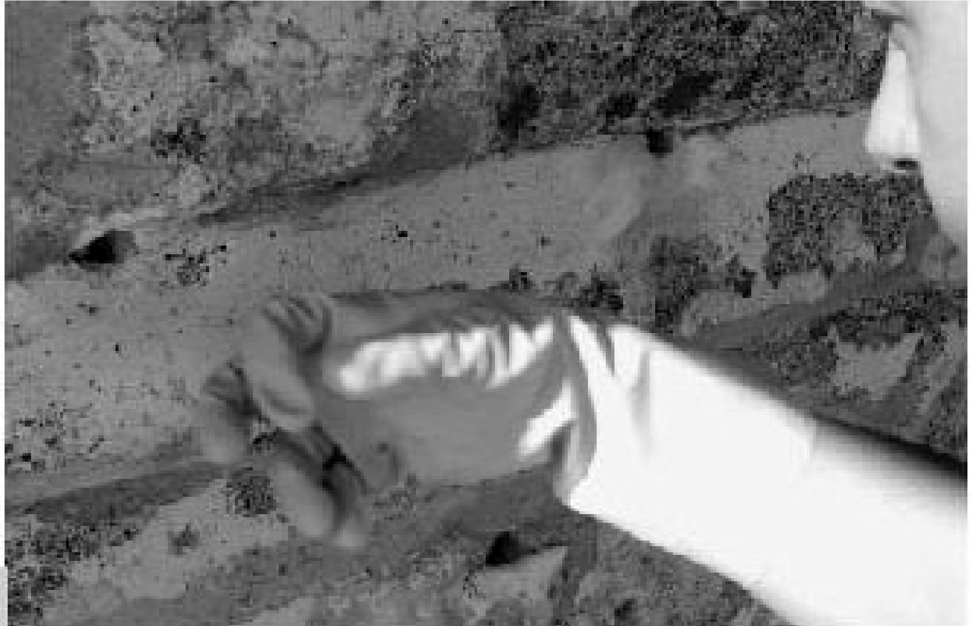
Figura 7 • Battitura tendente a facilitare la discesa del consolidante.
