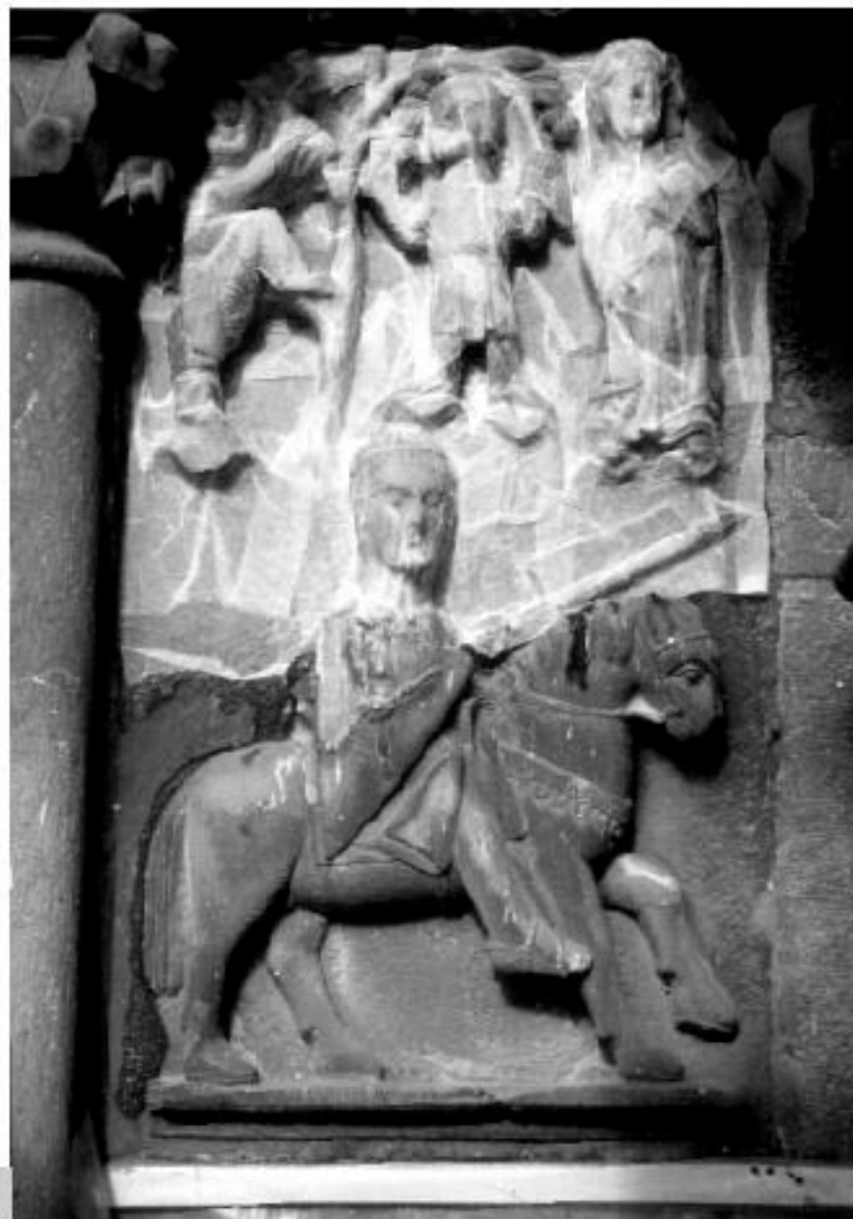
Figura 2 • Sulla superficie lapidea decoesa ed esfoliata si esegue una velinatura con fogli di carta giapponese per proteggerla sia dal contatto diretto del pennello con il quale è applicato il prodotto consolidante, sia dal particolato atmosferico e dalle polveri che potrebbero aggredire la superficie a impregnazione avvenuta. (NFM)
