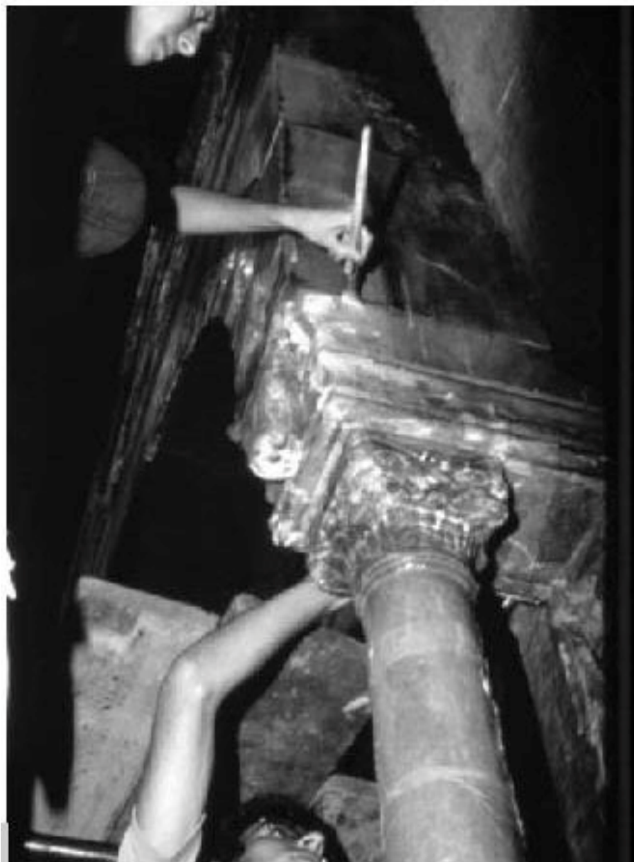
Figura 3 • Applicazione della velinatura. (NFM)(CSD02-PAN)
