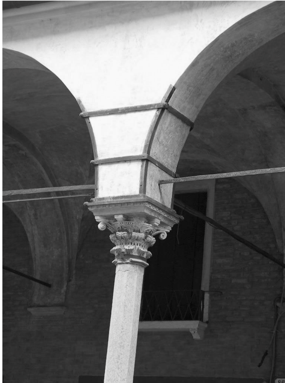
Figura 2 • Cerchiatura al collarino del capitello e ingabbiatura alle reni degli archi.
