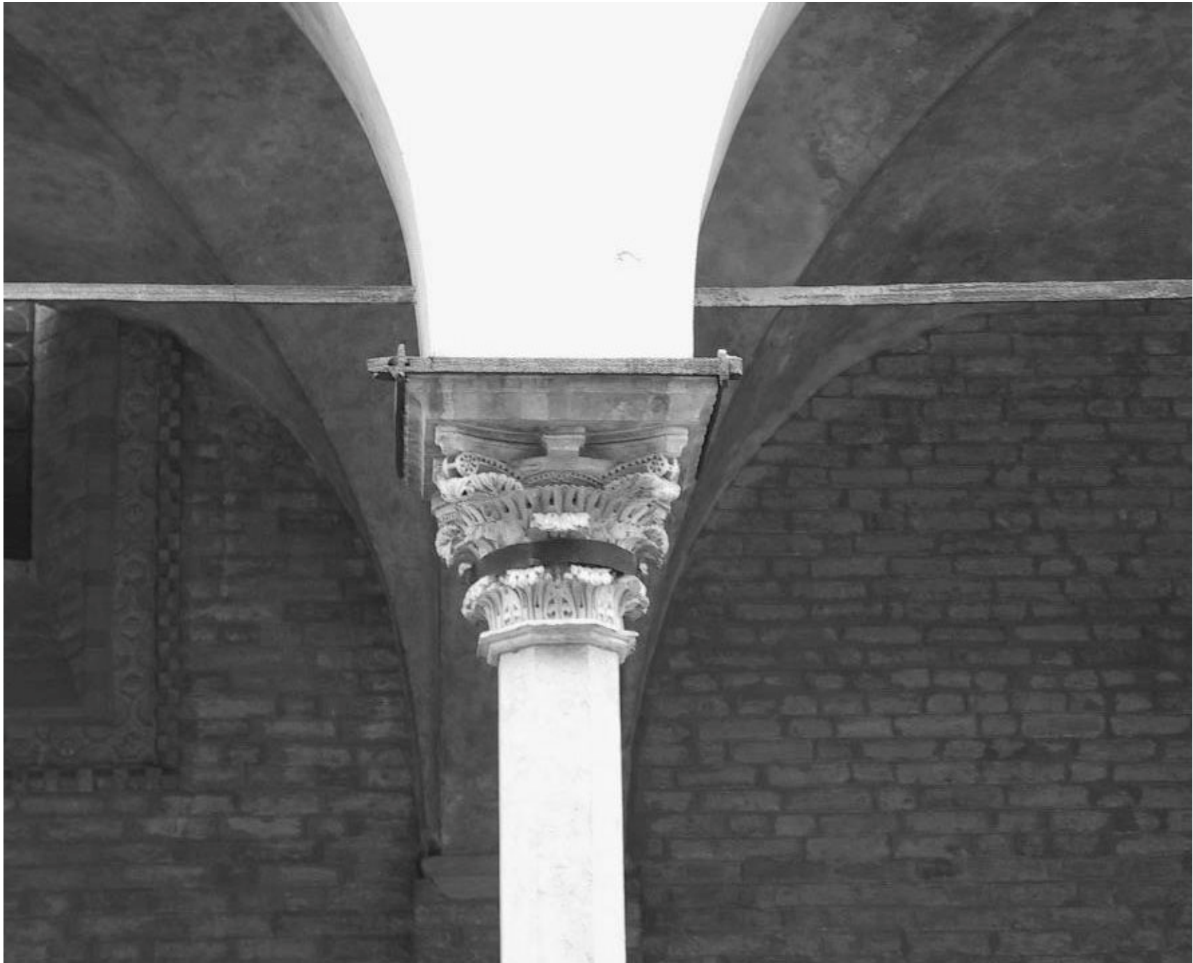
Figura 1 • Cerchiatura del capitello e del pulvino.
