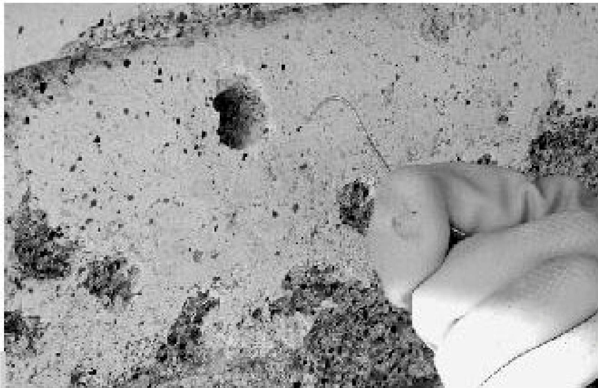
Figura 5 • Pulitura e creazione dei canali di penetrazione del consolidante.
