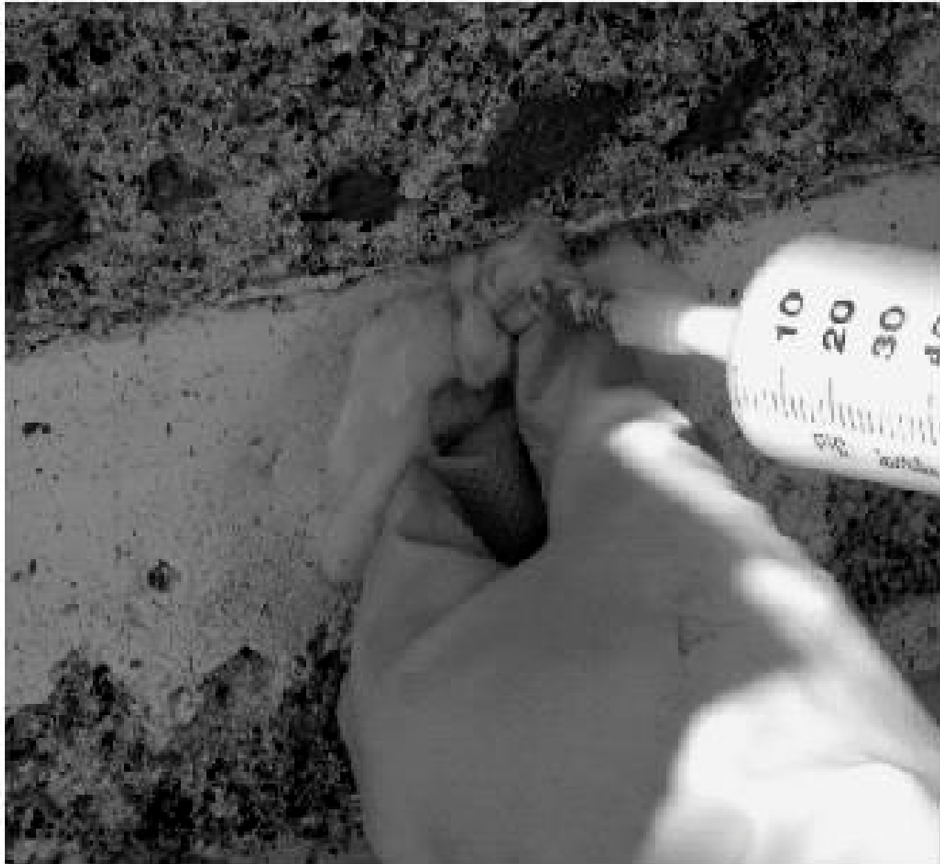
Figura 6 • Iniezione del consolidante (osservare l'impiego di batuffoli di ovatta per evitare perdite e colature).
