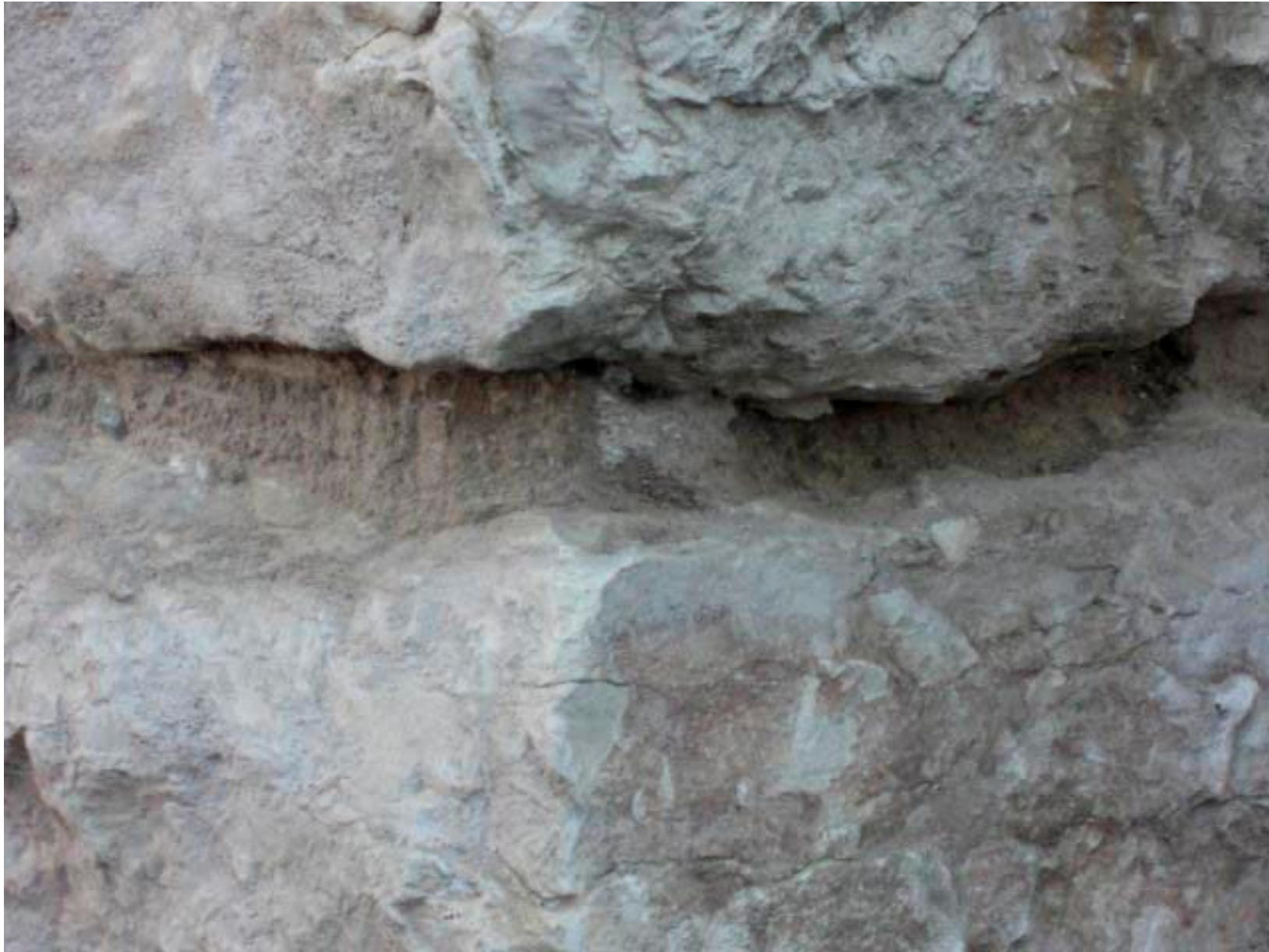
Figura 16a • Fasciatura inserita nei giunti di malta. Scarnitura e pulizia del giunto previo arrotondamento dello spigolo. (IAR)
