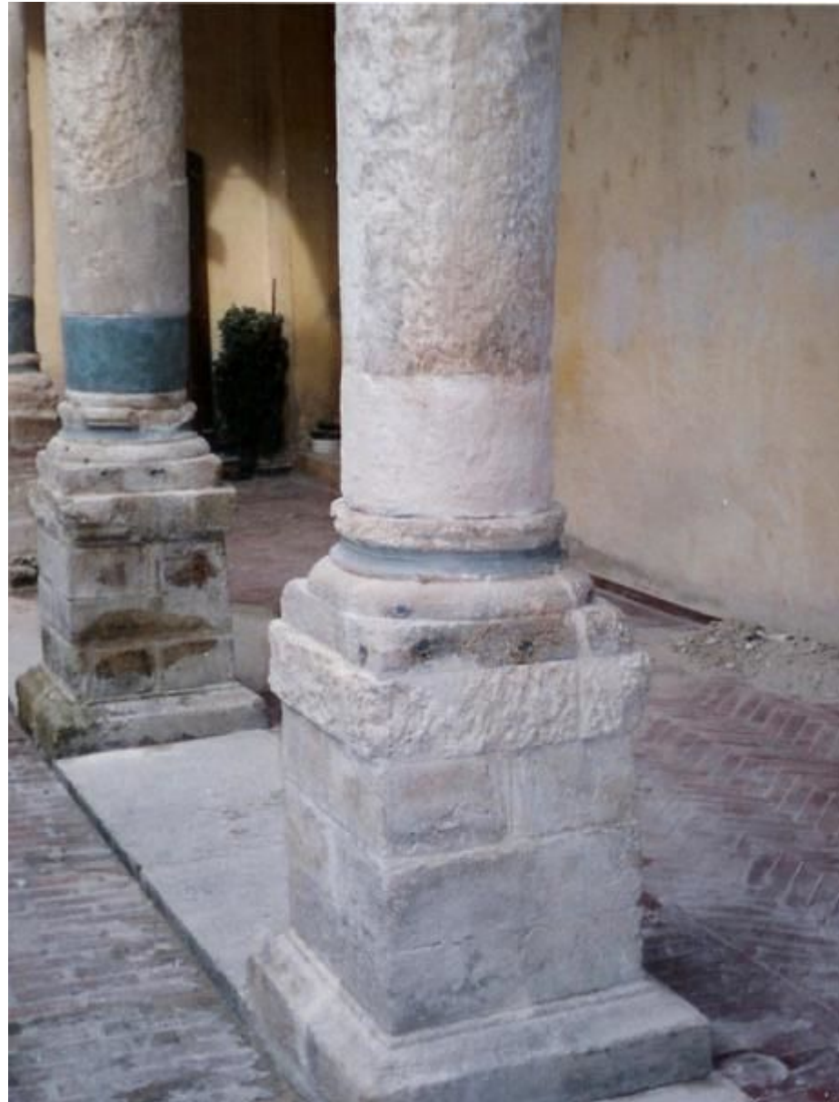
Figura 15 • Fasciature applicate alla base delle colonne. Nella colonna in primo piano è visibile la finitura con malta (calce naturale e inerti ricavati dalla frantumazione del medesimo litotipo della colonna). (KIMIA)
