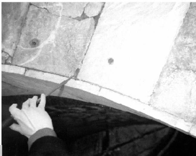
Figura 4 • Eliminazione in opera di vecchio stucco. (OPD)
