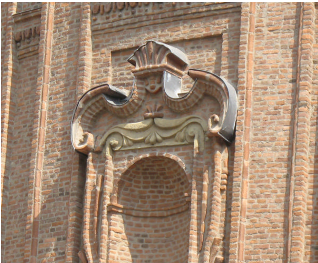
Figura 6 . Torino, Palazzo Carignano, particolare delle copertine di piombo a protezione degli elementi sporgenti della facciata di (NAP).
