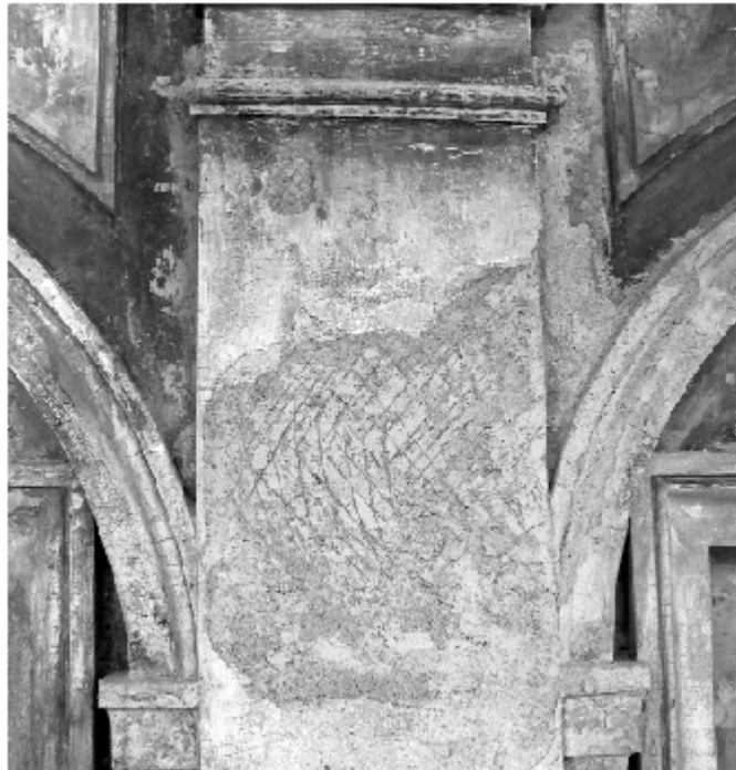
Figura 6 • Rappezzo di una parasta intonacata e dipinta: fase precedente alla finitura.
