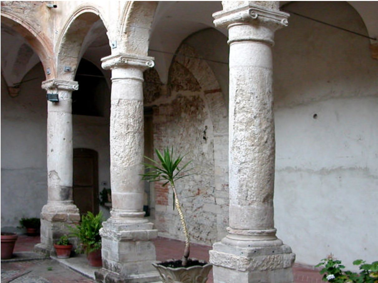
Figura 11 • Fasciature con nastri in fibra di carbonio applicate alla base e alla sommità del fusto delle colonne. (KIMIA)
