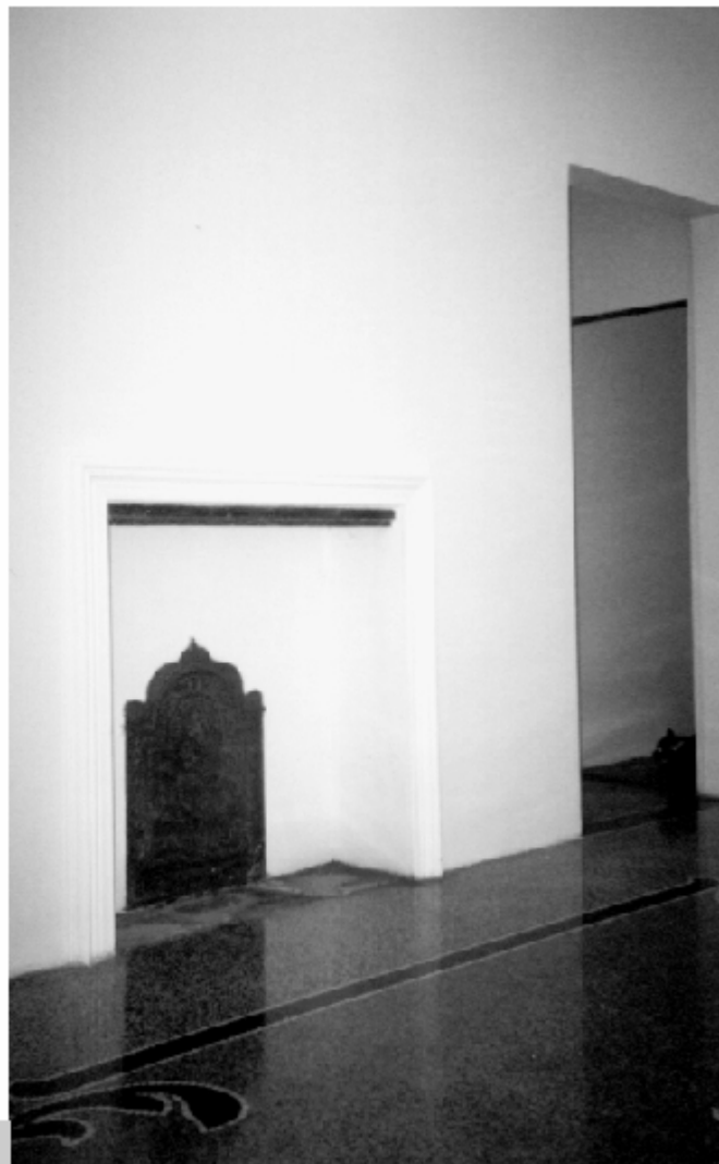
Figura 7 • Lo stesso cantiere della fig. 6 a lavori terminati. Si noti come l'abbattimento di un tratto di parete sia stato indotto dalla creazione di un caminetto.
