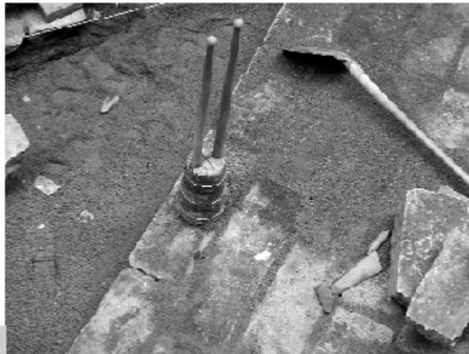
Figura 11 • Tre utensili tipici utili al rimontaggio dei tacchi: mazzapicchio, badile, cazzuola.
