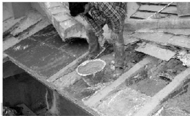
Figura 2 • Messa in opera delle lastre di gronda.
