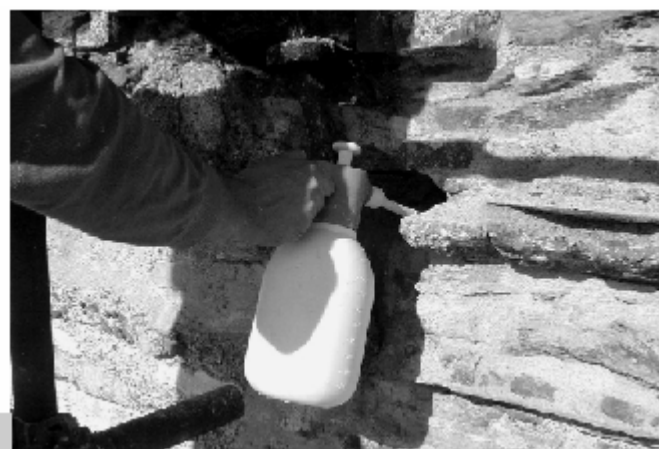
Figura 4 • Prima di applicare la malta, si bagna il supporto.
