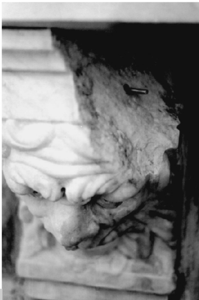
Figura 1 • Mensola di marmo. Per ripristinare la continuità tra il frammento e l'oggetto da cui è separato, è possibile ricorrere, tra gli altri metodi disponibili, all'impiego congiunto di perni e di adesivi.
