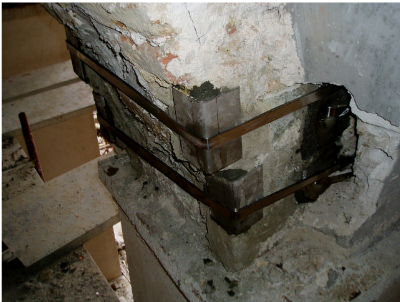
Figura 3 • Corleone (Palermo), convento di S. Agostino, esempio di terminale angolare impiegato nel rinforzo di un arco con il sistema CAM; Mauro Cilia, 2007.
