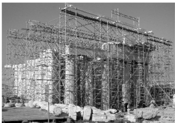
Figura 4 • Acropoli di Atene, il cantiere con le impalcature metalliche durante i lavori di restauro.
