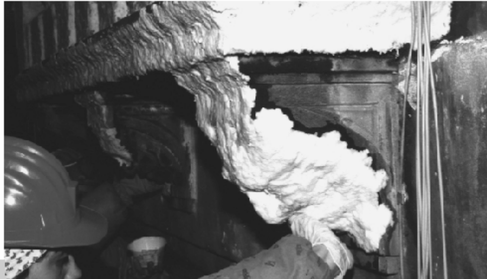
Figura 1 • Applicazione dell'impacco di polpa di cellulosa sulla superficie di una mensola di marmo.
