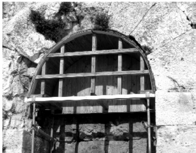
Figura 8 • Puntellatura "a sbalzo" realizzata in legno e metallo nelle arcate del teatro di Erode Attico ad Atene.
