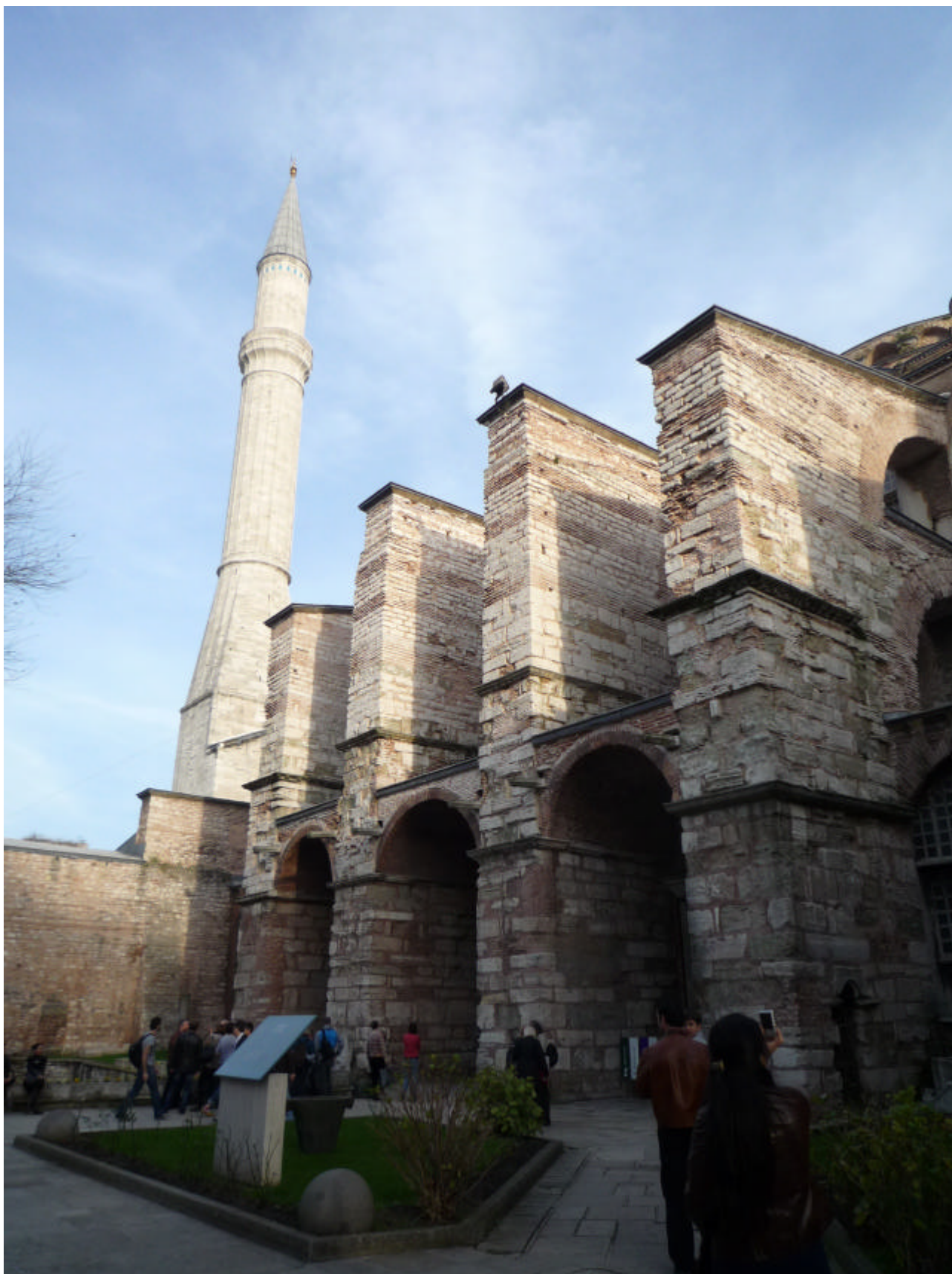
Figura 3 • Speroni murari presso l'ingresso di Santa Sofia, Istanbul. (BUC)
