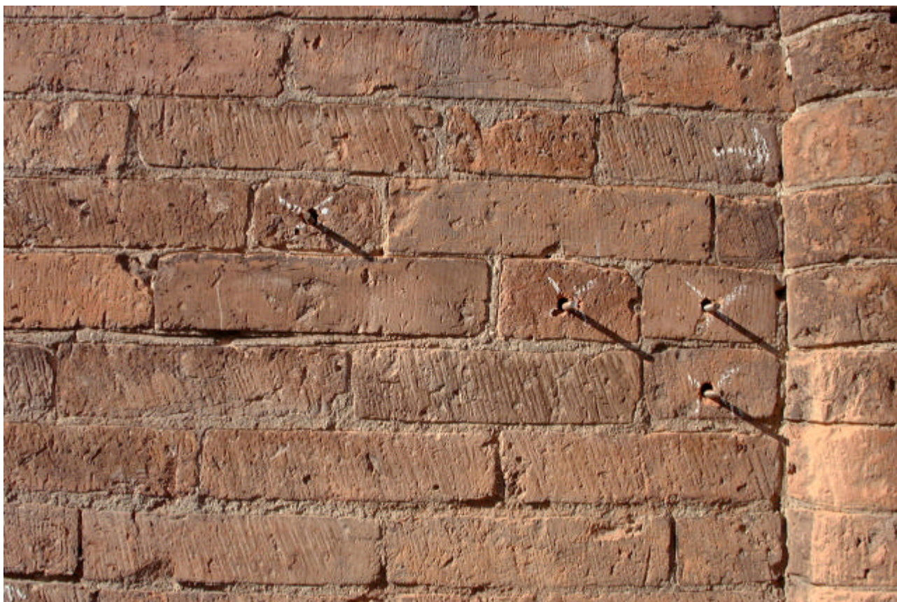
Fig. 7 • Cortina in mattoni con i perni inseriti nei fori prima dell'iniezione del formulato adesivo. (RONCAI)
