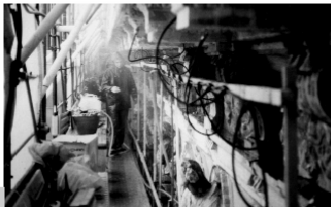
Figura 2 • Impianto di nebulizzazione per la pulitura del cortile della Ca' Granda di Milano (per concessione della restauratrice G. Andreoni).
