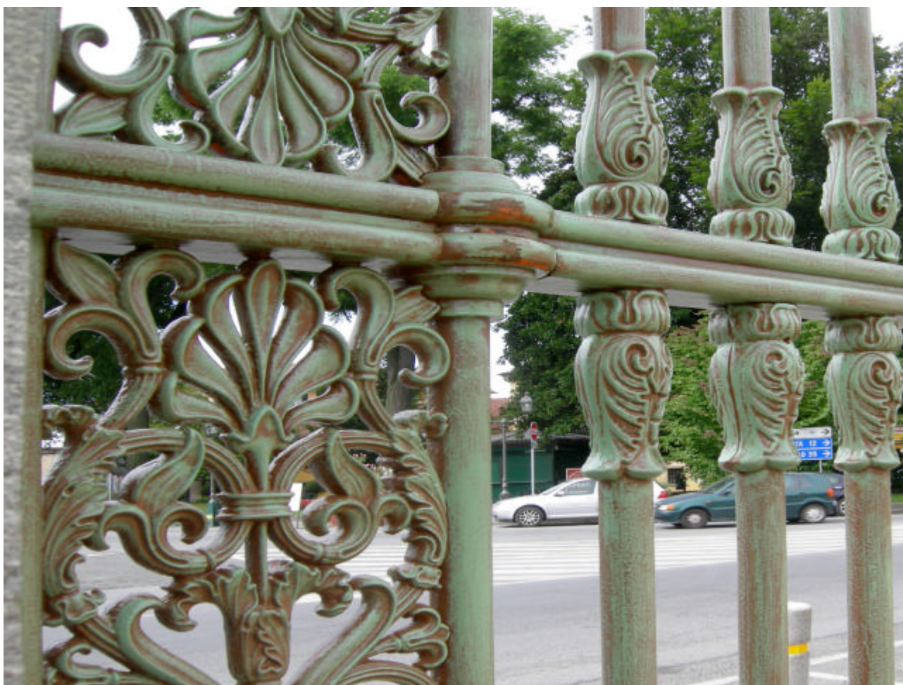
Figura 7 • Castello di Racconigi. Cancellata monumentale: porzione di campata con velatura verde su fondo marrone/bronzo. (BERRONE - BERTOLOTTI)
