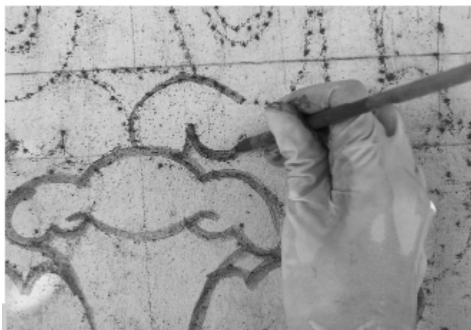
Figura 3 • Esecuzione del disegno della decorazione da riprodurre con la tecnica dello spolvero.
