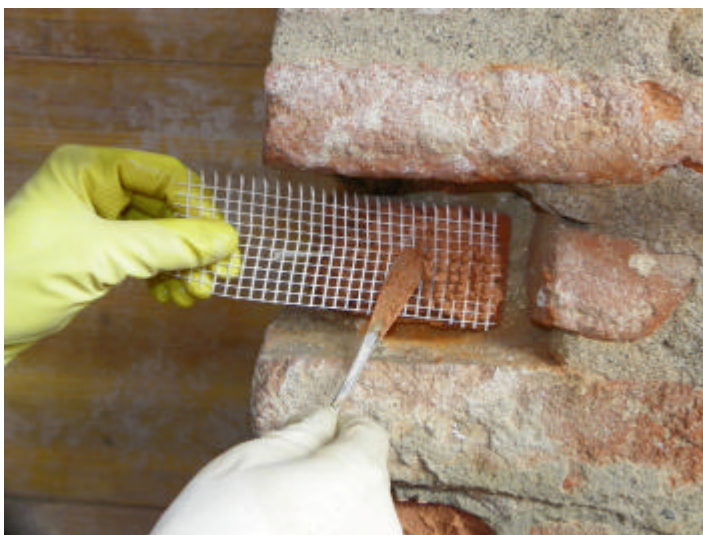
Figura 6 • Applicazione di retina in materiale plastico.
