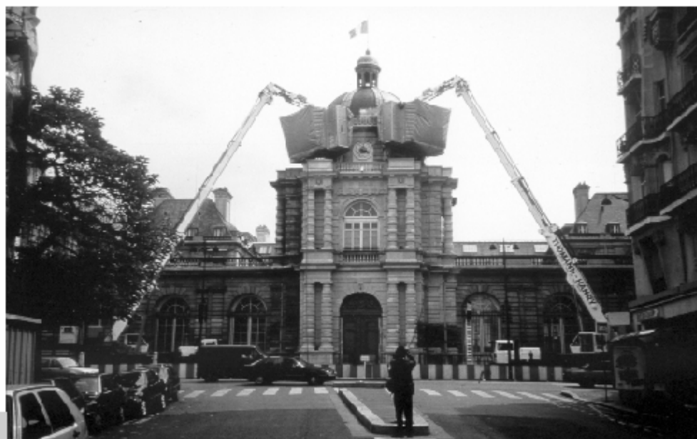
Figura 6 • Azione congiunta di due impianti durante la pulitura di una cupola. (VAC)
