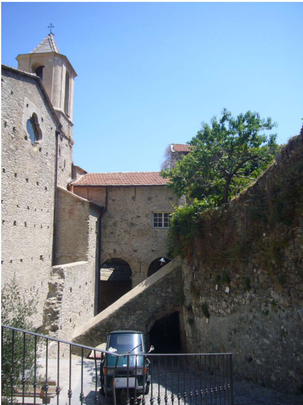
Figura 6 • Centro storico di Taggia (IM): sperone murario a sostegno della cinta muraria medievale. (BUC)
