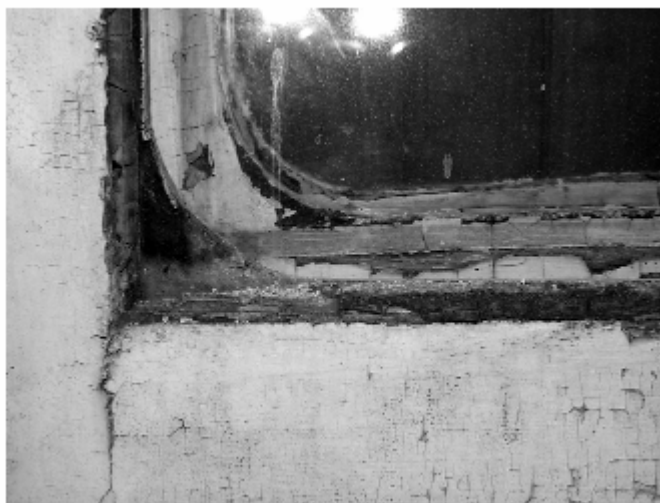
Figura 5 • Vecchio stucco fermavetri su un angolo a smusso tondo.
