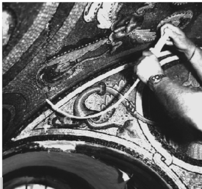
Figura 2 • Mosaico parietale: consolidamento del distacco della malta di allettamento dalla struttura muraria, mediante l'inserimento di malta a espansione o "lievitante", sino al raggiungimento della saturazione dei vuoti. (OPD)
