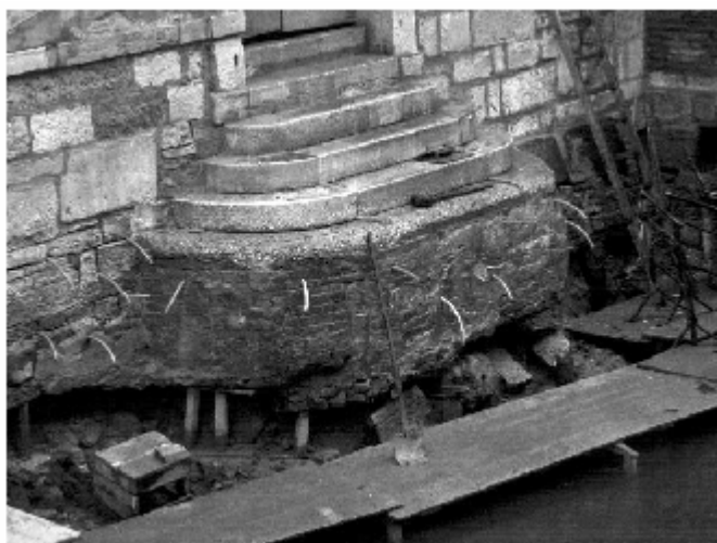
Figura 3 • Consolidamento delle fondazioni di un edificio veneziano. Dopo aver prosciugato il canale, si è proceduto al consolidamento tramite iniezioni. Si noti la presenza dei "tubicini testimone".
