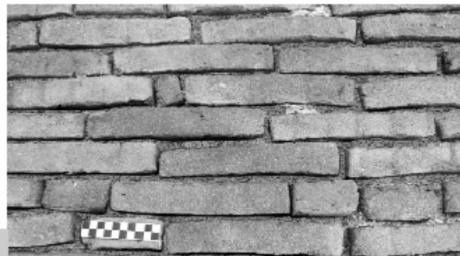
Figura 1 • Risarcitura dei giunti eseguita sottofilo.
