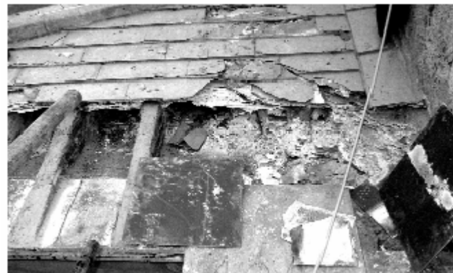
Figura 3 • Sostituzione graduale delle lastre d'angolo.
