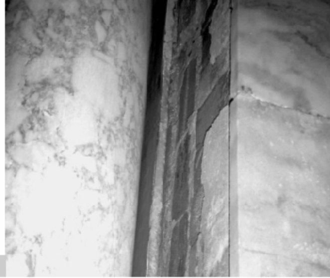
Figura 1 • Lo smontaggio delle lastre marmoree di rivestimento scopre il sottostante paramento in mattoni. Si noti come le lastre del fianco siano montate a filo del paramento murario, in modo tale che lo spessore del rivestimento sia nascosto da quelle poste sulla veduta frontale.
