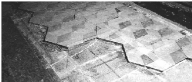
Figura 4 • Smontaggio del rivestimento marmoreo di un pavimento. Stacco delle tarsie per blocchi esagonali formati da dodici elementi ciascuno; ogni blocco è stato trasportato nell'attiguo cantiere di restauro e ripulito con bisturi e solventi dalla resina ancorata sulla faccia inferiore. (SAV)
