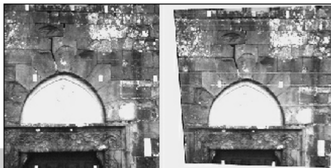
Figura 3 • Pieve di S. Lorenzo, Minucciano (Lucca). A sinistra, fotogramma di presa, contenente le deformazioni prospettiche; a destra, lo stesso fotogramma dopo il raddrizzamento.
