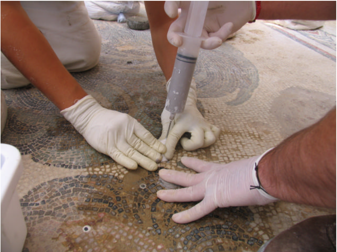
Figura 1 • Mosaico pavimentale: consolidamento della sconnessione del manto tassellare mediante l'iniezione di malta ad espansione o "lievitante". (L. PELLEGRINO)
