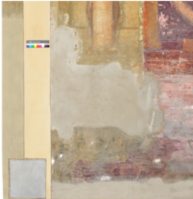
Figura 1b • Simulazione della integrazione della lacuna effettuata utilizzando il campione di intonaco fotografato contestualmente. (MOGGIA)
