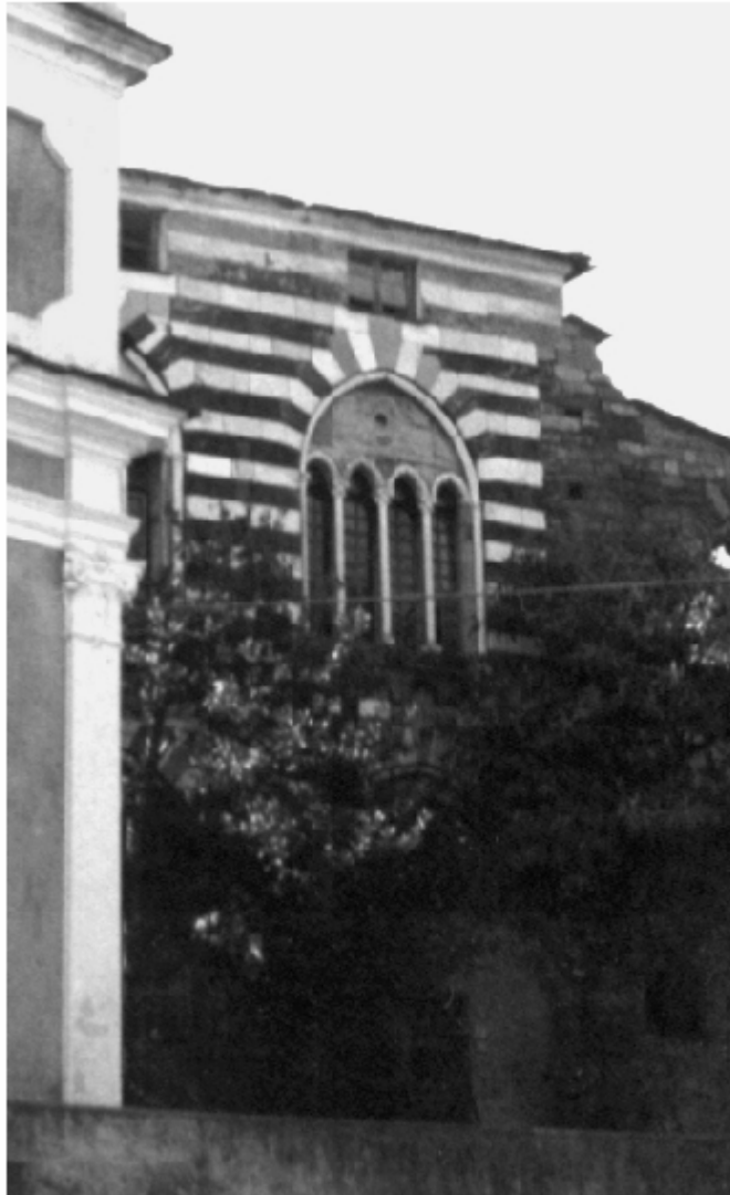
Figura 3 • Un altro prospetto dell'edificio della fig. 2 dopo la demolizione delle tamponature occludenti le finestre. Si noti come gli interventi di finitura abbiano radicalmente cambiato e "rinnovato" l'aspetto della vecchia costruzione.
