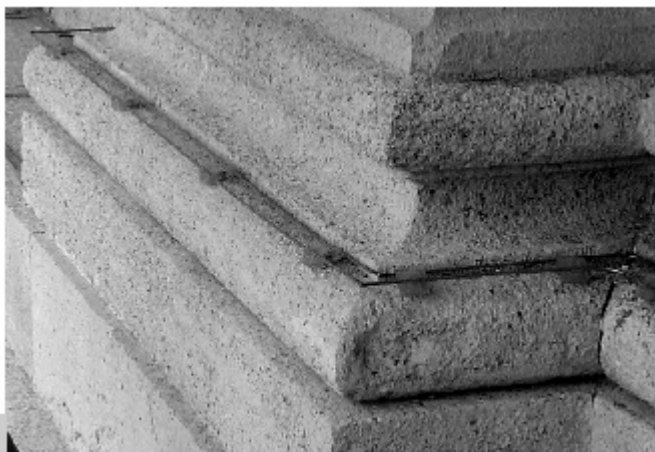
Figura 2 • Protezione della base di una parasta con sistema elettrostatico.
