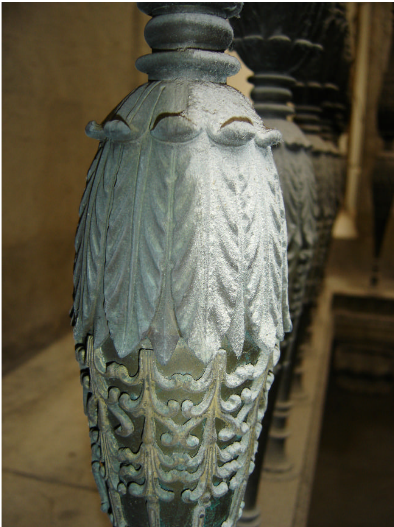
Figura 1 • Palazzo Nobile di Villa Torlonia (Roma). Particolare di un balastrino con evidente accumulo di particellato. (DEMMELEBAUER)
