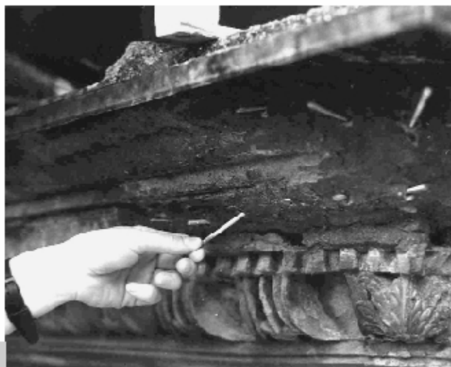
Figura 4 • Integrazione di modellato mancante con impasto a base di resine acriliche: fase di imperniatura con inserimento di una barretta inox nel foro. (OPD)
