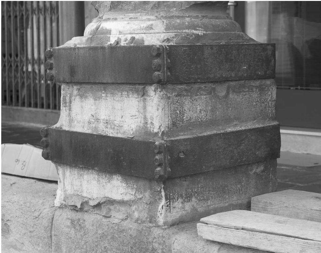
Figura 6 • Pesanti cerchiature al piedistallo di una colonna.
