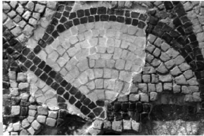
Figura 7 • Integrazione di lacune nella superficie musiva: con malta liscia e dipinta a effetto mosaico. (SRM)
