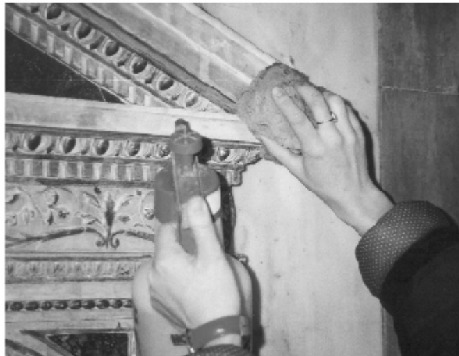
Figura 3 • Uso combinato di spruzzatore e spugna. (OPD)
