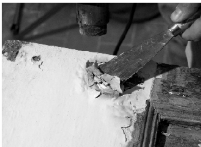
Figura 2 • L'azione della spatola permette il distacco degli strati di vernice da rimuovere.
