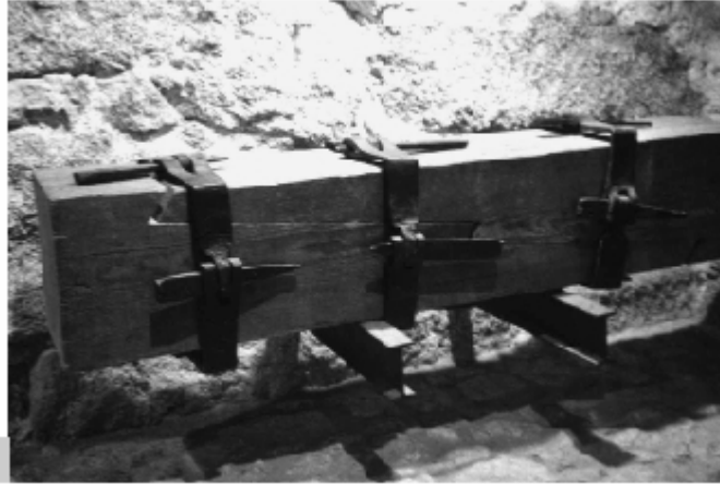
Figura 8 • Incalmo a dardo di Giove serrato da cerchiature e cunei metallici. (TAM)
