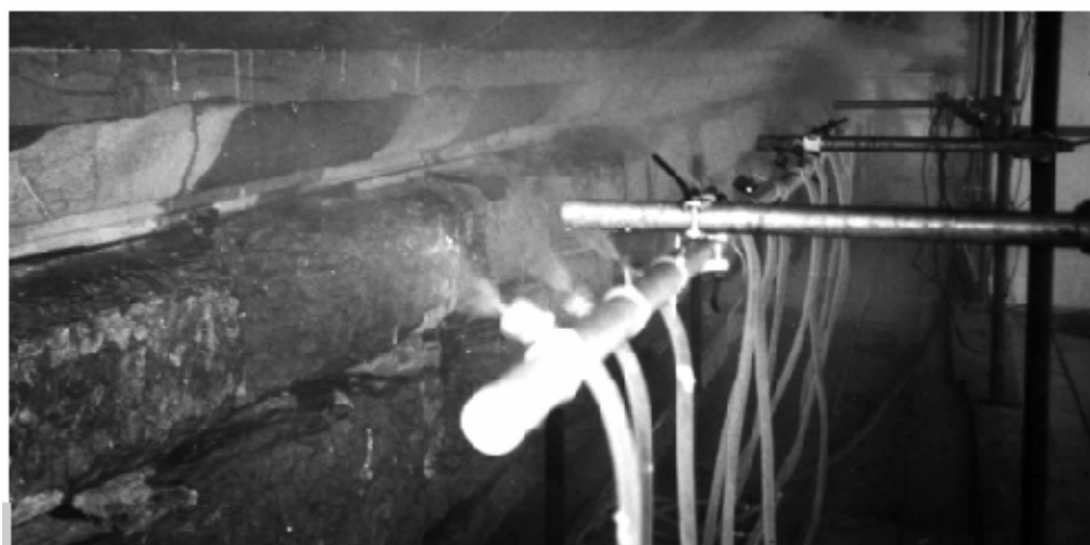
Figura 4 • Impianto di nebulizzazione. Si noti la disposizione degli ugelli in batteria per coprire omogeneamente l'intera superficie da pulire (per concessione della restauratrice G. Andreoni).
