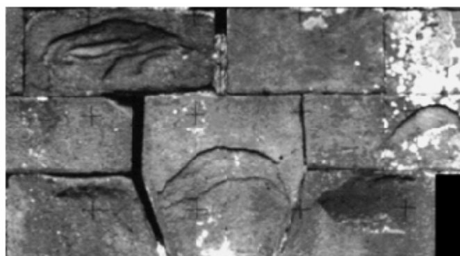
Figura 8 • Pieve di S. Lorenzo, Minucciano (Lucca). Applicazione di texture fotografica al DTM. Il risultato è un'immagine fotografica metrica e tridimensionale.
