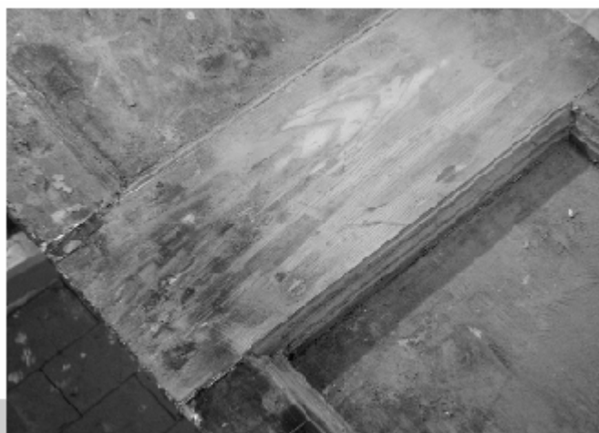
Figura 5 • Confronto tra due porzioni di superficie, prima e dopo la carteggiatura.
