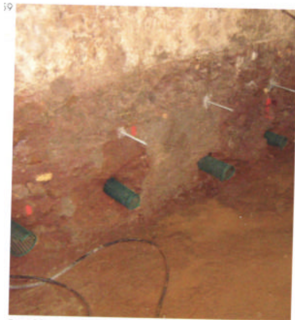
FIGURA 39 • Roma, Palazzo Gambirasi. Fori di ventilazione delle muratura con l'inserimento della rete forata antintasamento.
