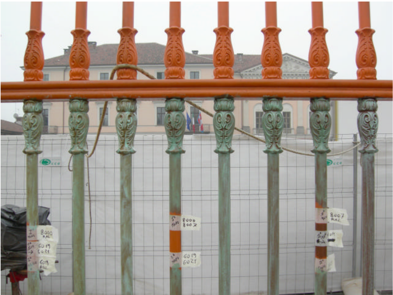
Figura 6 • Castello di Racconigi. Cancellata monumentale: parte superiore con una mano di minio su superficie sabbata, parte inferiore con campionature colore realizzate con velature verdi su due mani di fondo marrone/bronzo ad interpretare le indicazioni dei documenti di calcolo e misura redatti nel 1843 da Ernest Melano che riportavano la dicitura “coloritura verde bronzo” o “coloritura in due riprese tinta bronzo”. (BERRONE - BERTOLOTTI)
