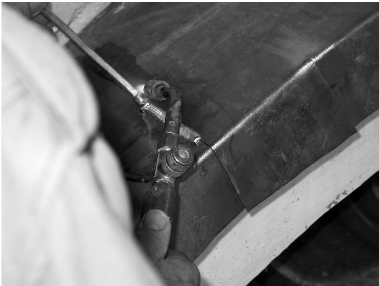
Figura 16 • Saldatura con cannello di stagno.
