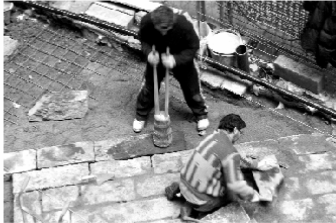
Figura 13 • Due momenti della lavorazione. Assestamento del blocco con il mazzapicchio e preparazione con la mazzetta di un altro blocco.
