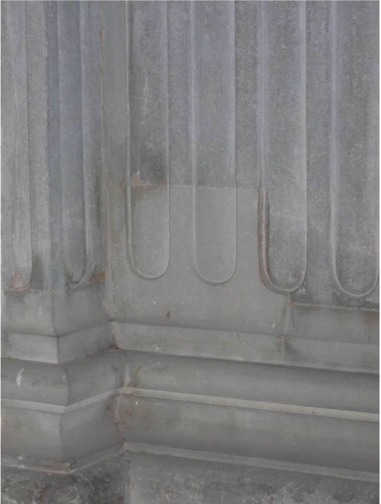
Figura 8 • Tasselli realizzati con stesse forme e materiale delle parti da sostituire. Firenze, Cappella Pazzi, base di parasta.
