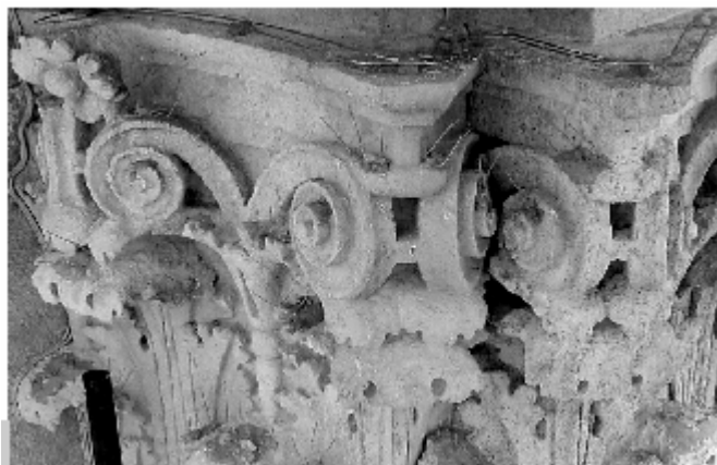
Figura 8 • Allontanamento di volatili con sistemi misti: mentre sulle volute sono stati applicati dei dissuasori ad aghi, sull'abaco del capitello si può vedere la linea del sistema elettrostatico. (CAF)
