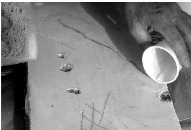
Figura 2 • La superficie deve essere accuratamente pulita e successivamente bagnata. (ZAM)
