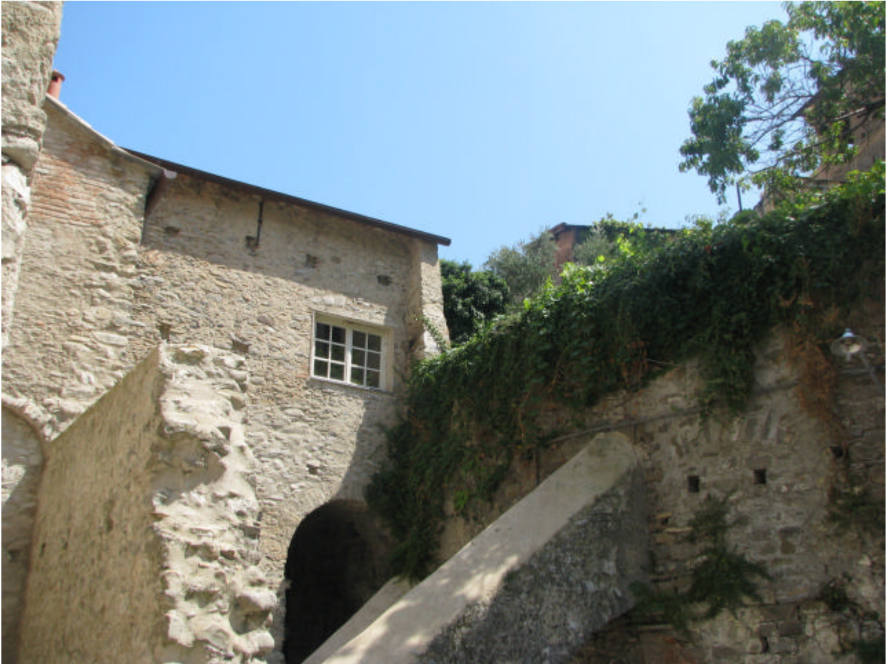
Figura 7 • Centro storico di Taggia (IM): particolare dello sperone murario a sostegno della cinta muraria medievale. (BUC)
