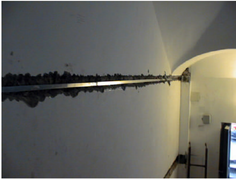
Figura 11 • Roma, villino in via Tito Livio, esempio di applicazione del CAM per catene; Roberto Marnetto, 2000.
