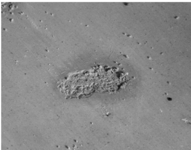
Figura 6 • Cavità risarcita e in attesa della finitura. (ZAM)
