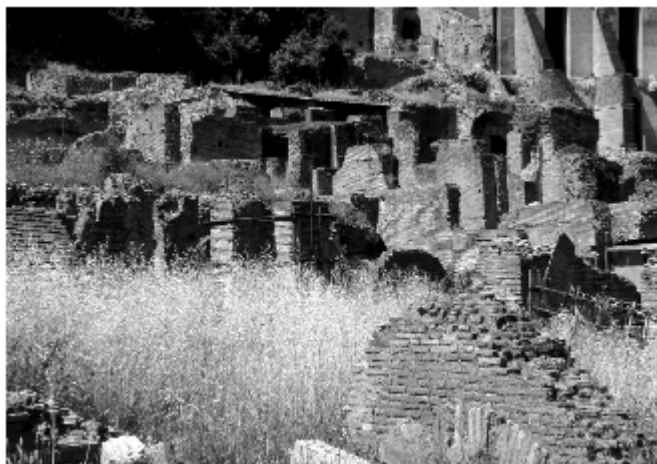
Figura 2 • Protezione della cresta di un muro in mattoni con mattoni simili ma arretrati rispetto al filo parete. In questo caso, il tipo di materiale scelto e il sistema di posa in opera rendono l'intervento di protezione meno evidente.
