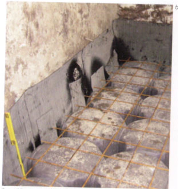
FIGURA 60 • Roma, Palazzo Gambirasi. Messa in opera dei casseri in polipropilene per la realizzazione della camera d'aria ventilata a pavimento.
