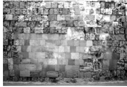
Figura 5 • Parete sulla quale è stata applicata la tecnica del cuci-scuci.
