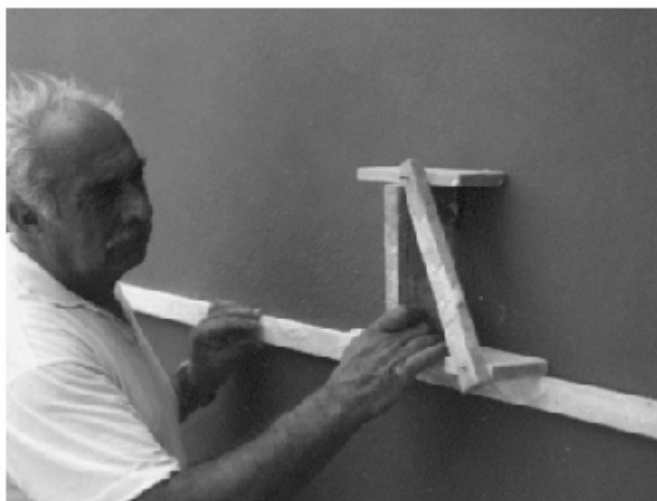
Figura 9 • Sagoma utilizzata per integrazione di stucchi in opera.
