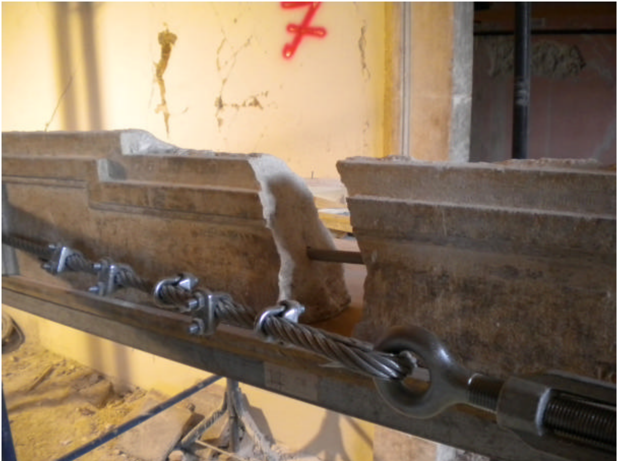
Figura 7 • Ripa di Fagnano (Fagnano Alto, L'Aquila), palazzo Rosati, rinforzo di un architrave lapideo con un'anima realizzata con una barra di diametro 16 mm; Ottobre 2011.
