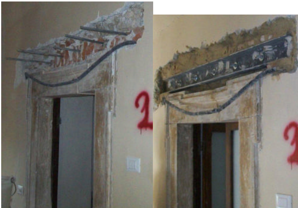
Figura 6 • Ripa di Fagnano (Fagnano Alto, L'Aquila), palazzo Rosati, fasi di intervento nel rinforzo di un architrave lapideo con una coppia di profilati metallici: a) alloggiamento di barre di collegamento fra i 2UPN140; b) disposizione del profilato metallico e serraggio delle barre; Ottobre 2011.
