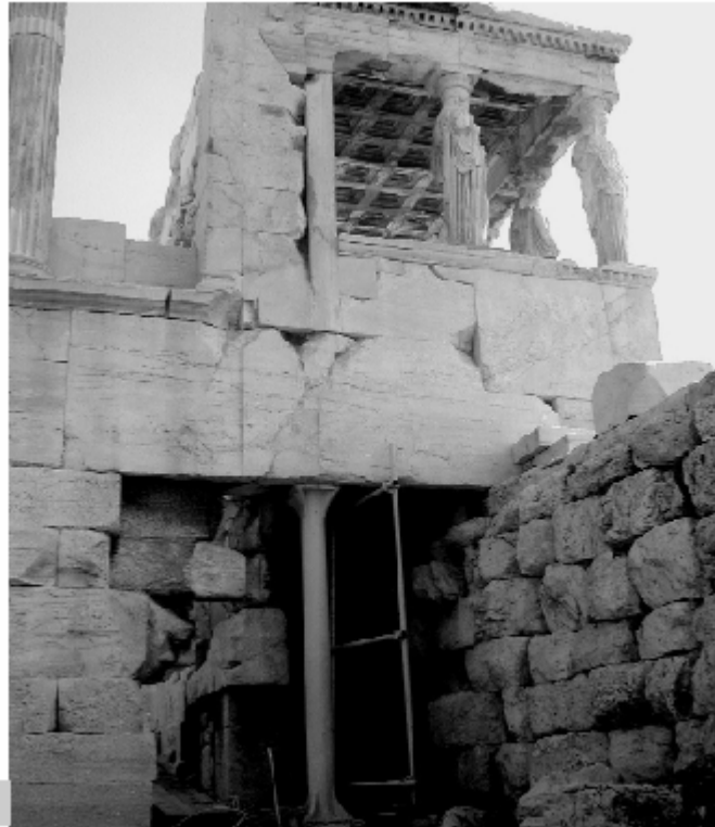
Figura 1 • Puntellatura verticale di sostegno a contrasto di dissesti che si esplicano attraverso moti di traslazione verticale (rottura di architrave) nell'Eretteo di Atene.
