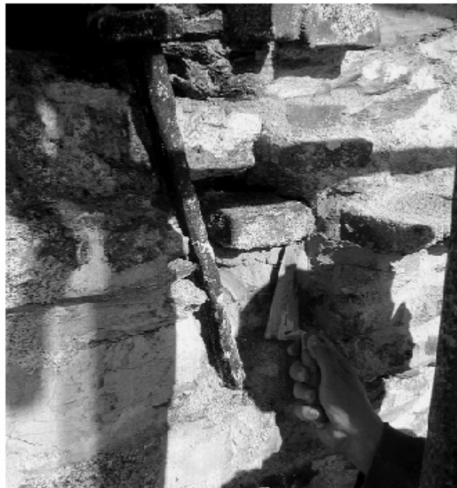
Figura 6 • Inserimento del primo mattone.
