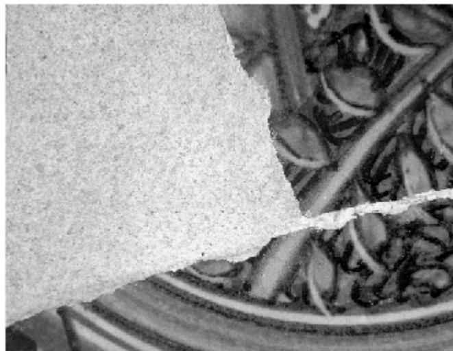
Figura 7 • Integrazioni con una miscela a base di gesso e trattamento della superficie mediante tecnica analoga all'astrazione cromatica. (OPD) v. Tavv.
