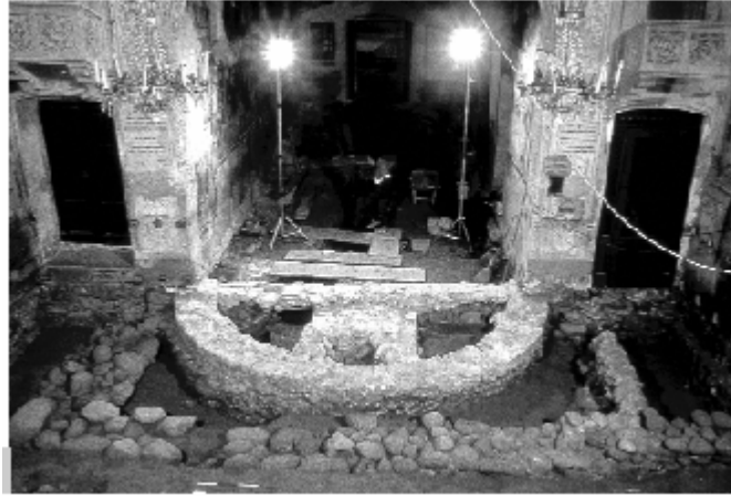
Figura 1 • Un cantiere di restauro di un edificio con gravi problemi di umidità. (VAC)
