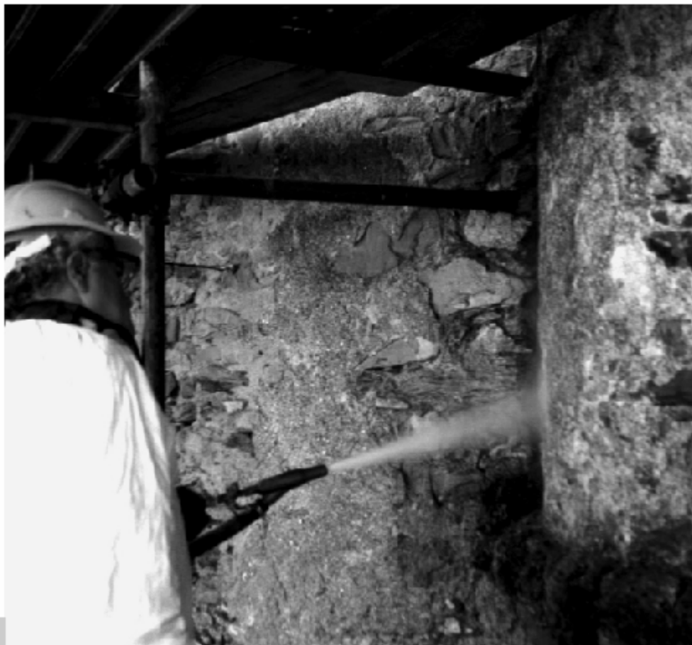
Figura 2 • Addetto alle operazioni di idropulitura. Prima di dare avvio all'intervento si deve provvedere alla stuccatura di tutte le connessure e le fessure presenti in superficie, onde impedire la penetrazione dell'acqua in profondità ed un dannoso aumento dell'umidità della struttura muraria.
