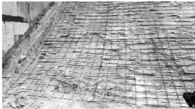
Figura 5 • Rete metallica per mettere provvisoriamente in sicurezza il manto di abbadini dalle sollecitazioni del passaggio di operai e materiali.
