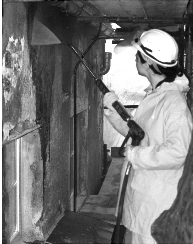
Figura 11 • Operatore durante il consolidamento.
