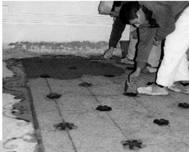
Figura 10 • Rifacimento di un tratto pavimentale ammalorato. (VIG)
