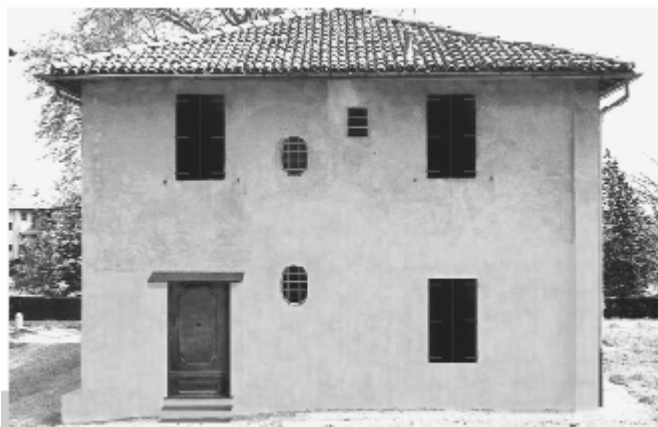
Figura 3 • Velatura del nuovo intonaco e dei vari rappezzi con uno dei campioni di velatura realizzato nella fase precedente. (DEP)
