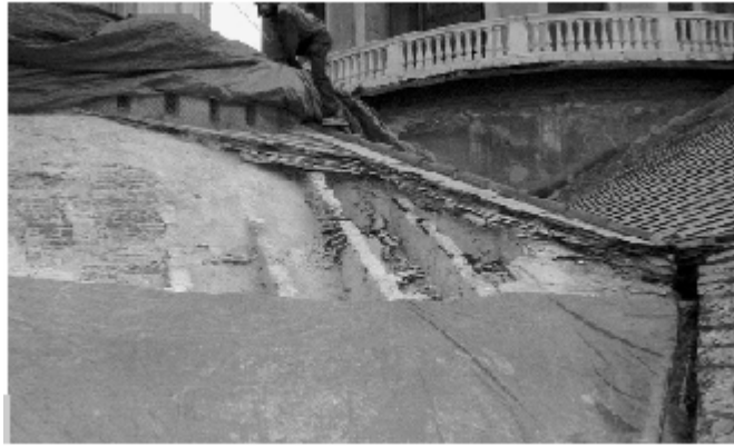
Figura 1 • Teleri di protezione su una cupola minore dell'Assunta di Carignano a Genova. Si notino i muricci in mattoni di supporto al rivestimento in abbadini d'ardesia e di mediazione tra la superficie curva dell'estradosso della cupola e la superficie piana del manto di rivestimento stesso.
