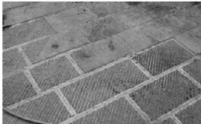
Figura 15 • Due tratti di pavimentazione a un diverso stadio di finitura.
