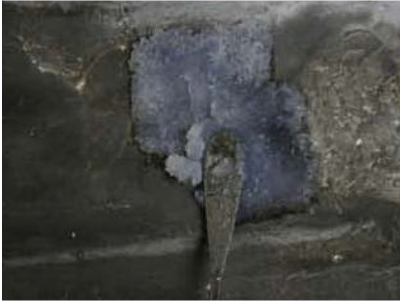
Fig. 3 Applicazione del gel destrutturato.
