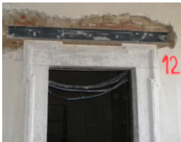
Figura 2 • Ripa di Fagnano (Fagnano Alto, L'Aquila), palazzo Rosati, rinforzo di un architrave lapideo, danneggiato dal sisma del 6 aprile 2009, con 2UPN140 posti in opera immediatamente al di sopra del vano; Alberto Viskovic e Pasqualino Carusi, 2011.
