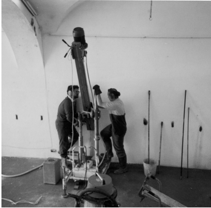
Figura 1 • Esecuzione dei fori di contenimento delle barre. La perforazione si esegue dall'alto verso il basso, con speciali carotatrici elettriche dotate di punta diamantata e progettate in modo da non indurre vibrazioni alla muratura.
