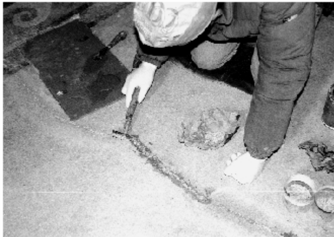
Figura 8 • Stuccatura e integrazione delle fratture con graniglia dello stesso colore e granulometria del seminato. (VIG)
