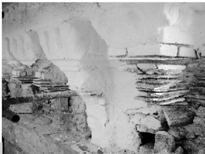
Figura 3 • La superficie ricoperta dall'impasto desalinizzante.
