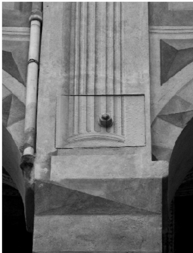
Figura 8 • Bolzone mimetizzato con la decorazione della facciata.
