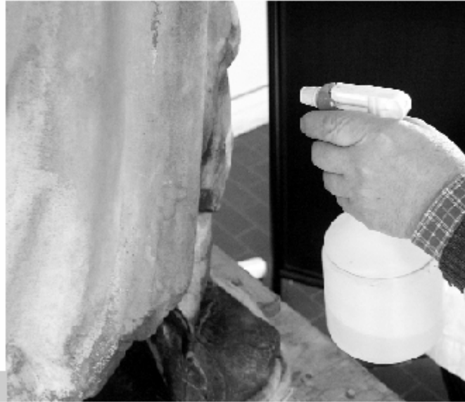
Figura 5 • La bagnatura della superficie si esegue di solito con nebulizzatori di diversa capacità a seconda della superficie trattata e della velocità del trattamento. (OPD)
