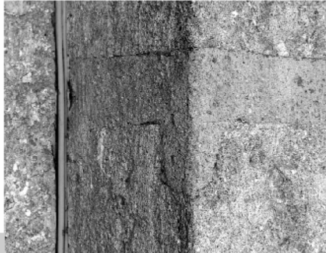
Figura 5 • Rappezzo di un tratto angolare su una facciata intonacata.
