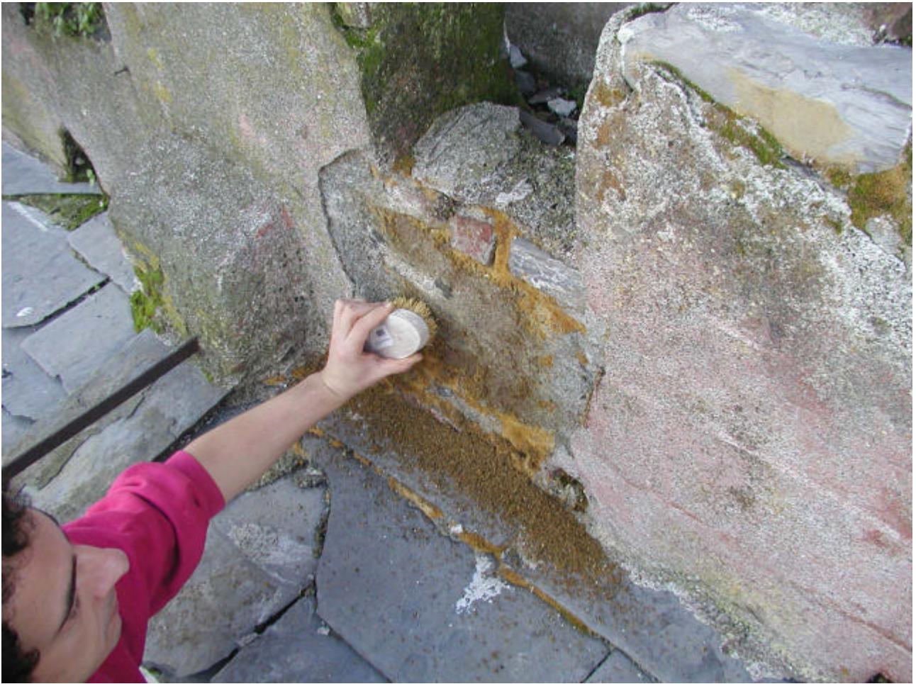
Figura 5 • Eliminazione della patina biologica secca, mediante spazzolatura.
