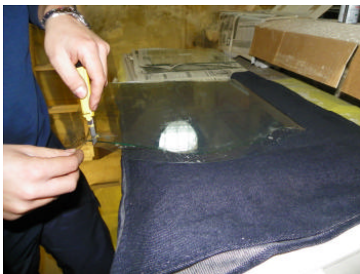
Figura 14 • Applicazione di pellicole di sicurezza
