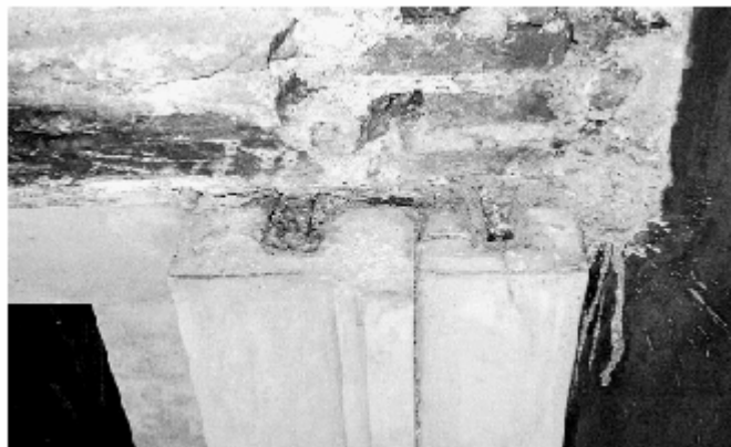
Figura 7 • Sostituzione degli elementi di connessione di una cornice di marmo: elemento di connessione di un montante della cornice.
