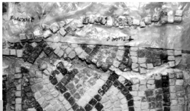
Figura 15 • Ricollocazione delle tessere di unione (rimosse prima del distacco), con nuova malta di allettamento. (SRM)
