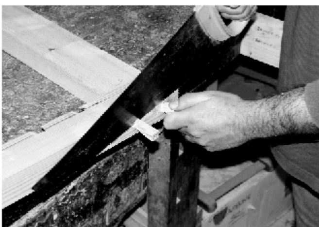
Figura 12 • Taglio delle zeppe di forzatura degli incastri.
