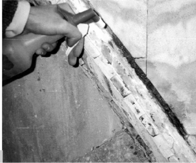
Figura 8 • Prima mano di stucco. (OPD)
