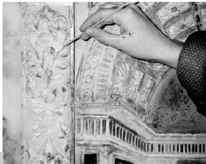
Figura 1 • Pulitura a tamponcino: il tamponone può essere costituito da un semplice batuffolo di cotone o da una compressa di garza contenente al suo interno materiale assorbente. L'operatore può impiegare il tamponone impugnandolo direttamente con le dita oppure avvalendosi di un bastoncino di legno. (OPD)
