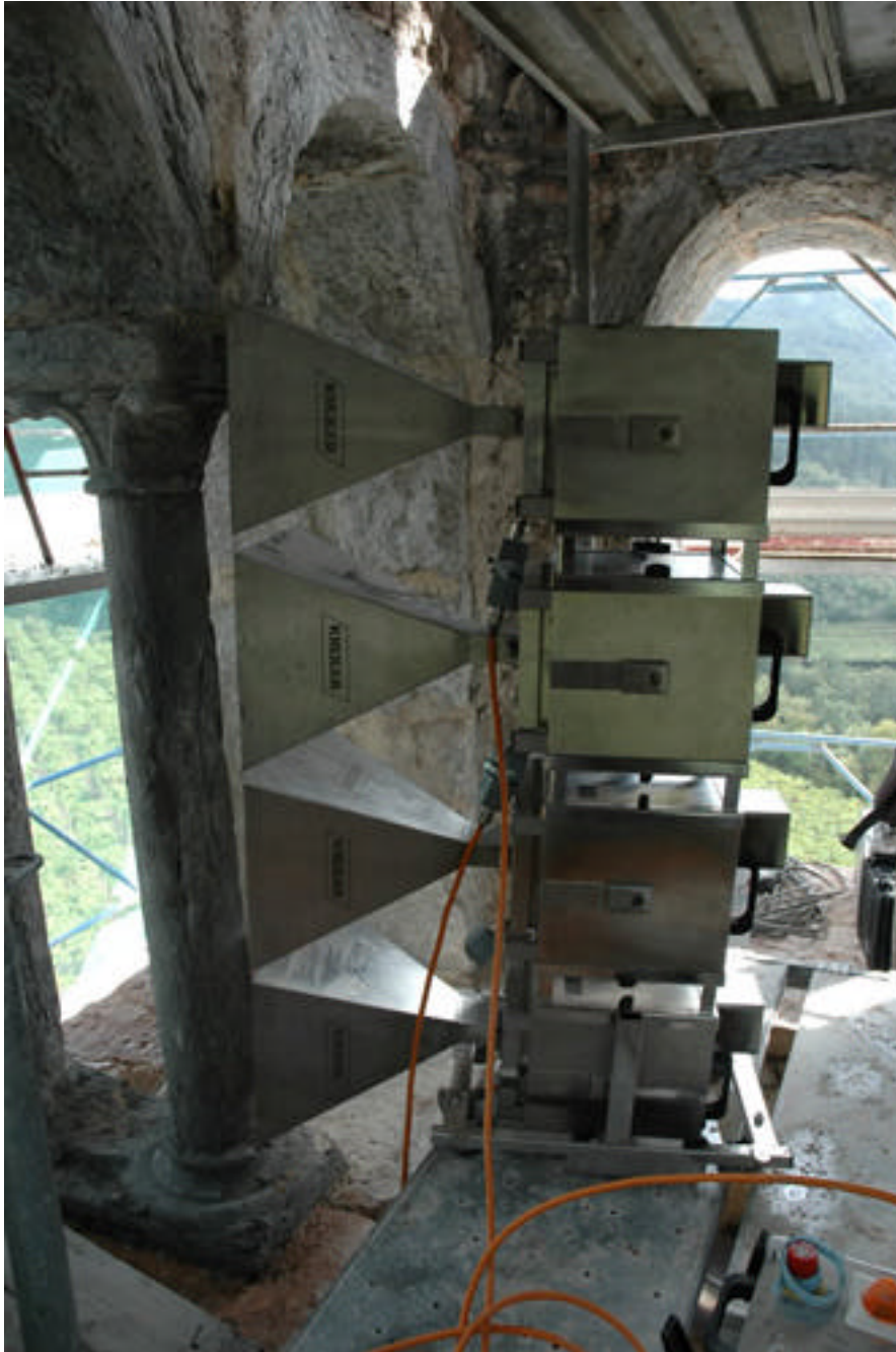
Figura 1 • Essiccazione di colonna in pietra con sistema monitorato di disidratazione a frequenza micro pulsate.
