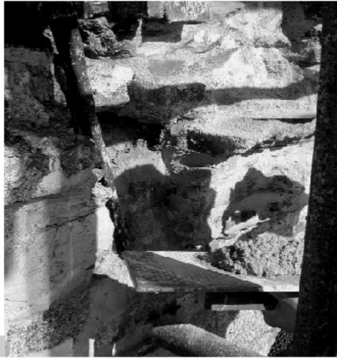
Figura 5 • Applicazione della malta di allettamento del primo mattone.
