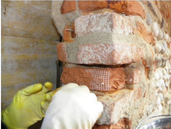
Figura 7 • Applicazione dei successivi strati di malta.
