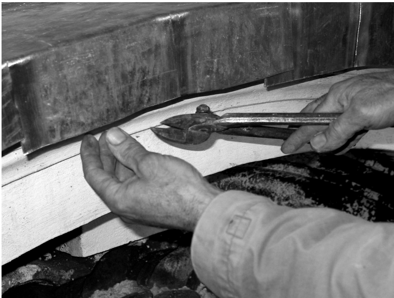
Figura 12 • Taglio con cesoie del materiale in eccesso.
