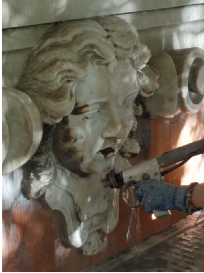
Figura 4 • Pulitura cornice finestra in marmo interessata da croste nere (Basilica di Carignano-Genova) con sistema Helix a umido.
