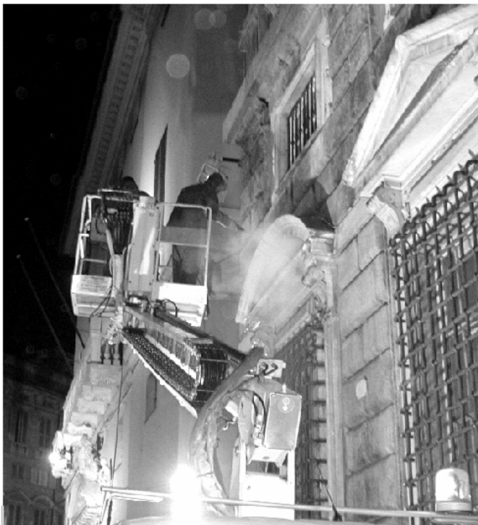
Figura 1 • Facciata edilizia in corso di pulitura mediante spray d'acqua.
