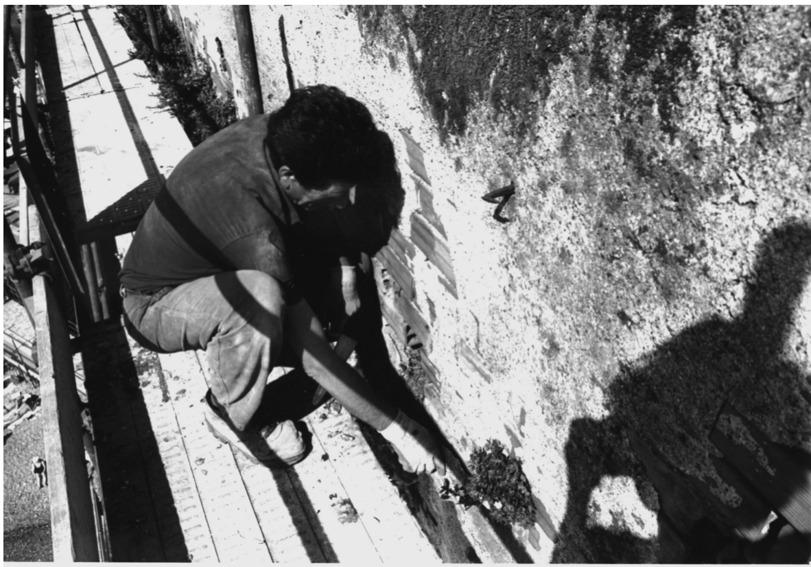
Figura 1 • Dopo l'applicazione di prodotto biocida l'operatore procede con l'estirpazione manuale della vegetazione infestante.
