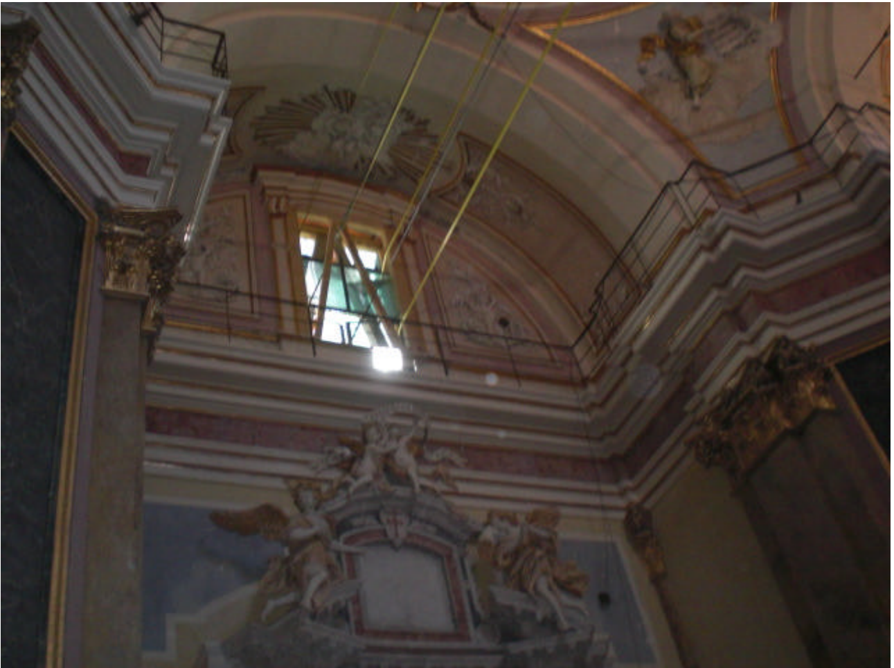
Figura 12 • L'Aquila, chiesa delle Anime Sante: particolare del sistema provvisorio di tiranti all'interno della navata. (BUC)
