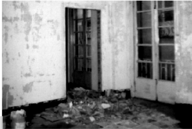
Figura 6 • Stato dei lavori in un cantiere durante la fase delle demolizioni.
