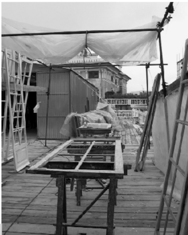
Figura 1 • Cantiere di restauro degli infissi allestito sulla terrazza di palazzo Rosso a Genova.
