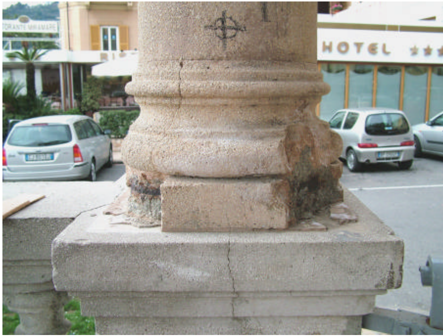
Figura 15 • Mancanze in un basamento in pietra artificiale.
