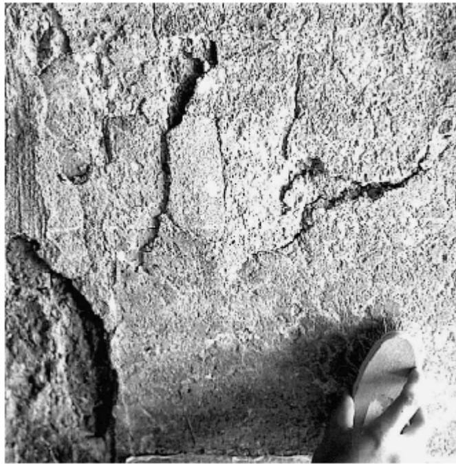
Figura 1 • Pulitura manuale mediante spazzolatura. (SAV)
