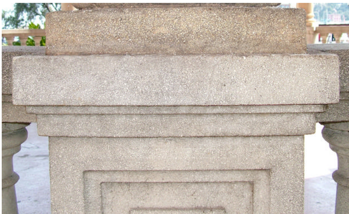
Figura 8 • Simulazione della pulitura dell'intero basamento elaborata schiarendo i valori cromatici in base al risultato ottenuto con la pulitura reale. (DEP)
