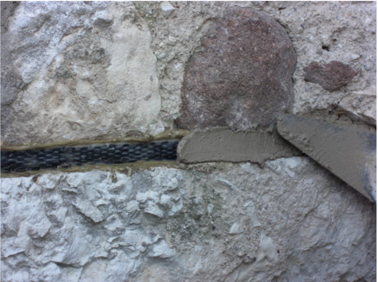
Figura 16e • Fasciatura inserita nei giunti di malta. Finitura dell'intervento con malta di calce idraulica naturale. (IAR)
