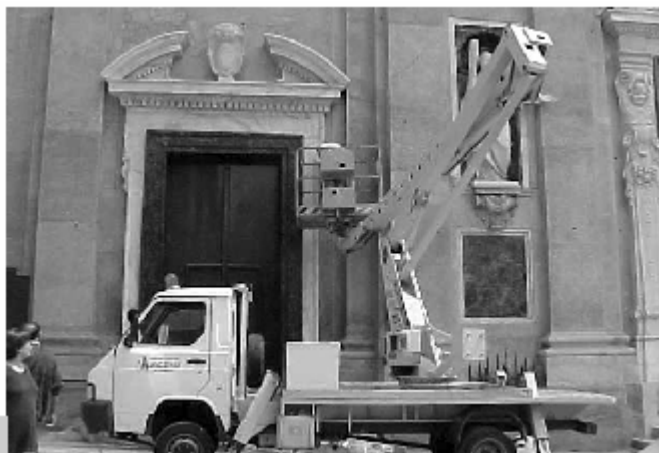
Figura 1 • Piattaforma elevatrice utilizzata per l'applicazione del prodotto protettivo antigraffiti. (SAL)
