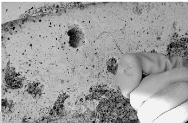
Figura 5 • Pulitura e creazione dei canali di penetrazione del consolidante.
