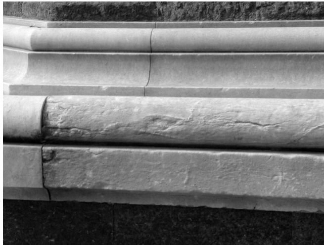
Figura 7 • Tassello realizzato con lo stesso materiale e con le stesse forme della cornice da sostituire.
