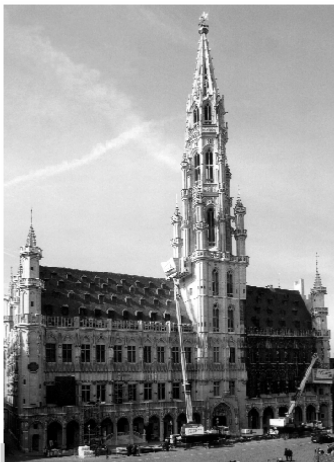
Figura 5 • La tecnica del gommage applicata alla pulitura di un edificio alto e con accentuati rilievi e aggetti. (VAC)
