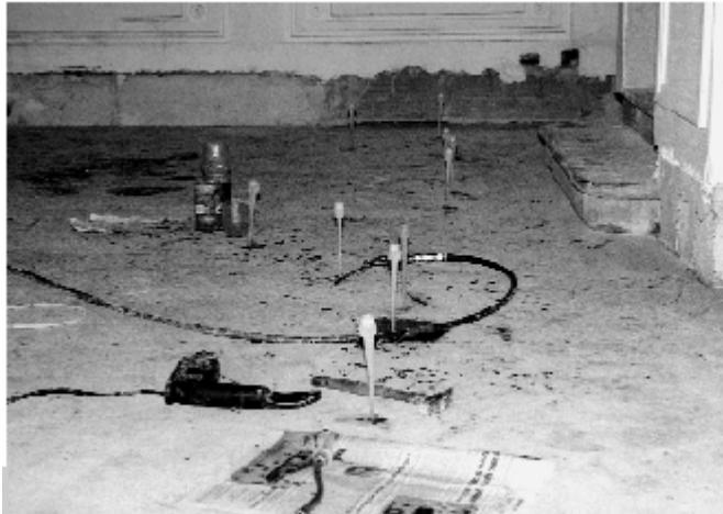
Figura 7 • Fase di consolidamento di un pavimento fessurato. Tramite dei diffusori si impregna di resina il sottofondo in corrispondenza delle lesioni. (VIG)
