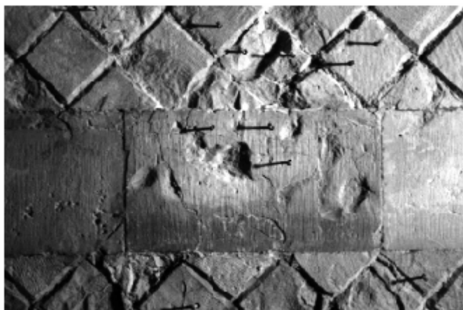
Figura 2 • Imperniatura di elementi lapidei di diversa dimensione. Esecuzione dei fori con le barre filettate prima dell'iniezione di resina.
