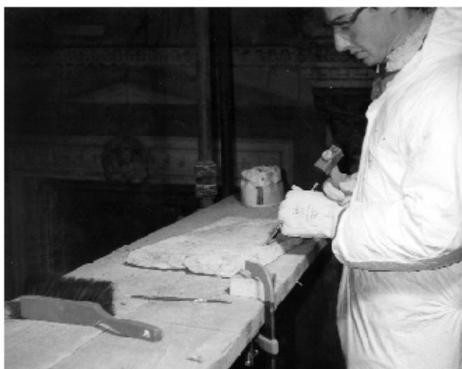
Figura 5 • Pulitura, in laboratorio, di una lastra di marmo. (OPD)
