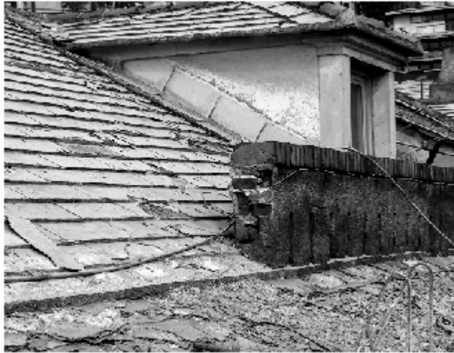
Figura 8 • Falda di tetto in ardesia in fase di rimozione degli abbadini rotti.
