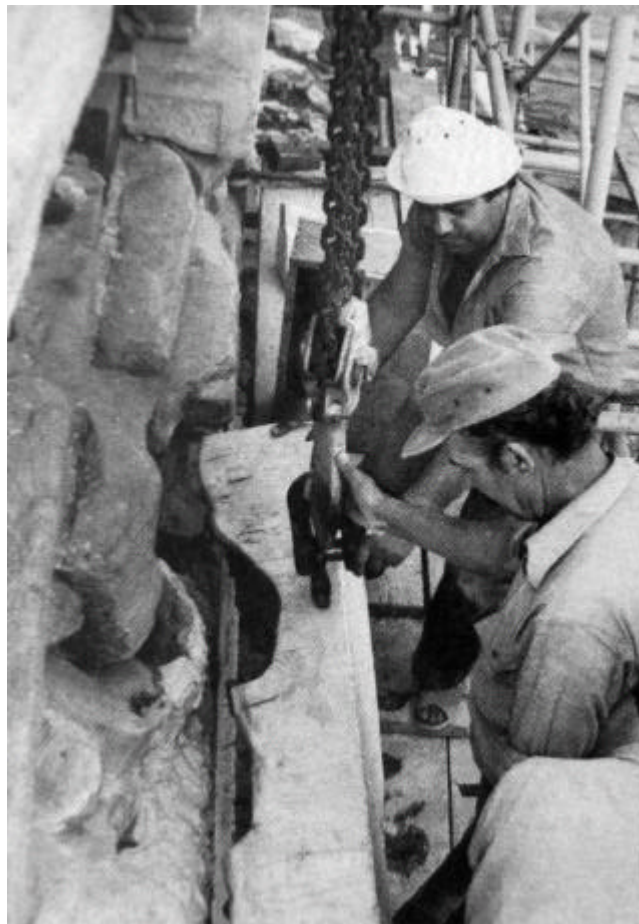
Fig. 15 • Fotografie di cantiere riprese durante le operazioni di restauro dell'Eretteo, 1979-1987.
