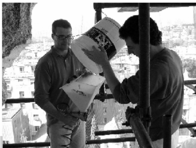
Figura 1 • Caricamento dello spruzzatore con miscela di polpa di cellulosa e acqua deionizzata.
