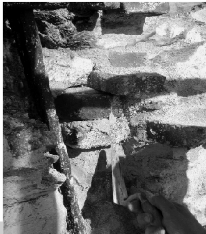
Figura 7 • Collocazione del secondo mattone.
