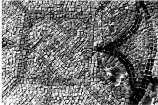
Figura 8 • Esercizio di integrazione con tessere di materiale lapideo in varie tonalità di bianco (particolare). (SRM)
