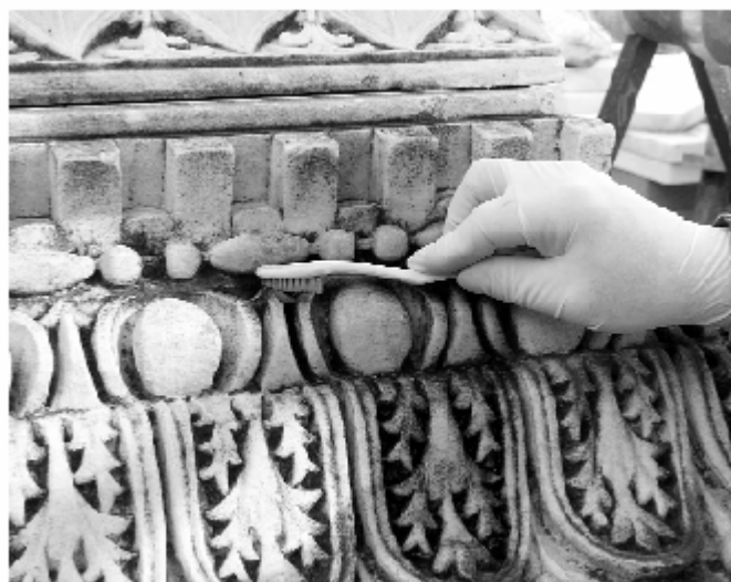
Figura 5 • Pulitura con uno spazzolino a setole sintetiche, dopo la nebulizzazione. (OPD)
