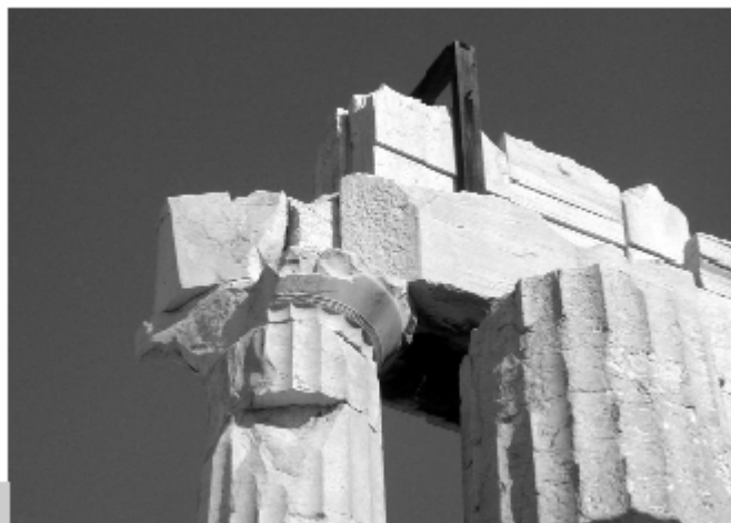
Figura 3 • Acropoli di Atene, dettaglio di una ricomposizione per anastilosi.
