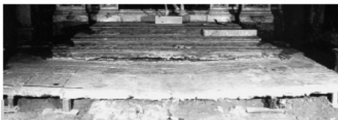
Figura 5 • Smontaggio del rivestimento marmoreo di un pavimento. Anche i sottostanti lastroni, che costituiscono lo "zatterone" in pietra sul quale è posato il pavimento a tarsie, sono stati rilevati, numerati e fotografati prima di procedere alla loro rimozione. (SAV)
