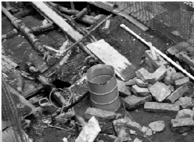
Figura 9 • Pavimentazione rimossa per consentire opere di manutenzione straordinaria degli impianti tecnici urbani.
