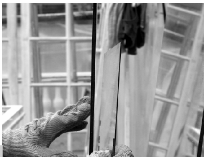
Figura 6 • Ricollocazione di una lastra di cristallo.
