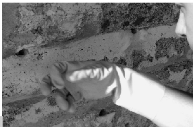
Figura 7 • Battitura tendente a facilitare la discesa del consolidante.
