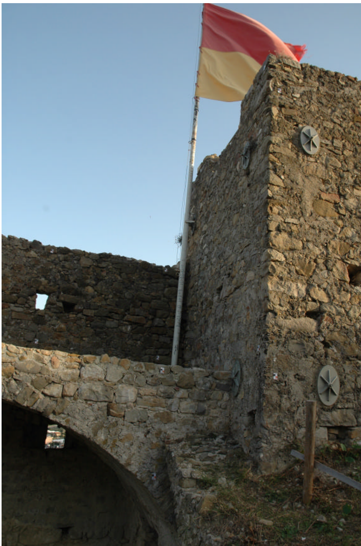
Figura 6 • Castello di Taggia (IM): particolare della cortina muraria perimetrale a nord-est; gli interventi di consolidamento hanno comportato l'inserimento di dieci tiranti, cinque per ogni livello, realizzati con cavi inox e golfari ancorati alla muratura. (BUC)
