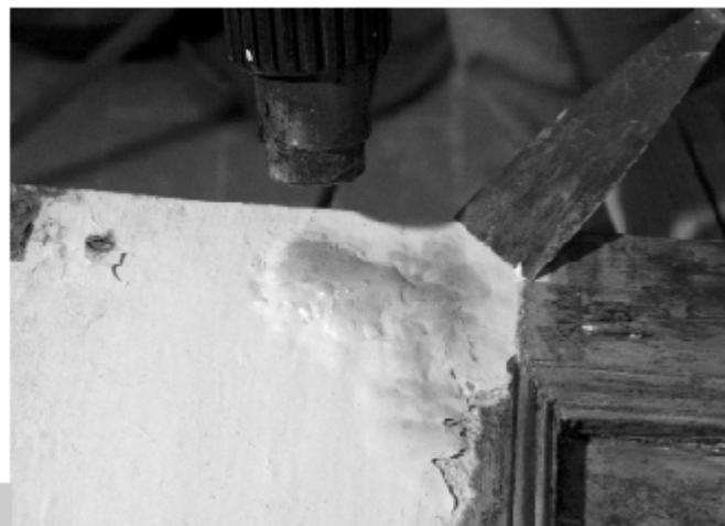
Figura 1 • Pistola termica in azione per la sverniciatura di un'anta di porta. Si notano le vesciche di rigonfiamento provocate dal calore.
