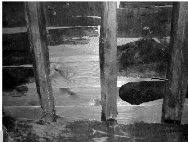
Figura 1 • Sovrapposizione del nuovo tavolato con mantenimento del vecchio.
