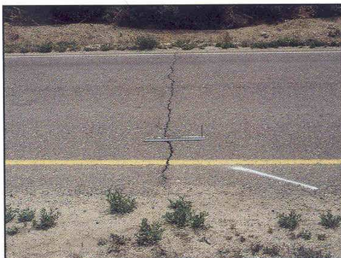
Figura 9.7 Fessurazione trasversale
