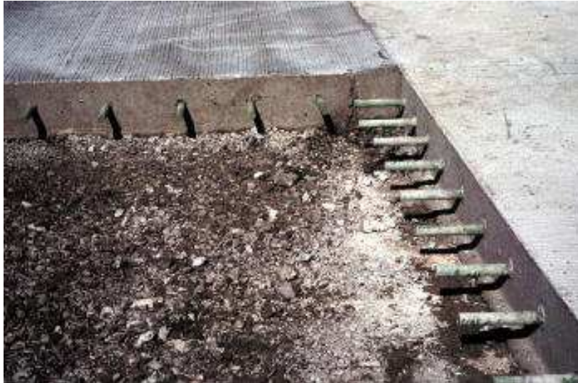
Figura 11.22 Giunti di contrazione dowel bars)
