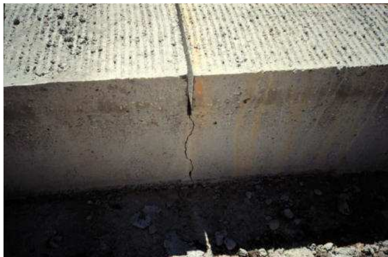
Figura 11.21 Giunti di contrazione (interlock)
