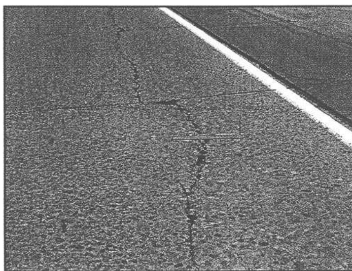
Figura 11.6 Fessurazioni longitudinali
