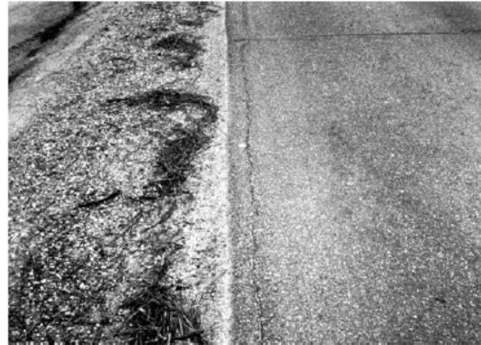
FIG. X1.19 Low-Severity Edge Cracking
