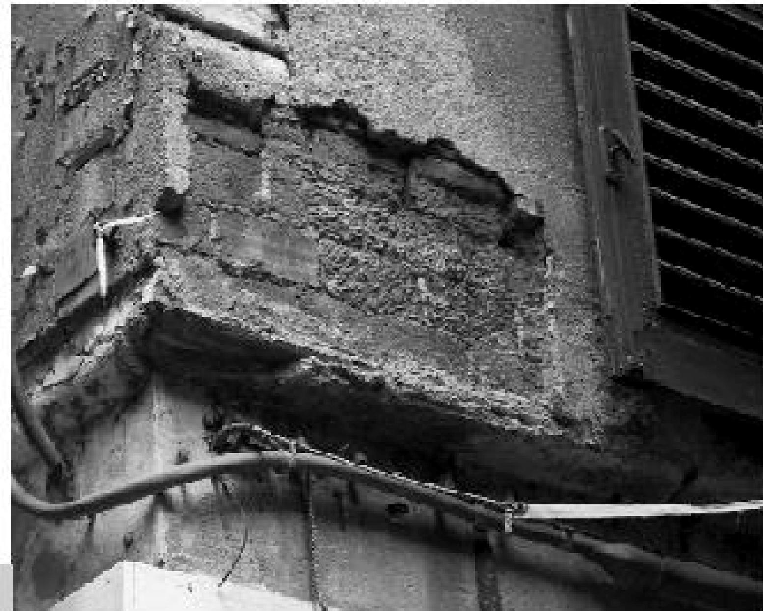
Figura 1 • Perdita di un tratto d'intonaco della facciata.
