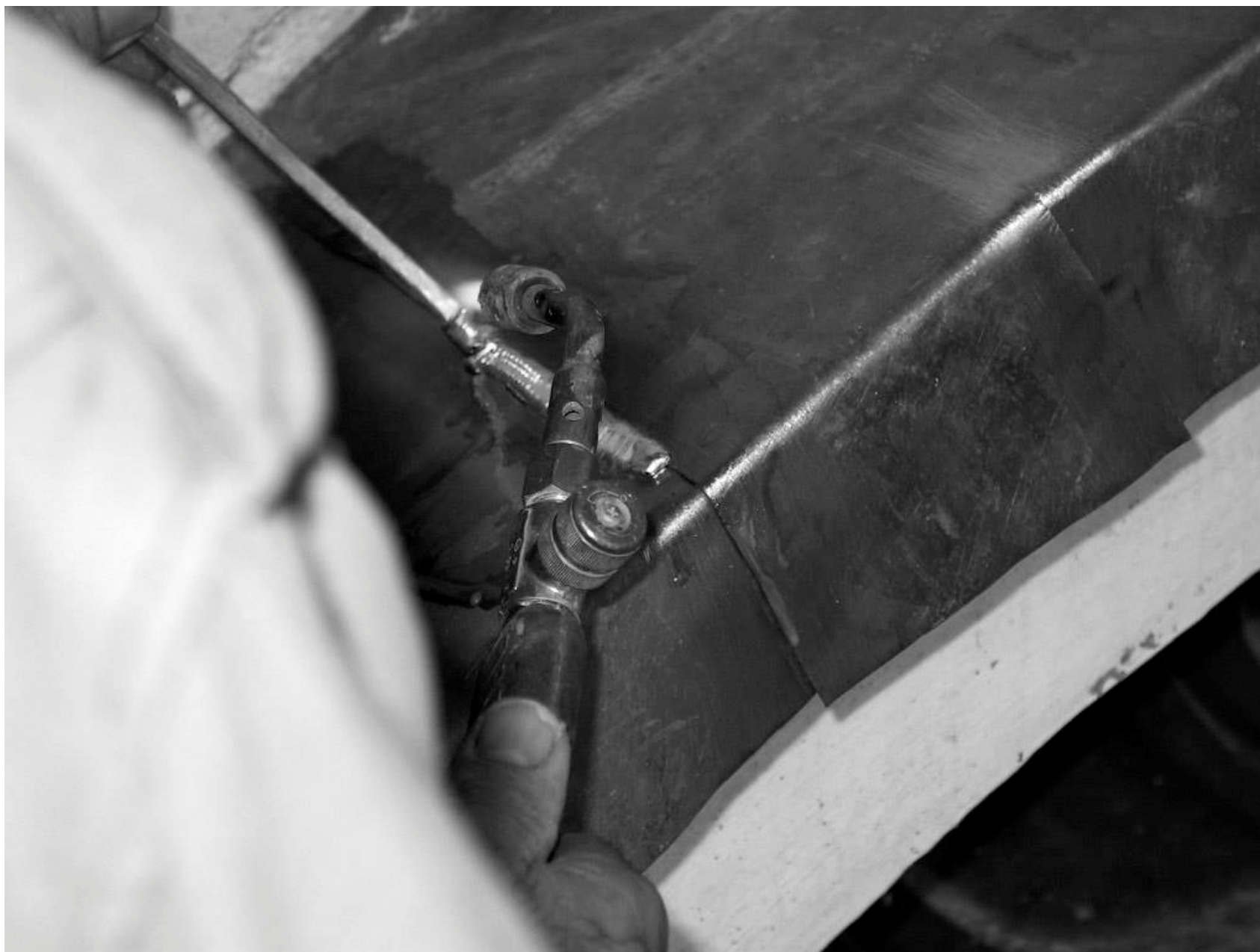
Figura 16 • Saldatura con cannello di stagno.
