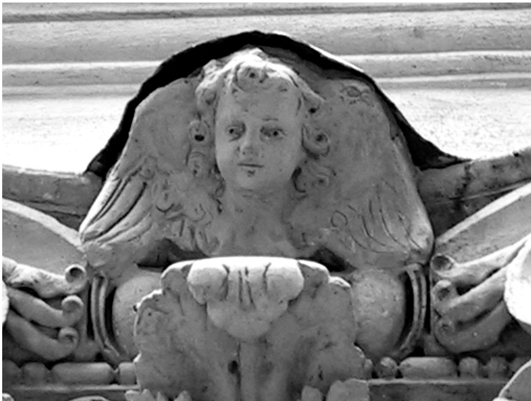
Figura 21 • Protezione di un elemento figurativo in stucco per mezzo di una copertina di piombo.
