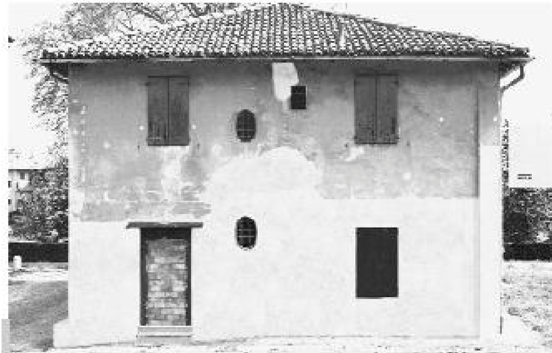
Figura 1 • Rappezzi di varia dimensione e nuova stesura di intonaco nella parte basamentale della facciata.
