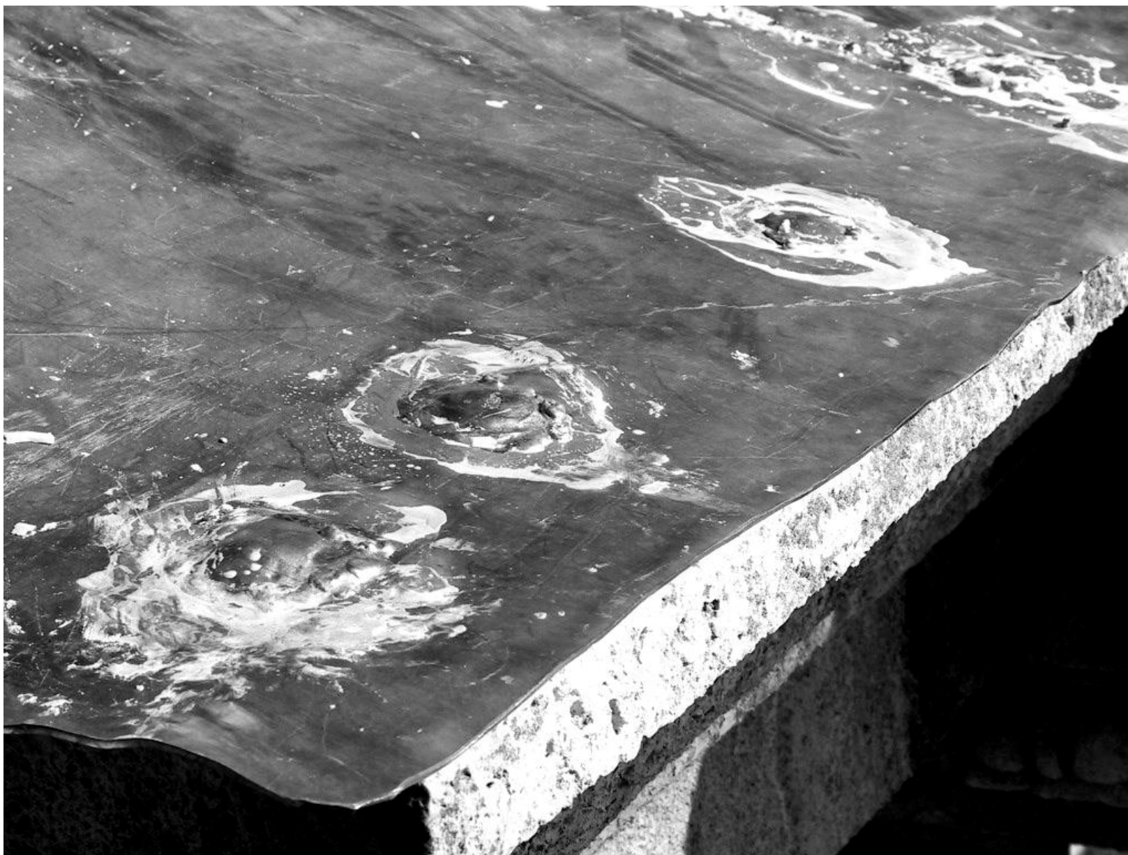
Figura 19 • Rivestimento delle teste delle viti a espansione e relative rondelle, con dischetti in lamina di piombo saldati, per evitare possibili infiltrazioni d'acqua.
