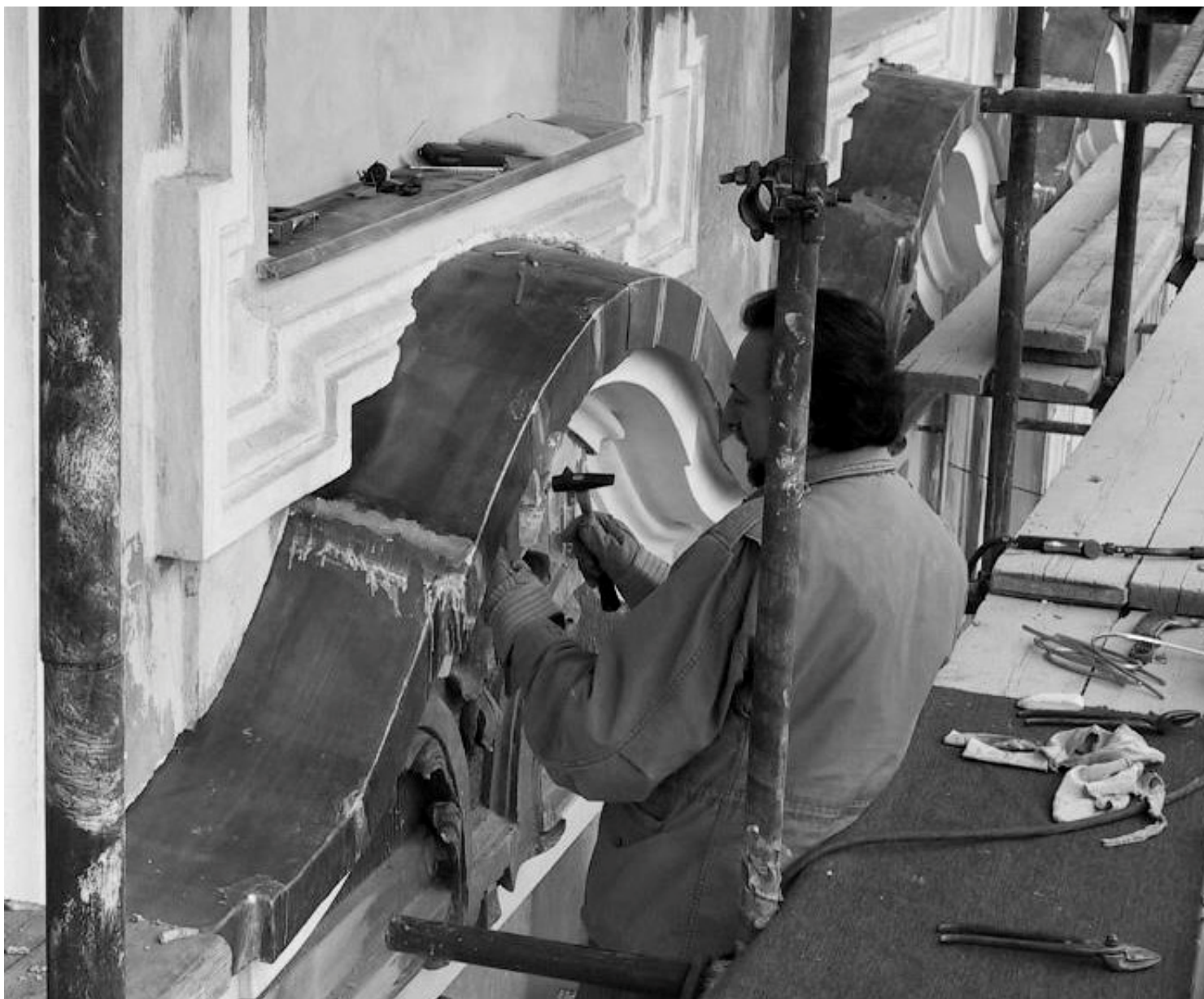
Figura 8 • Lattoniere durante la posa in opera di copertine in piombo a protezione dell'estradosso della cornice di un timpano polilineo.
