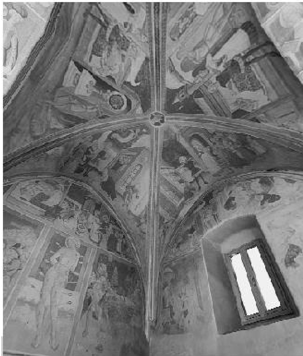
Figura 22 • S. Pietro di Feletto. Il modello arricchito con texture fotografica che riproduce le decorazioni murali seguendone l'andamento tridimensionale. (SAT)
