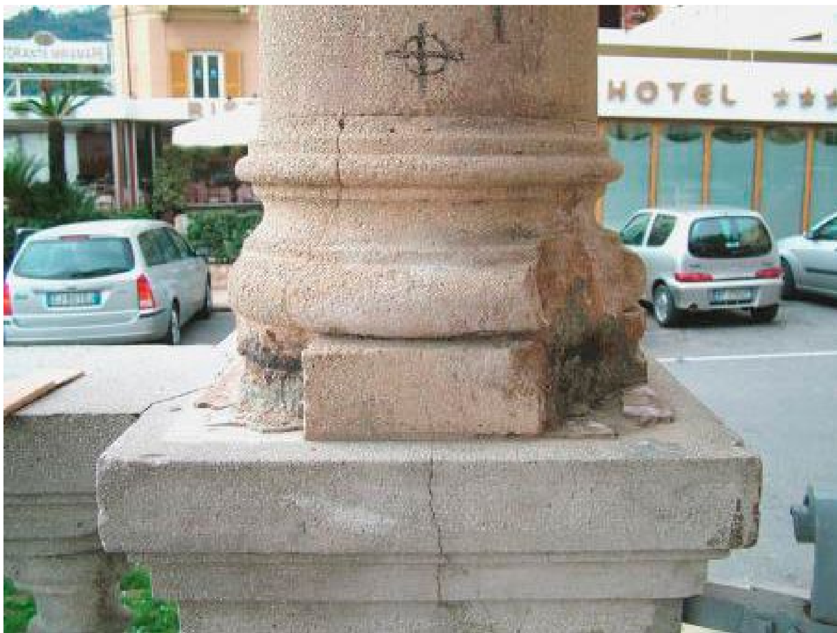
Figura 15 • Mancanze in un basamento in pietra artificiale.
