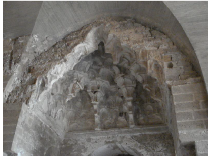
Particolare della murquana , e della ricostruzione della volta in cemento armato.
