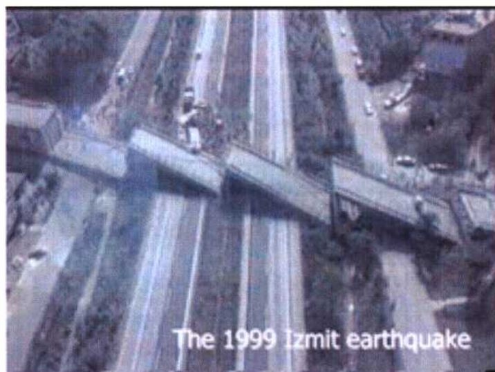
Ponte crollato durante il terremoto di Izmit, Turchia (1999)
