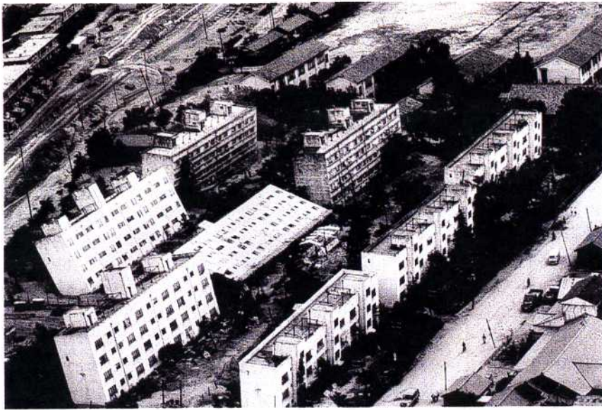
Effetti dovuti alla liquefazione del terreno
