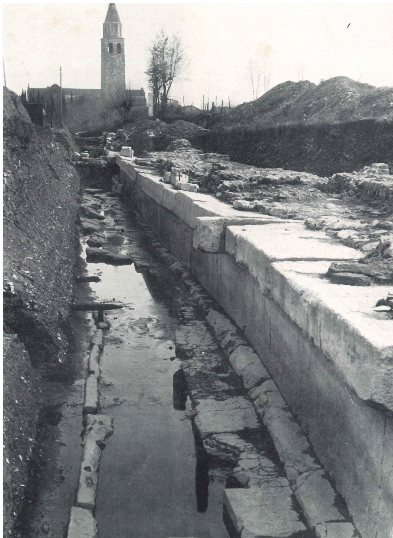
Foto 1 – Porto romano, lavori di scavo.
