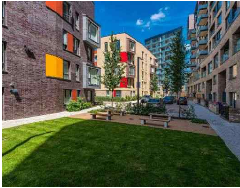
Vista strada pedonale interna
