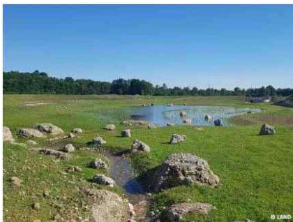
Area umida permanente all'interno della prima vasca di laminazione
