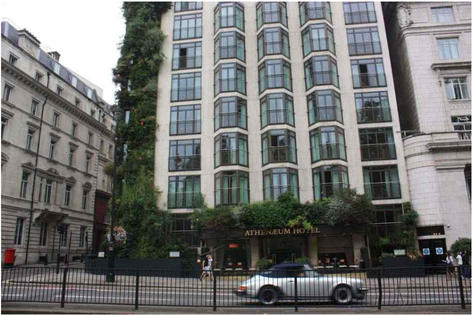
Esempio di inverdimento delle facciate, Athenaeum Hotel (foto di Katia Perini)
