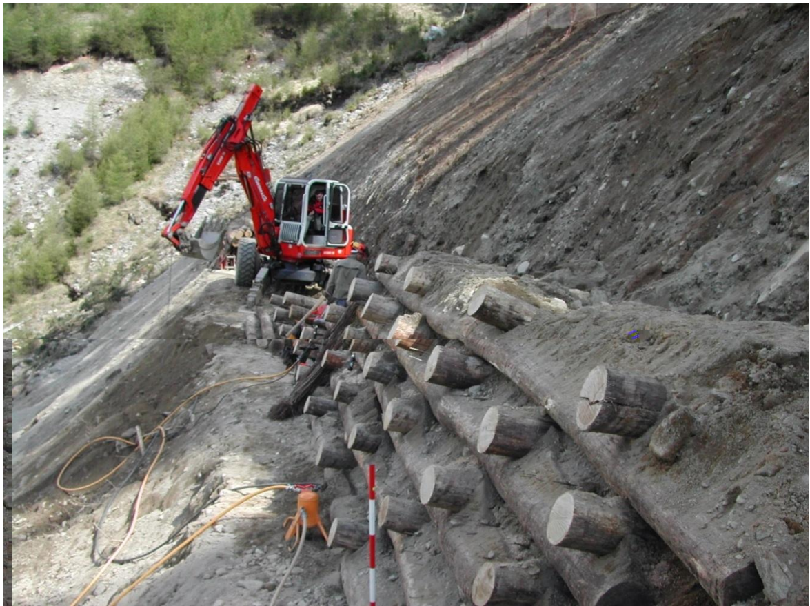
Foto 2 - Intervento su frana con palificata viva di sostegno.
