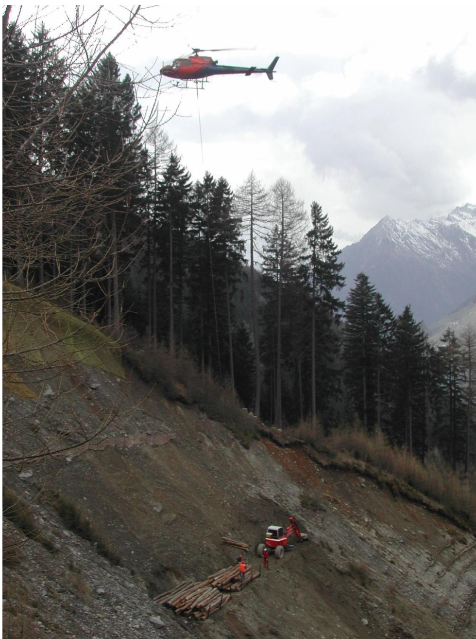
Foto 1 - Intervento su frana con palificata viva di sostegno.
