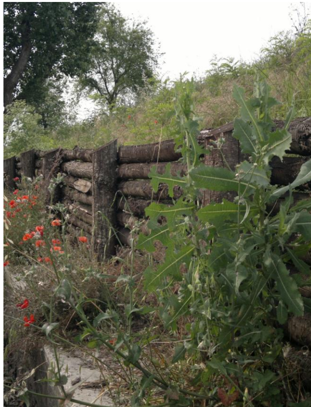
Foto 4 - Palizzata morta con funzionalità di barriera, realizzata alla via di decima EUR - Roma (RM) - 2011.
