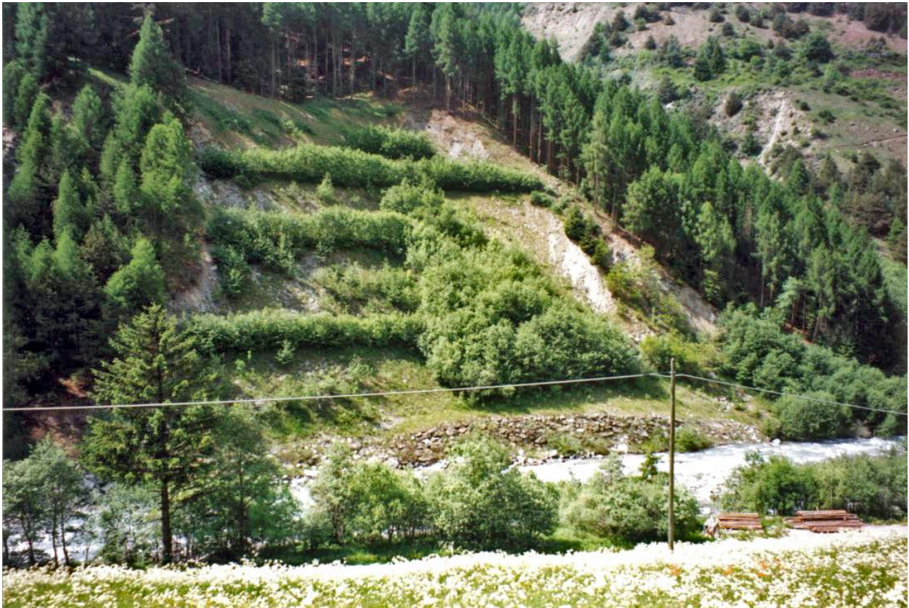
Foto 6 - Gradonate viva di sostegno in Val Solda (BZ) - 2000.
