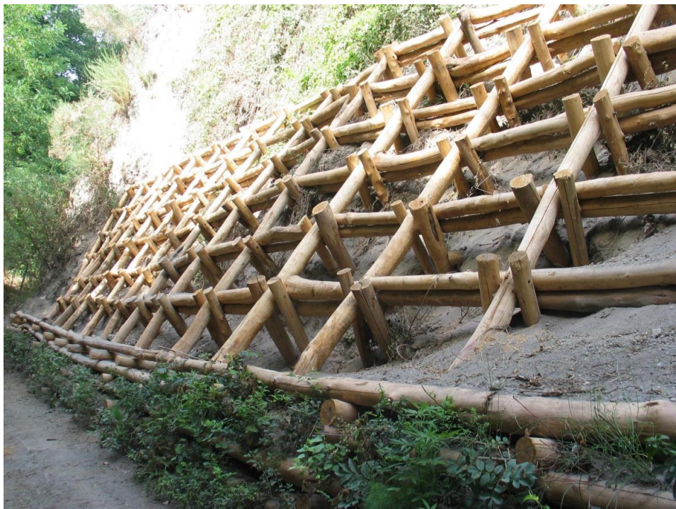
Foto 11 e 12 - Esempi di Grata Vesuvio in fase di esecuzione.
