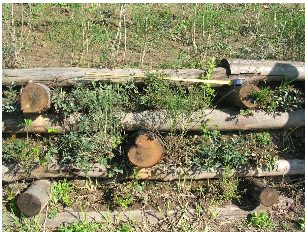
Foto 31 - Palificata viva di sostegno
