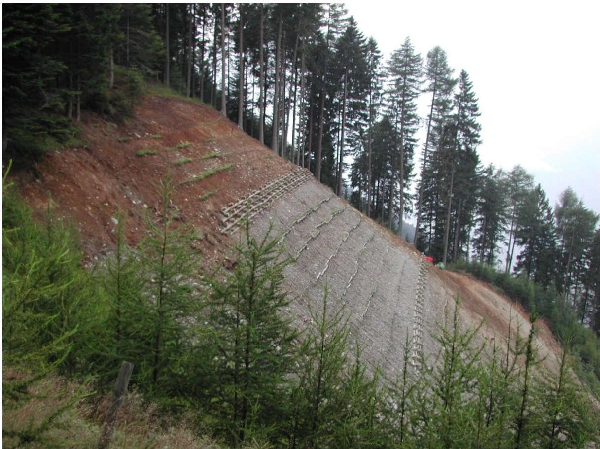
Foto 3 - Intervento su frana con palificata viva di sostegno a fine lavori.
