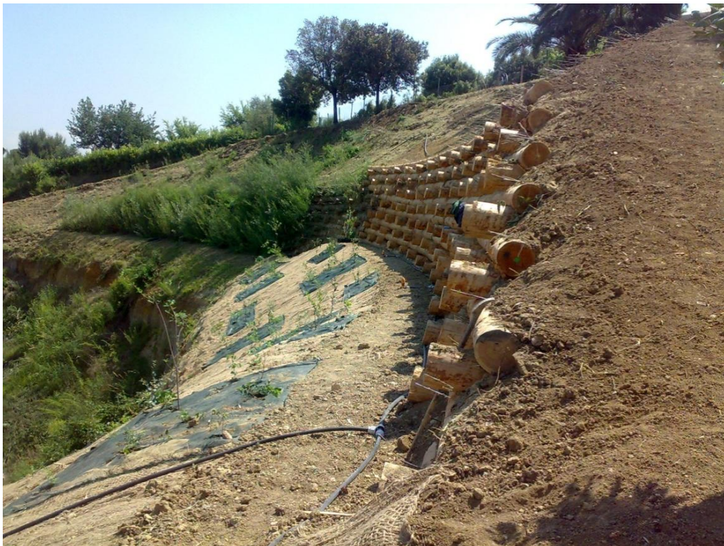
Foto 18 - Palificata viva di sostegno a parete doppia - a lavorazione ultimata - Roma Ss. Protomartiri - 2011.
