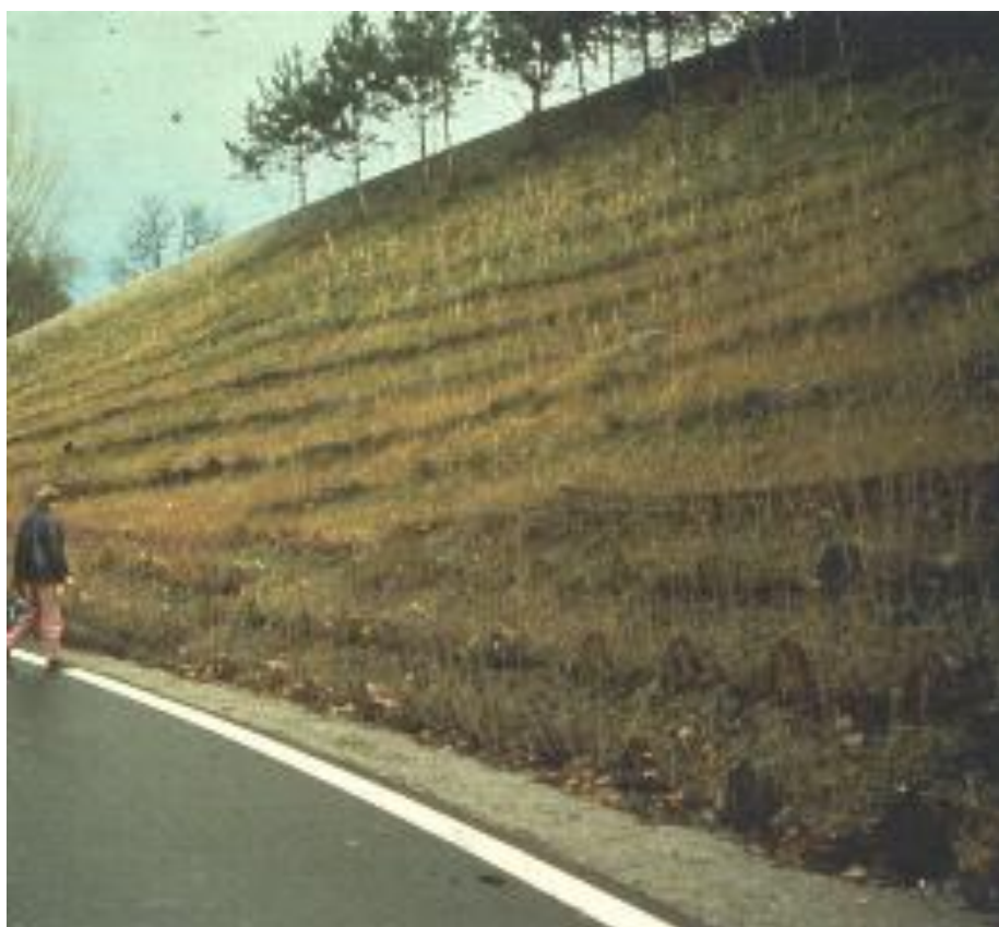
Foto 7 - Gradonata su un tratto stradale.
