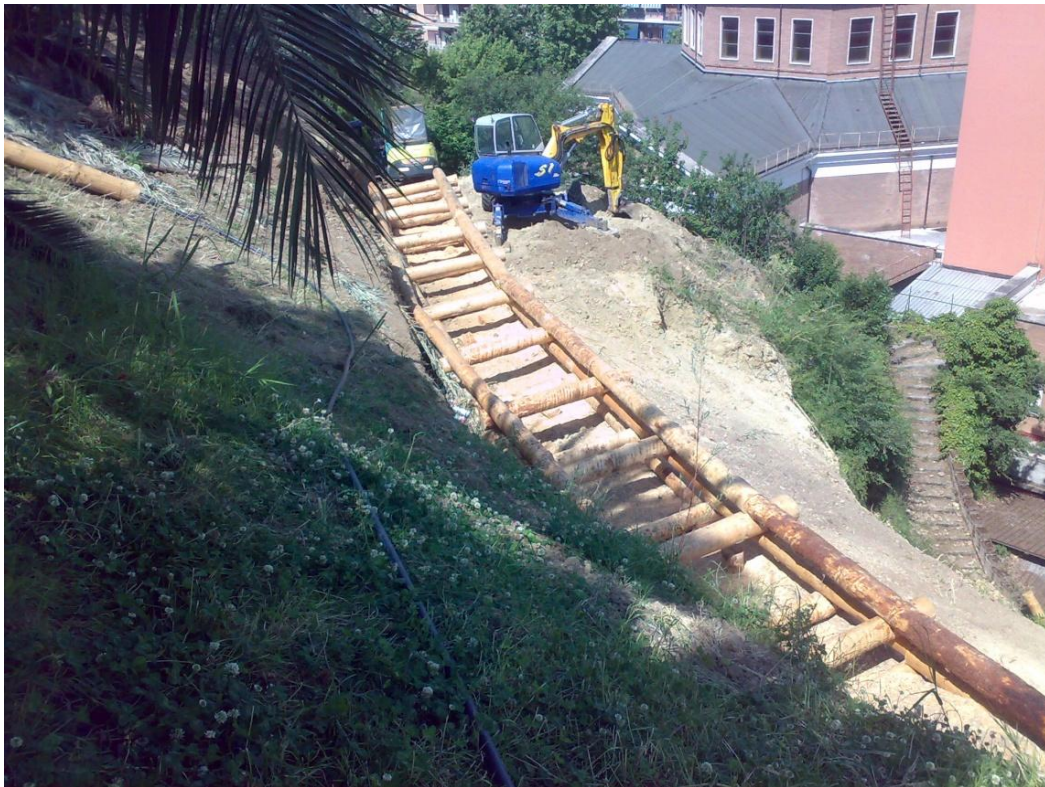
Foto 17 - Palificata viva di sostegno a parete doppia - in costruzione - Roma SS.Protomartiri - 2011.
