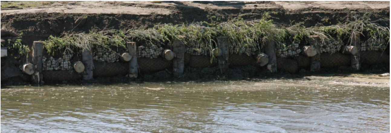
Foto 32 - Palificata spondale viva - Località Ca' Vendramin (RO).
