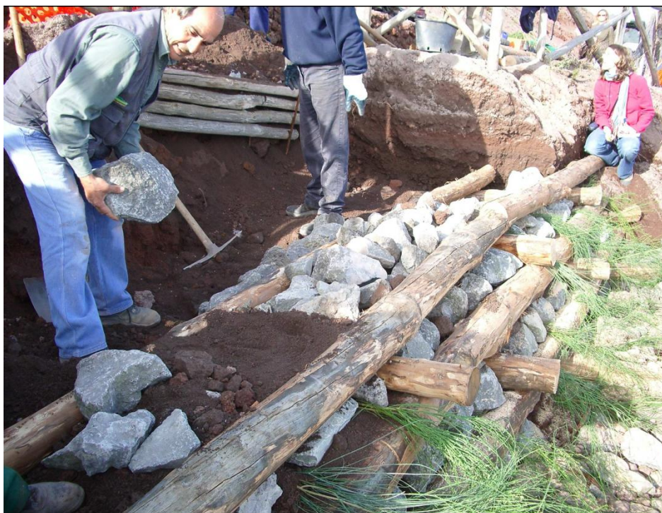
Foto 19 - Realizzazione di una palificata di sostegno a parete doppia - Vesuvio (NA) - 2004.
