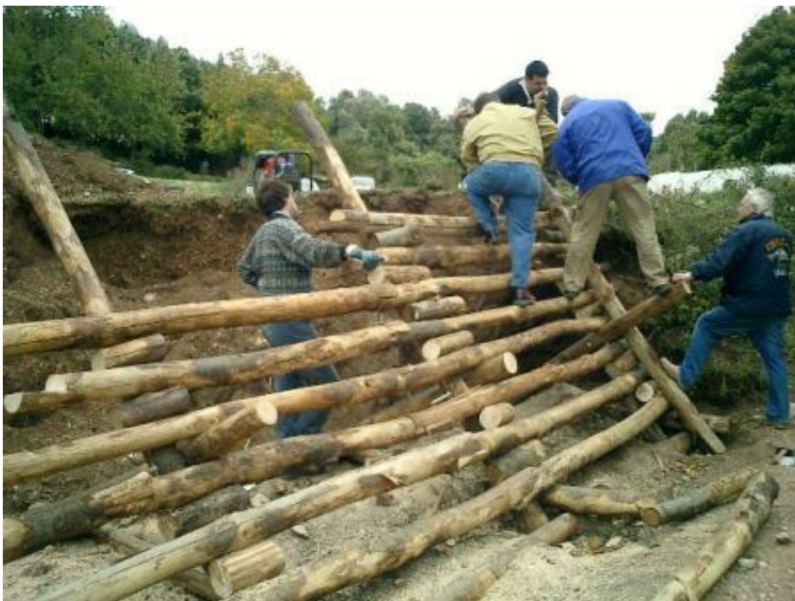
Foto 20 - Realizzazione di una palificata viva di sostegno tipo Roma.
