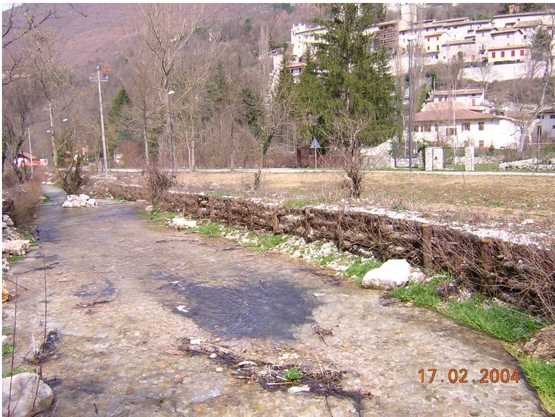
Foto 25 - Palificata spondale con palo verticale frontale - Castel S. Angelo sul Nera - 2004.
