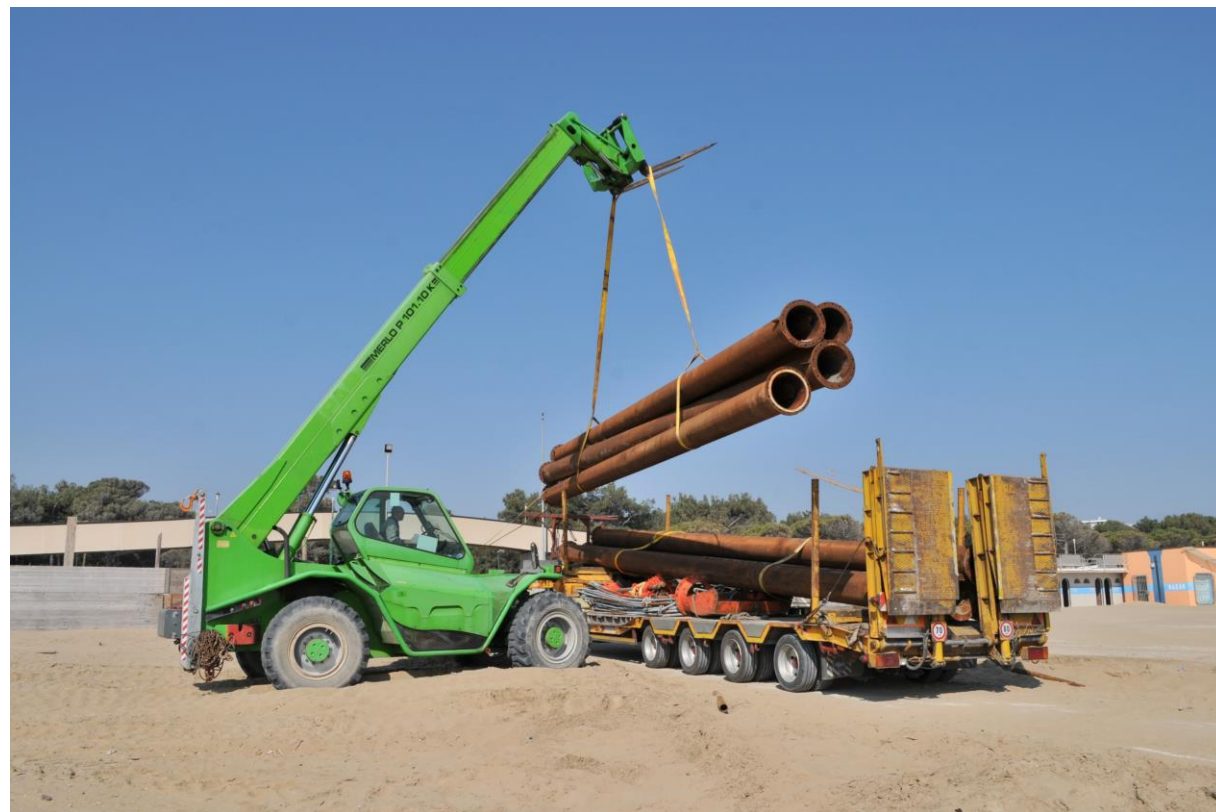
Posizionamento dell'attrezzatura in zona baricentrica all' area d'intervento
