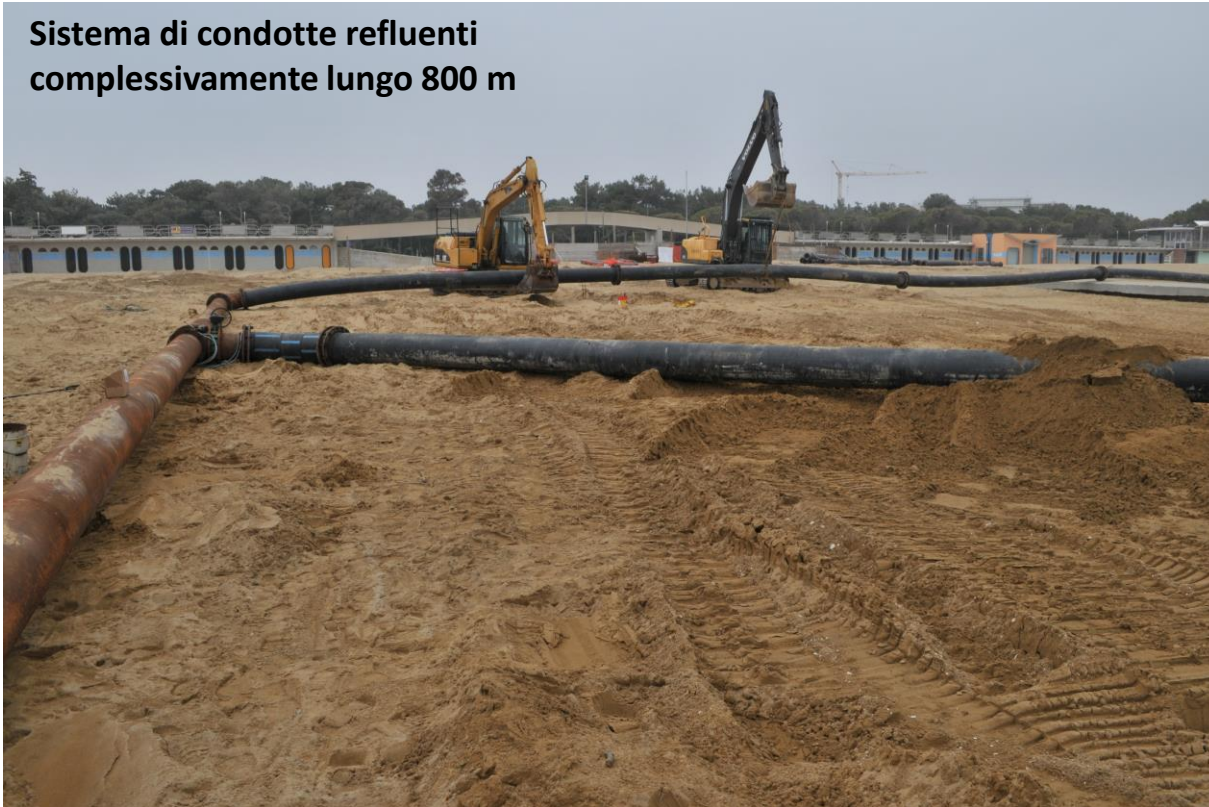
Allestimento condotta a terra
