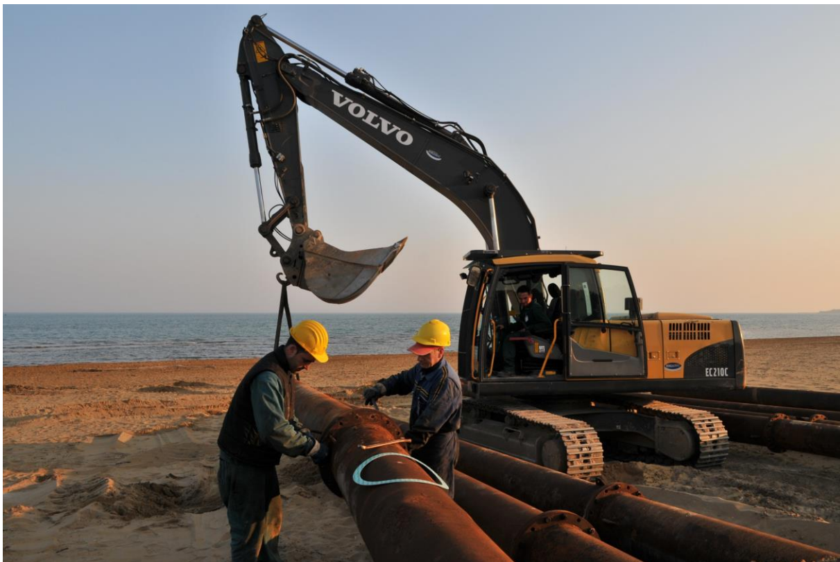
Assemblaggio condotta refluyente Ø400
