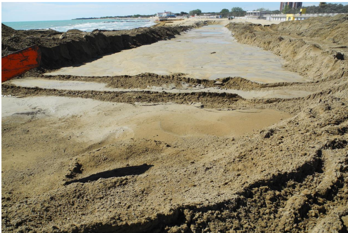
Riempimento e rialzamento argini perimetrali vasca
