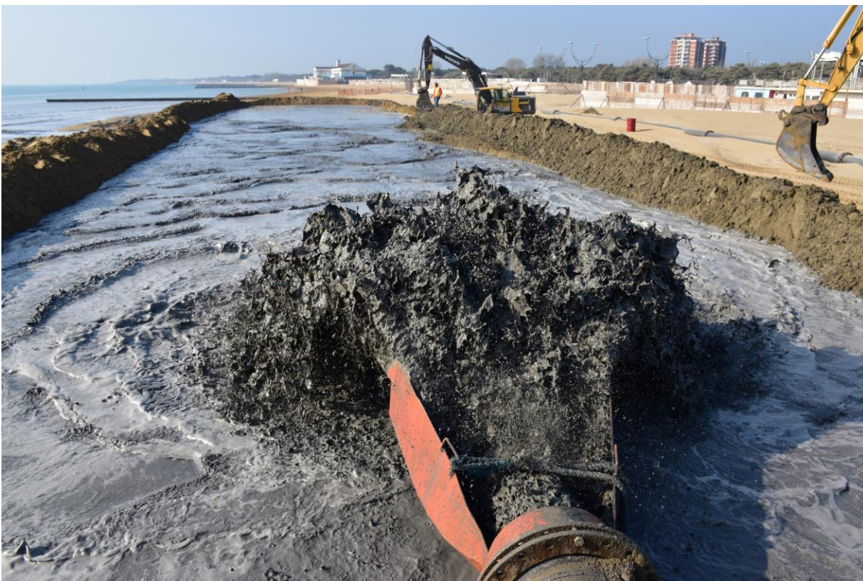
Refluimento mediante diffusore a becco d'anatra
