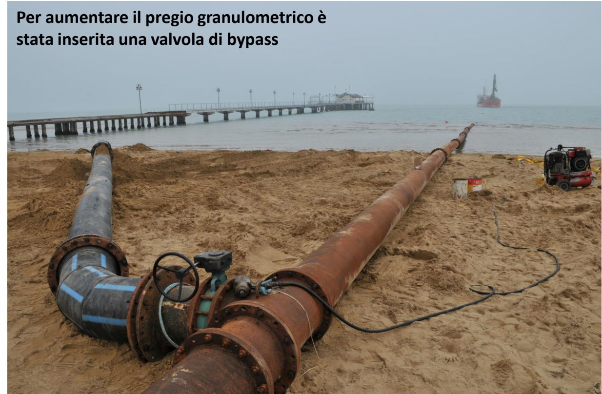
Inserimento valvola di by-pass
