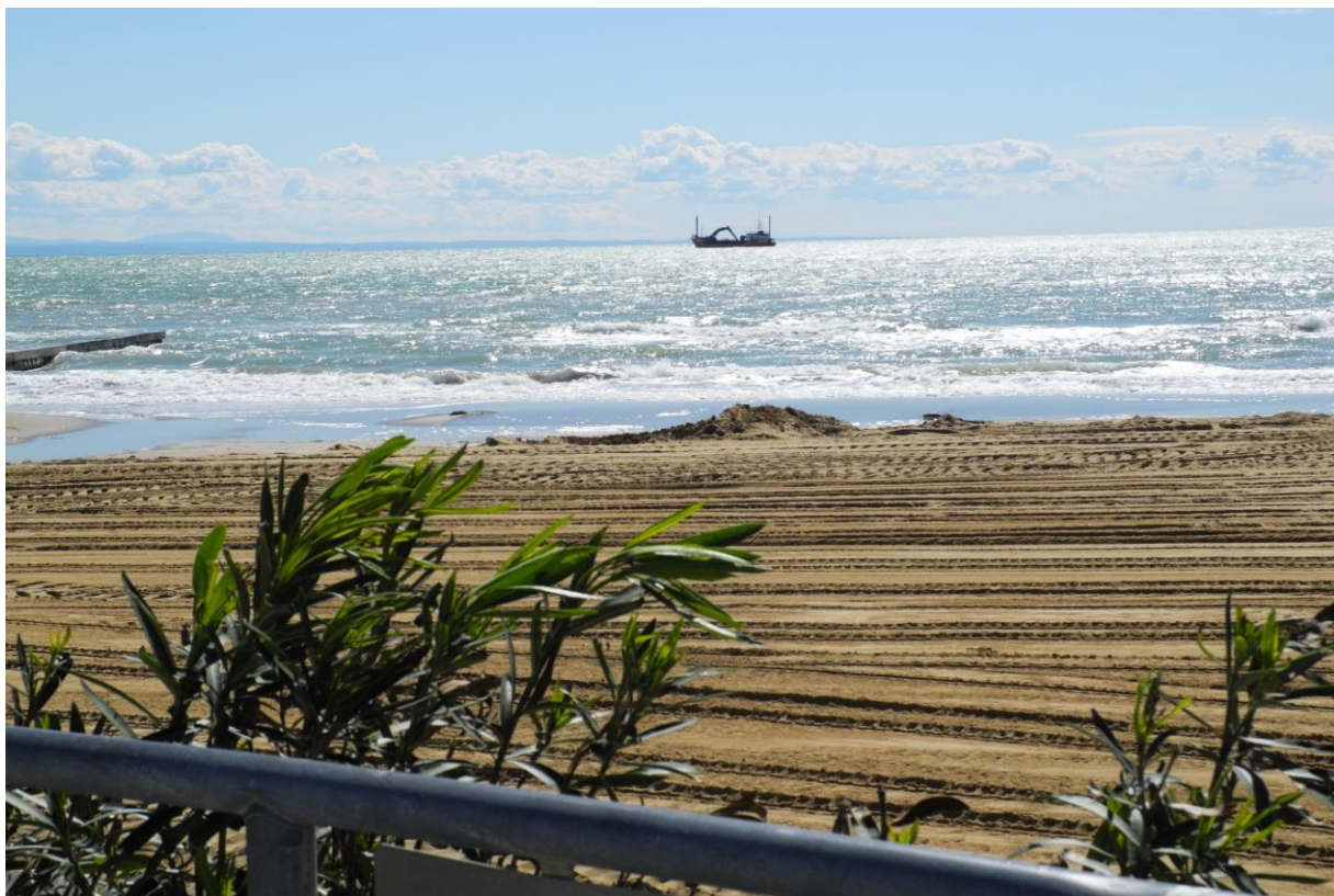
Trasporto materiale sabbioso dalla foce alla zona da ripascere
