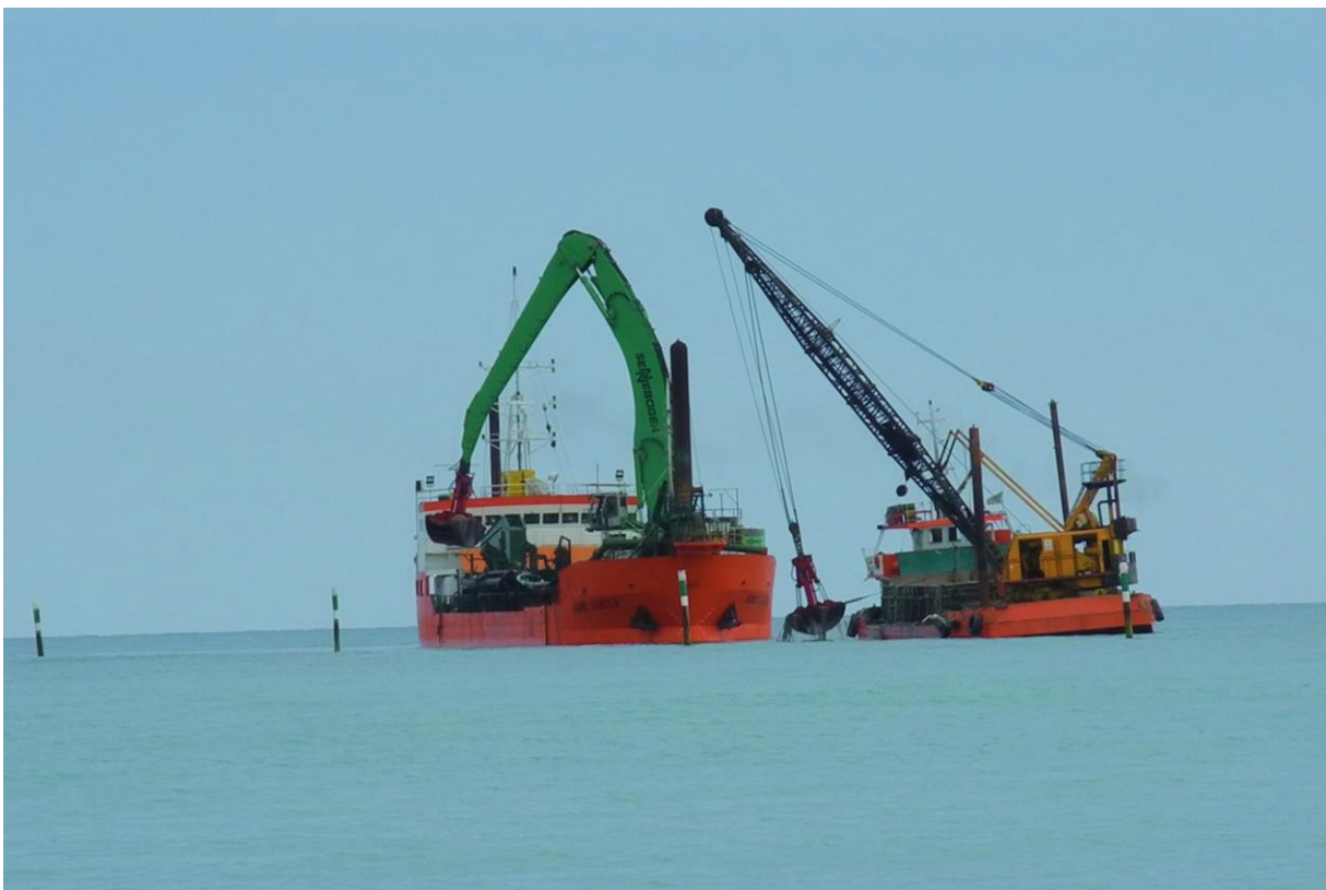
Dragaggio TSHD e pontone
