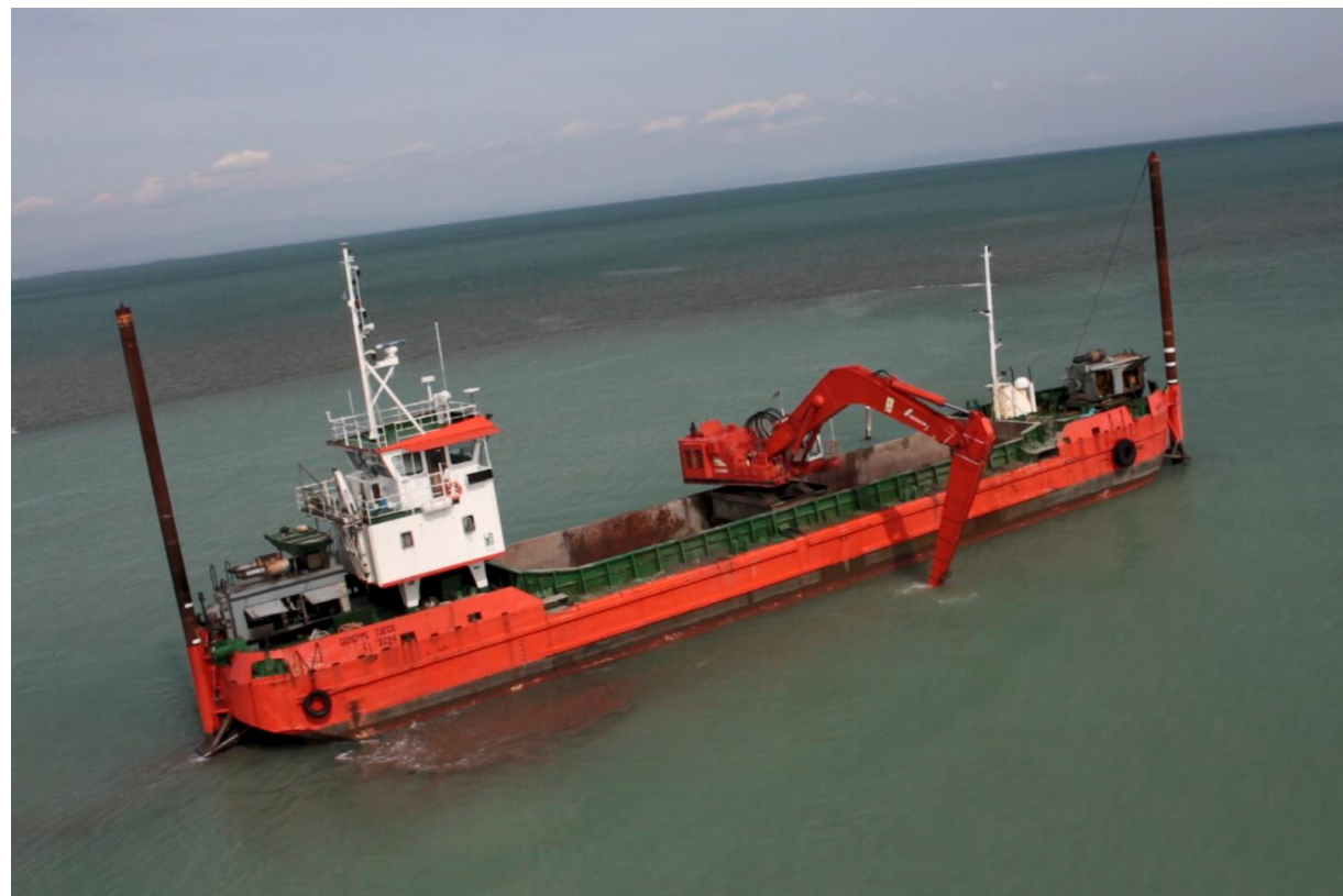
Dragaggio bettolina con escavatore idraulico
