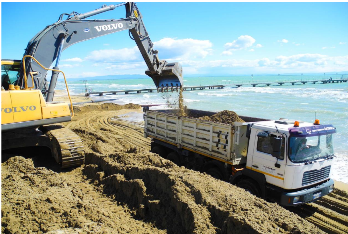
Trasferimento su camion da cumulo a varie zone arenile
