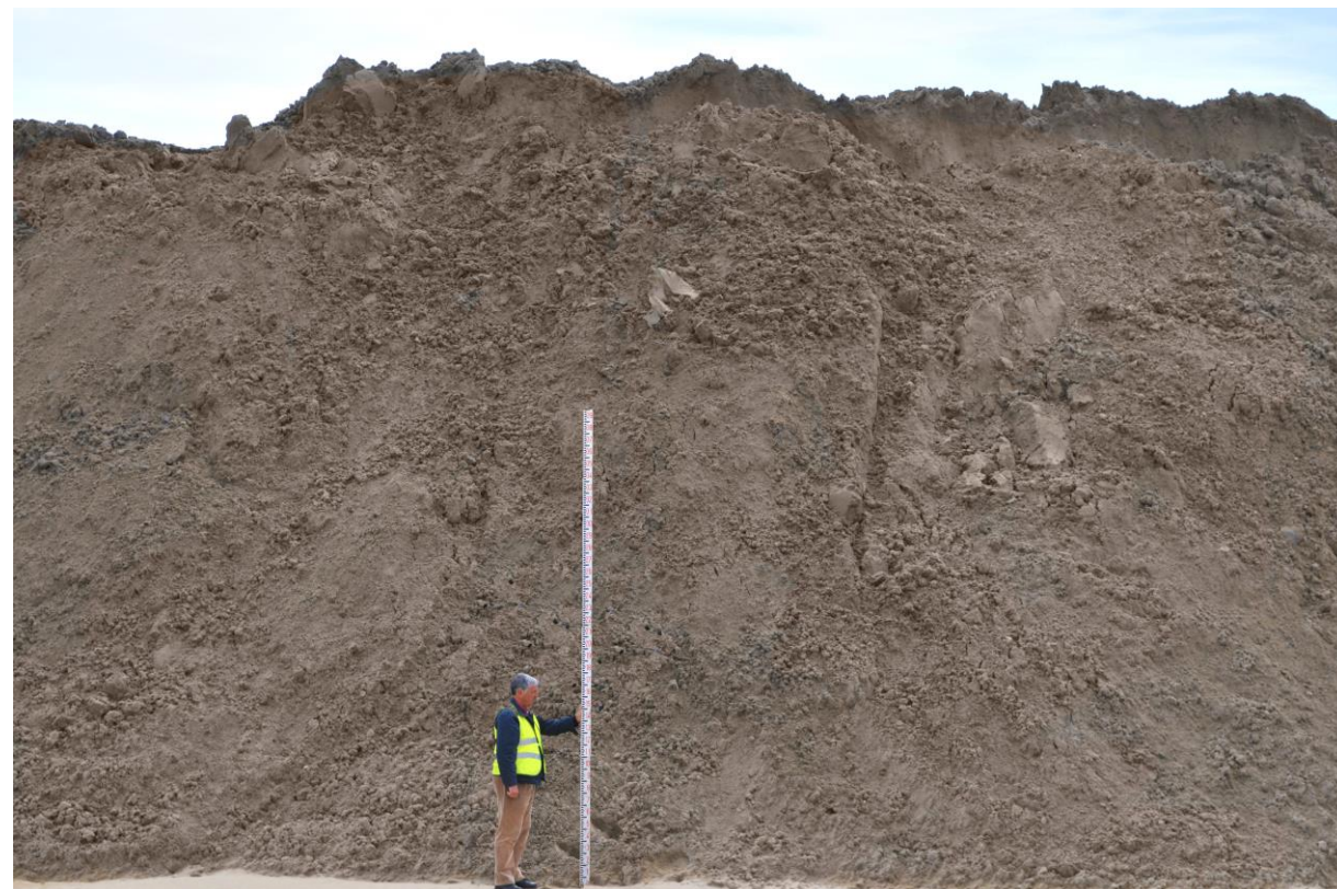
Ripresa materiale e formazione cumuli ( h_{\max} = 10 \text{ m} )
