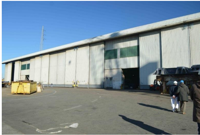
Figura 120. Capannette di Pitturazione – Fabbricato
