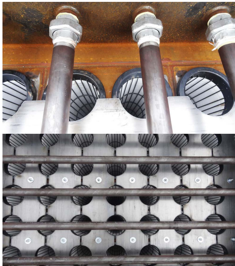
Figura 61 Sistemi di pulizia delle maniche
