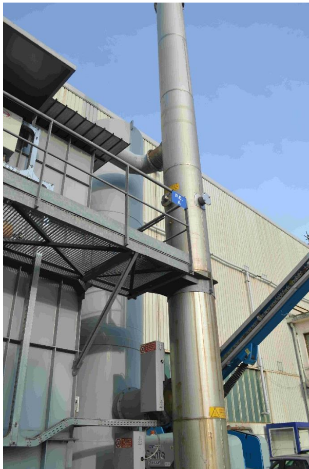
Figura 5 Punto di prelievo su condotto verticale
