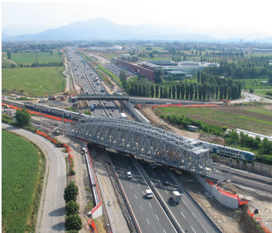
Figura 4.11.1 – Veduta dei due ponti ferroviari.
