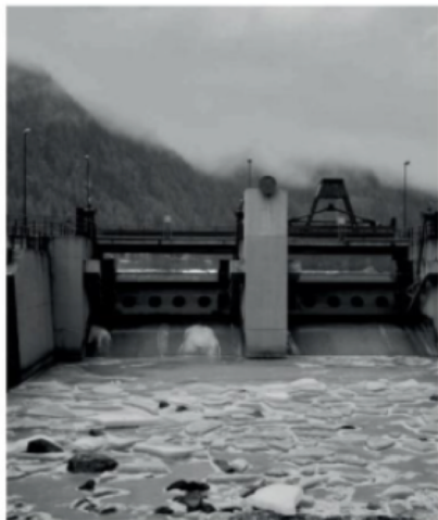
Impianto mini idroelettrico di Val di Vizze.
